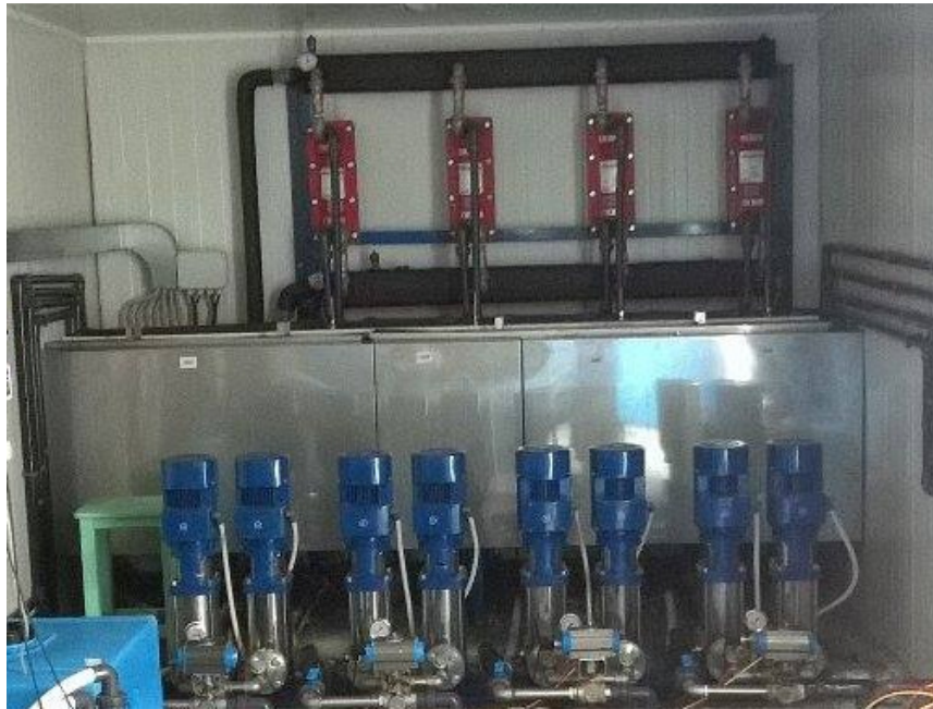
Εικόνα 4.4: δεξαμενές αποθήκευσης αραιού θρεπτικού διαλύματος- έλεγχος της θερμοκρασίας- αντλίες παροχής
