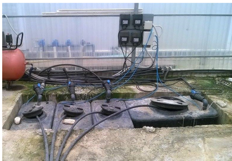
Εικόνα 4.5: Δεξαμενές απορροής του θρεπτικού διαλύματος
