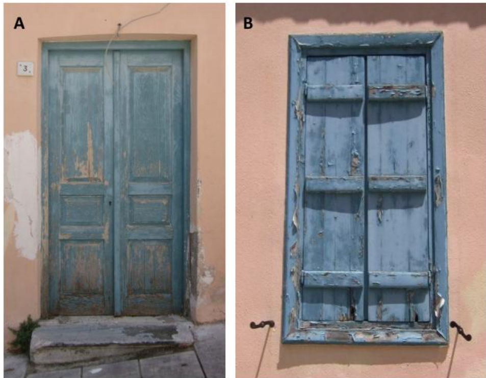
Εικόνα 50. Α. Ταμπλαδωτή εξώθυρα επί της οδού Κλεψύδρας, κτήριο Β΄. Κούφωμα κτήριο Β΄. Πηγή : Φωτογραφίες από τους ίδιους τους συγγραφείς
