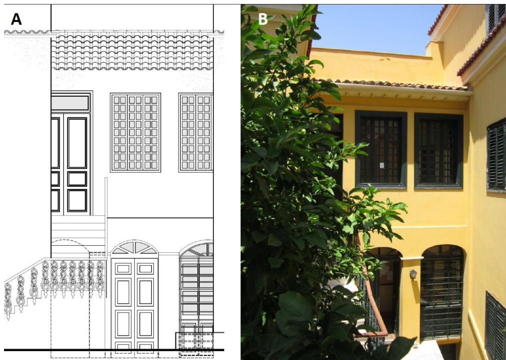
Εικόνα 47. Α. Αρχιτεκτονική αποτύπωση της νότιας όψης του κτηρίου Α', λεπτομέρεια. Διακρίνεται το κλειστό χαγιάτι. Πηγή : Αρχιτεκτονική αποτύπωση από τους ίδιους τους συγγραφείς Β. Το κλειστό χαγιάτι της νότιας όψης του κτηρίου Α'. Πηγή : Φωτογραφίες από τους ίδιους τους συγγραφείς
