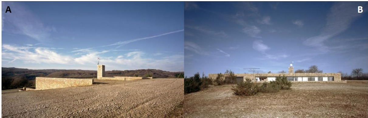
Εικόνα 31. Α. Η βόρεια, “θαμμένη” όψη του κτηρίου, Β. Η νότια όψη του κτηρίου.
