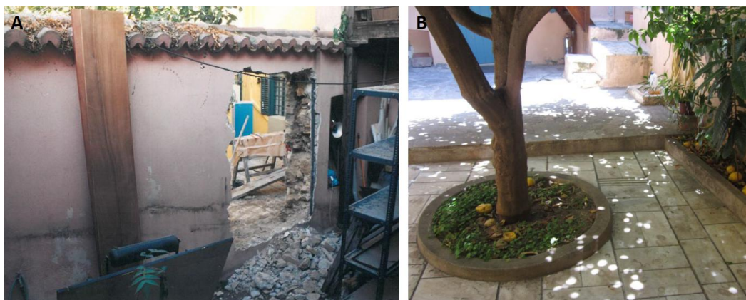
Εικόνα 57. Α. Η καθαίρεση του ενδιάμεσου τοίχου που χώριζε τις δύο ιδιοκτησίες. Β. Η υψομετρική διαφορά που υπάρχει σήμερα στο σημείο που βρισκόταν ο τοίχος.
