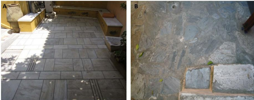
Εικόνα 56. A. Η μαρμάρινη πλακόστρωση που καταλαμβάνει το μεγαλύτερο μέρος της εσωτερικής αυλής. B. Η πέτρινη πλακόστρωση που βρίσκεται στο μέρος της αυλής που ανήκε παλιά στο κτήριο B'. Πηγή : Φωτογραφίες από τους ίδιους τους συγγραφείς
