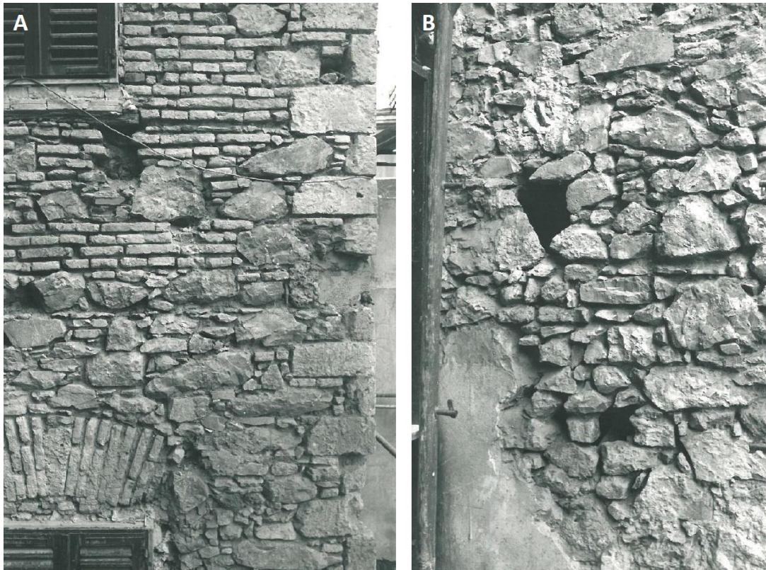
Εικόνα 51. Α, Β. Η φέρουσα τοιχοποιία του κτηρίου Α. Πηγή: Αρχείο ΥΝΜΤΕ
