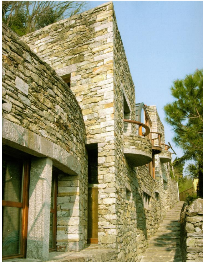
Εικόνα 26. Η κατοικία έχει κτιστεί πάνω σε ήδη υπάρχουσα ξερολιθιά.
