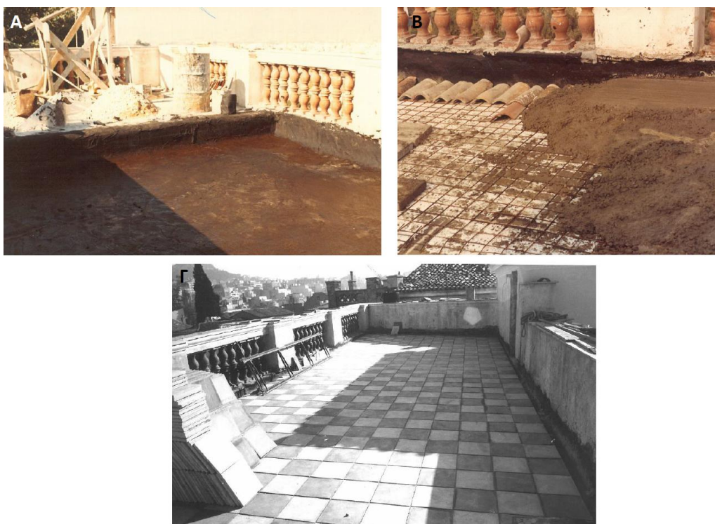
Εικόνα 54. Εργασίες αποκατάστασης του δώματος. Προσθήκη μόνωσης και πλακόστρωσης. Πηγή : Αρχείο ΥΝΜΤΕ
