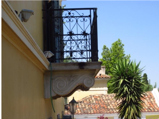
Εικόνα 46. Λεπτομέρεια του εξώστη που βρίσκεται στην όψη της οδού Λυσίου. Διακρίνονται τα μαρμάρια φουρούσια καθώς και τα μεταλλικά κιγκλιδώματα. Πηγή : Φωτογραφίες από τους ίδιους τους συγγραφείς
