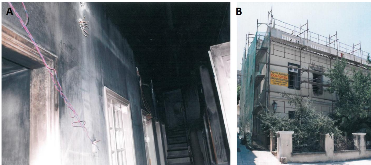
Εικόνα 42. Α. Άποψη του εσωτερικού του κτηρίου Α' μετά την πυρκαγιά που εκδηλώθηκε το 1999. Β. Οι εργασίες μερικής αποκατάστασης που πραγματοποιήθηκαν στο κτήριο Α' το 1999.
