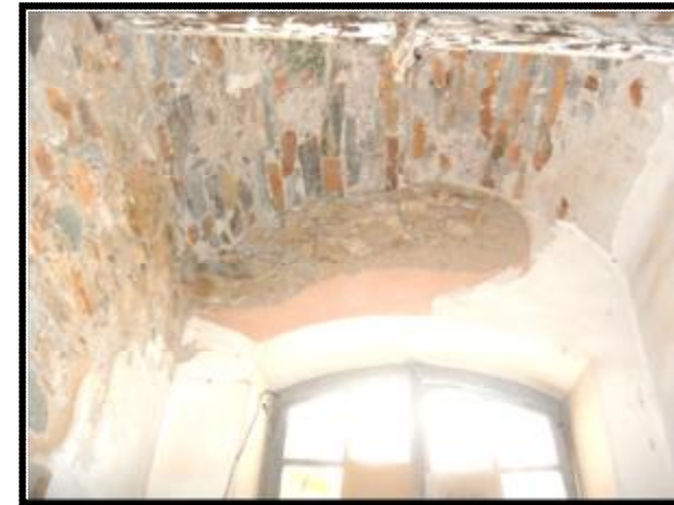
Εικόνα 24: Καθαίρεση ξύλινων στοιχείων, λόγω γήρανσης και που πιθανόν να έχουν προσβληθεί από μύκητες ή ξυλοφάγα έντομα ή λόγω υγρασίας.
