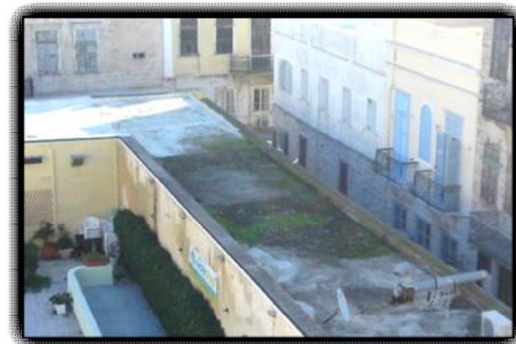
Εικόνα 26: Κατάσταση δώματος του κτιρίου.
