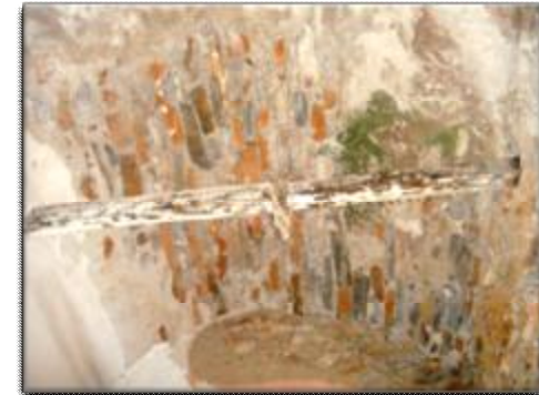
Εικόνα 11: Άνοψη χώρου που δείχνει την τοποθέτηση ξύλινου δοκαριού για την συγκράτηση του κατακόρυφου φέροντα οργανισμού.
