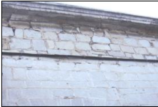
Εικόνα 8: Αποψη αρμολογήματος στις όψεις του κτιρίου.
