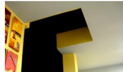
Εικόνα 12: Άνοψη τμήματος βιβλιοπωλείου που δείχνει το φρεάτιο της σκάλας και την τοποθέτηση γυψοσανίδας στο κάτω μέρος του ξύλινου πατώματος.
