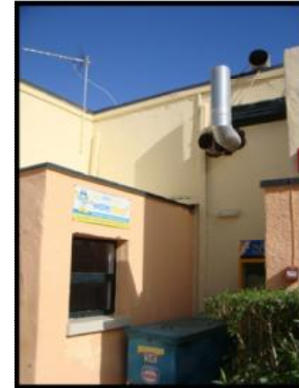
Εικόνα 22: Καθαίρεση αναψυκτηρίου, και Η/Μ εγκαταστάσεων στο χώρο του θερινού κινηματογράφου.
