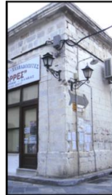
Εικόνα 21: Τοποθέτηση Η/Μ εγκαταστάσεων στις όψεις του κτιρίου.
