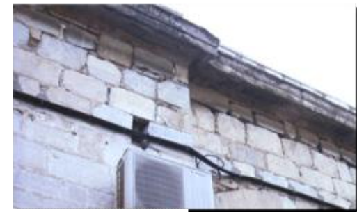
Εικόνα 13: Γείσο περιμετρικά του κτιρίου.
