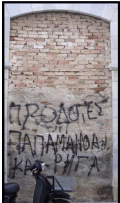
Εικόνα 23: Διάνοξη σφραγισμένων κουφωμάτων.
