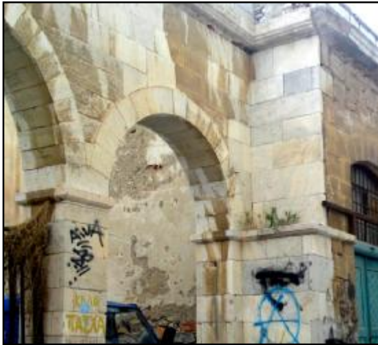
Εικόνα 9: Αποψη αρμολογήματος στο πρότυλο της πίσω όψης του κτιρίου.
