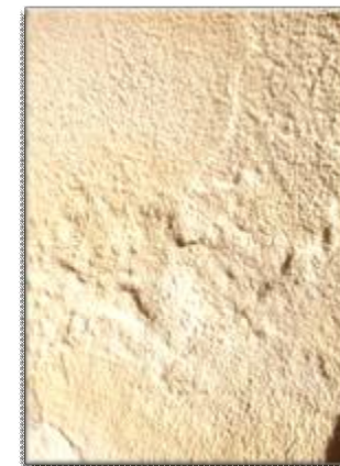
Εικόνα 19: Ασβεστοκονίαμα άγριας υφής στο εσωτερικό της αψίδας που οδηγεί στην αυλή.
