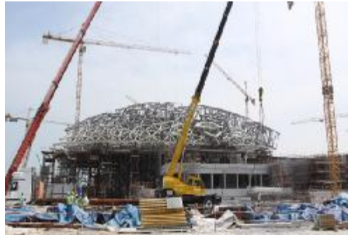
Εικόνα 27: Προπαρασκευασμένα κομμάτια από χάλυβα για την κατασκευή οροφής γηπέδου.
