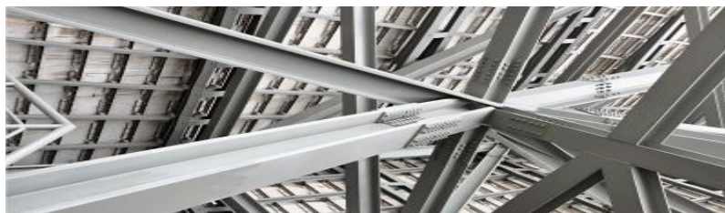
Εικόνα 26: Πολλαπλές ενώσεις χαλύβδινων δοκών τύπου <διπλό ταύ>
