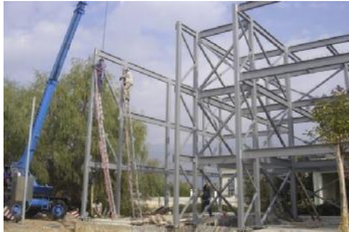
Εικόνα 32: Τοποθέτηση χάλυβα σε κατασκευή
