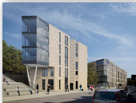
Εικόνα 22: Η εξωτερική άποψη του κτιρίου
