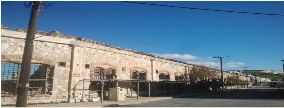
Εικόνα 62: Γενική άποψη της όψης επί του δρόμου από το μικρό σπάσιμο που δημιουργείται στην κάτοψη μέχρι την ανατολική πλευρά.
