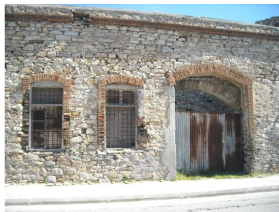
Εικόνα 13: Τοξωτά ανοίγματα με πλαίσια από τούβλα. Δευτερεύον είσοδος στην ανατολική όψη.
