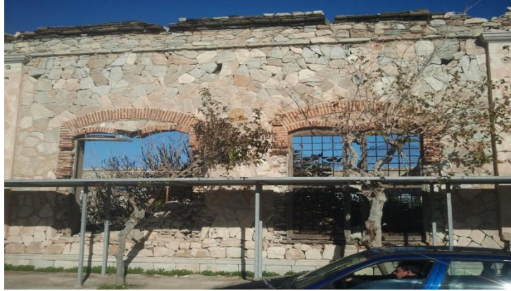
Εικόνα 52: Τοιχοποιία με πολυγωνική λιθοδομή και δίλοβα παράθυρα πλαισιωμένα από τούβλα και προστατευτικές σιδεριές.
