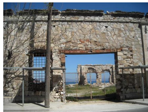
Εικόνα 5: Αρμολογημένη τοιχοποιία νότιας όψης παραθαλάσσιου κτίσματος.
