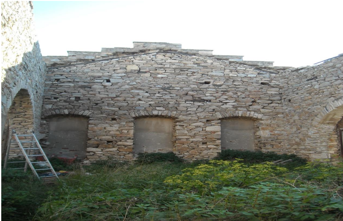
Εικόνα 129: Νότια όψη με κλειστά ανοίγματα .
