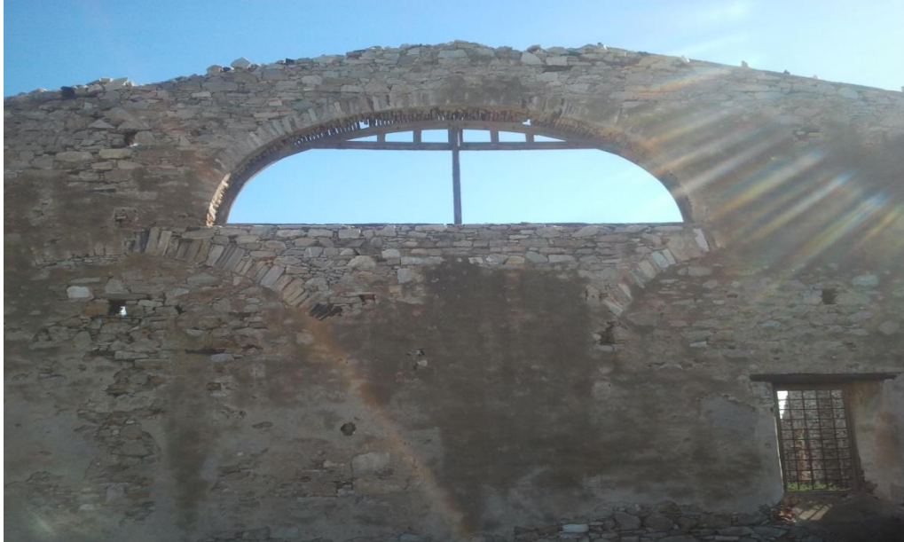
Εικόνα 77: Άνοιγμα ελλειπτικής μορφής στην άνω πλευρά του τοίχου. Σώζεται μόνο το ξύλινο πλαίσιο του.
