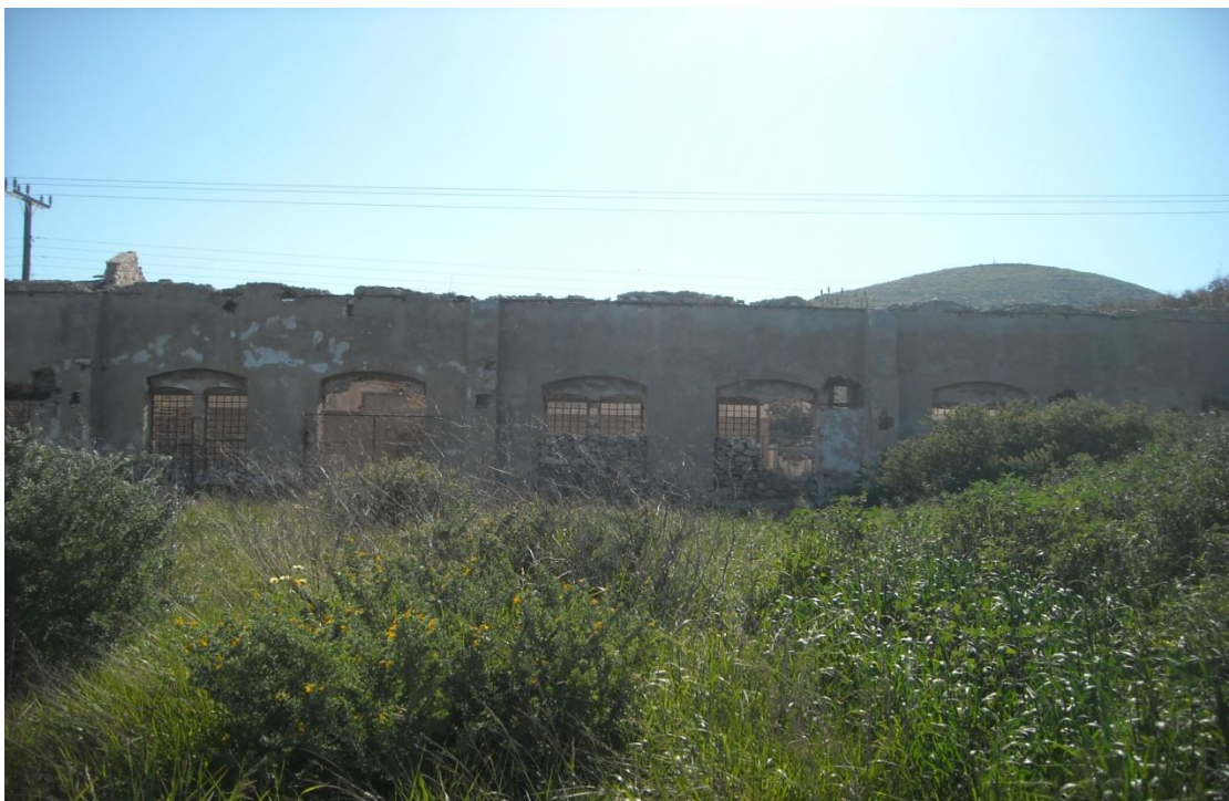
Εικόνα 88: Γενική άποψη νότιου τοίχου.
