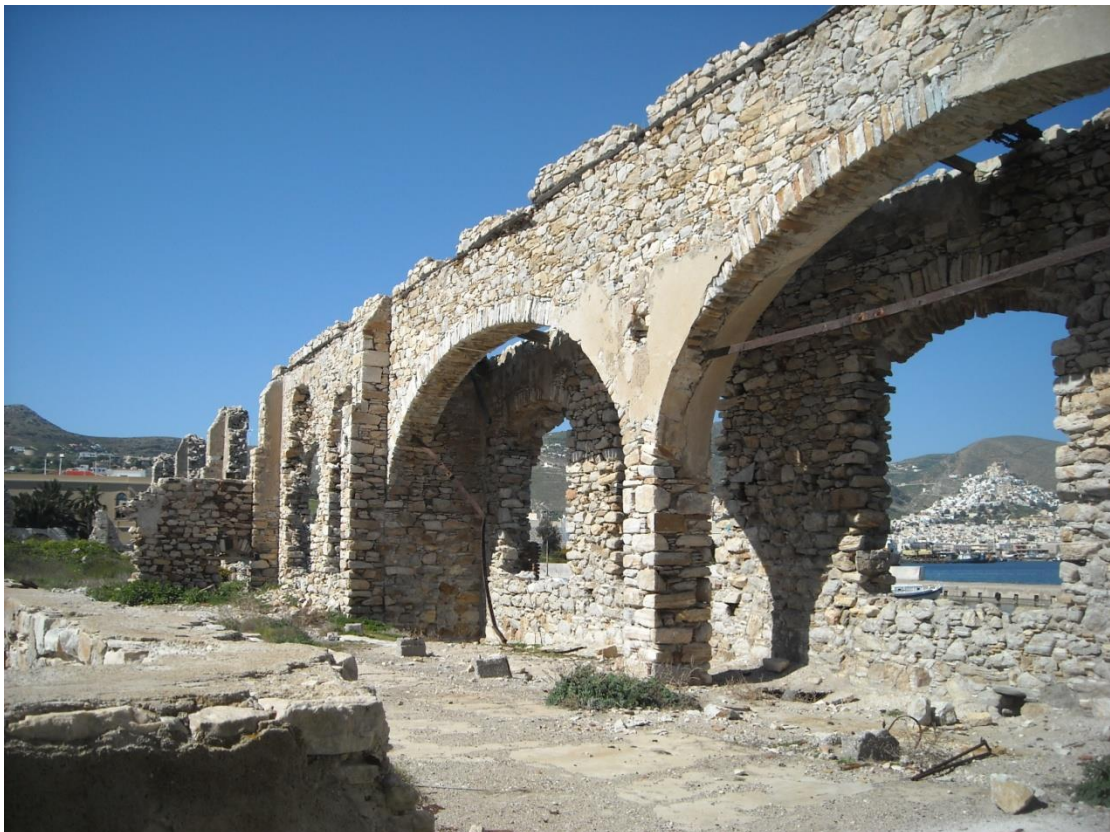
Εικόνα 98: Καμάρες στην βόρεια όψη.
