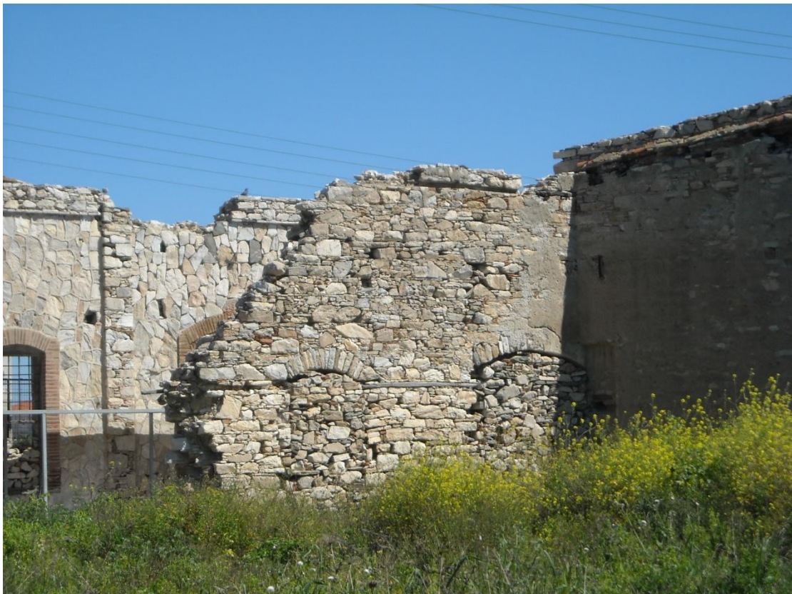
Εικόνα 142: Άποψη βόρειου τοίχου.
