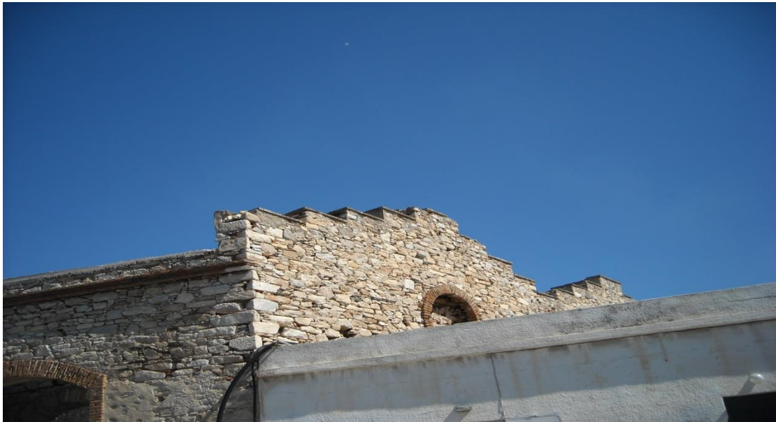
Εικόνα 116: Γενική άποψη επί των γηπέδων. Δυο αετώματα με σπασίματα στην άνω επιφάνεια τους.
