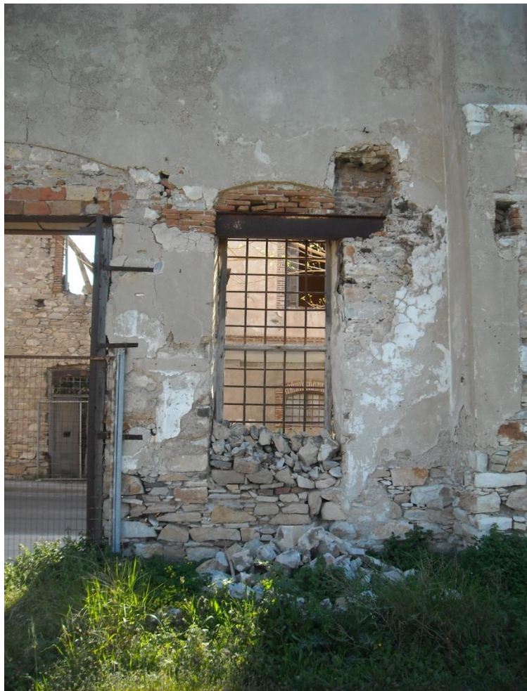
Εικόνα 86: Παράθυρο με προστατευτικές σιδεριές. Αποκόλληση επιχρίσματος και αλλοίωση χρωματισμών.
