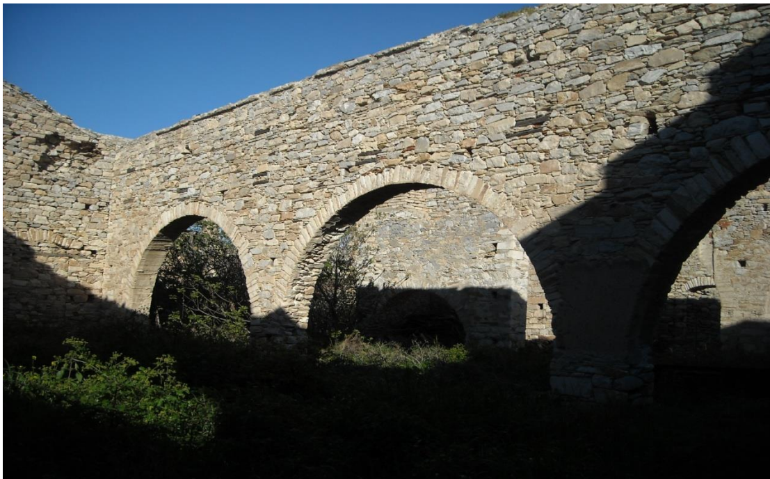
Εικόνα 130: Εσωτερικός τοίχος με καμάρες.
