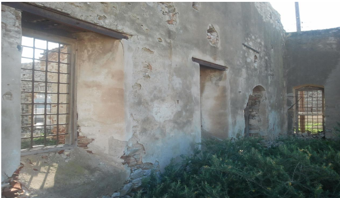
Εικόνα 78: Τρία ανοίγματα με προστατευτικές σιδεριές. Ο τοίχος ήταν επιχρισμένος, αλλά τμήμα του επιχρίσματος έχει αποκολληθεί.
