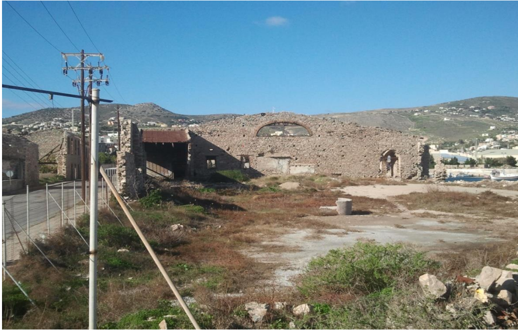
Εικόνα 70: Γενική άποψη διακοσμητικού χωρίσματος.
