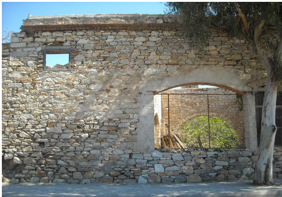
Εικόνα 122: Τοξωτά ανοίγματα που το που χει επιχριστεί η θέση των πλαισίων τους. Εμφανή η ημιλαξευτή λίθοι τους.
