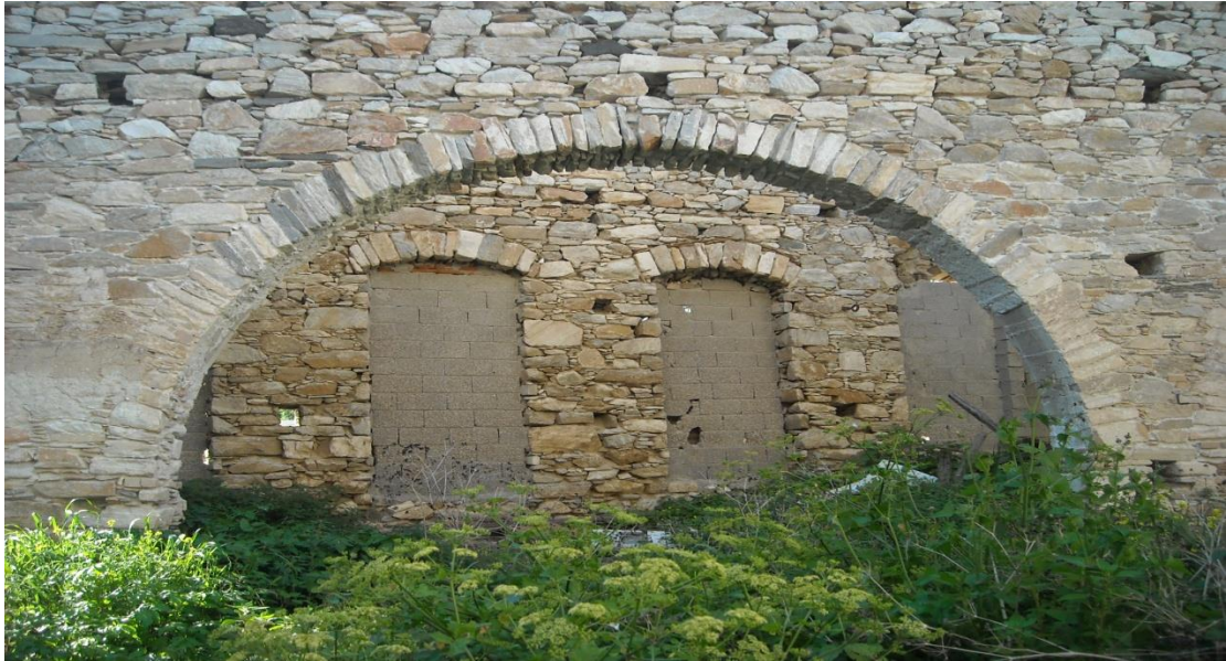
Εικόνα 127: Εσωτερική καμάρα και κλειστά ανοίγματα .
