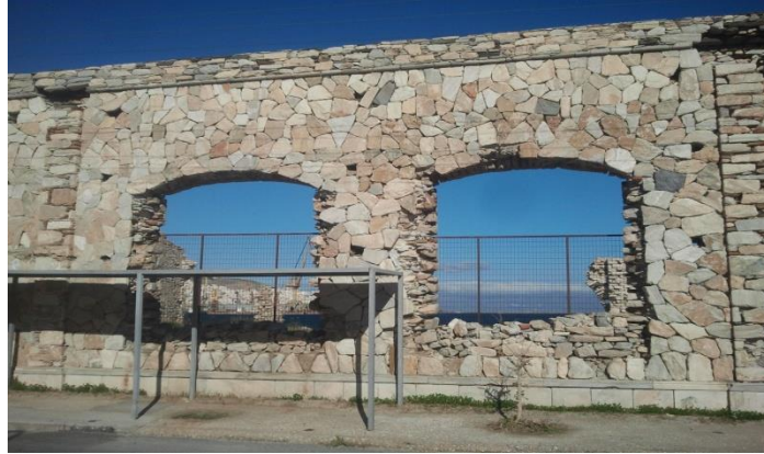
Εικόνα 49: Ανοίγματα στον τοίχο, κλειστά μέχρι κάποιο σημείο. Χτιστό γείσο τρέχει στο άνω μέρος του τοίχου.
