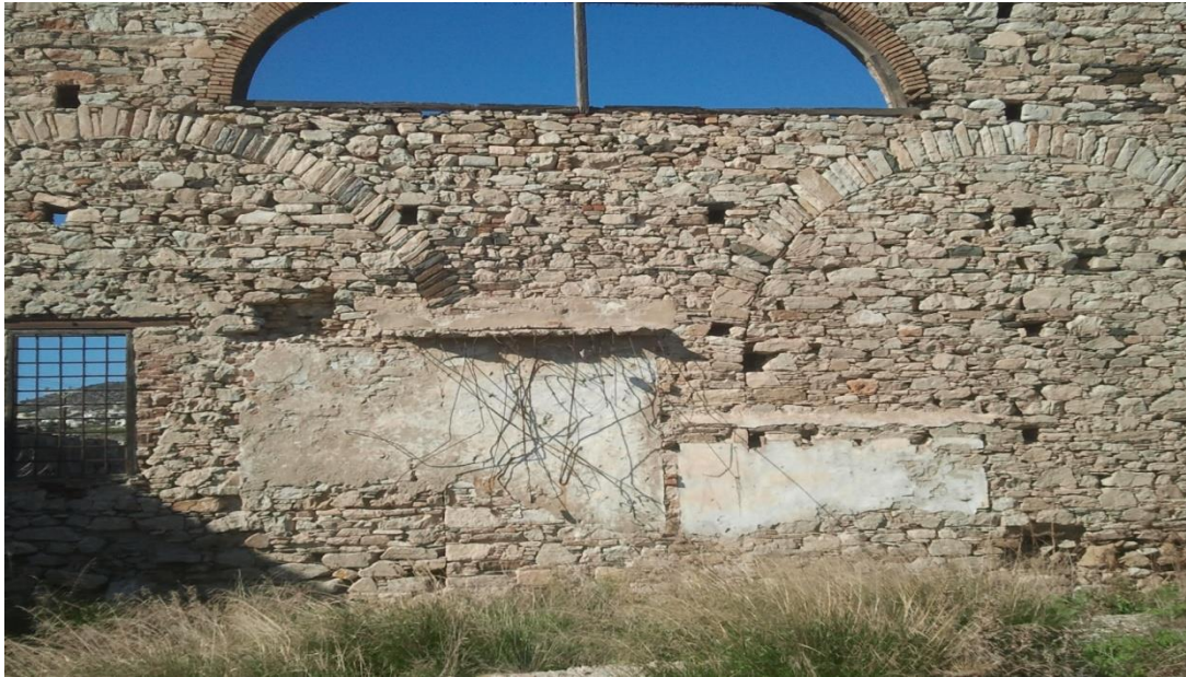
Εικόνα 73: Ίχνη επιχρίσματος από μεταγενέστερη κατασκευή. Κλειστές καμάρες με πλαίσια από πέτρες. Παράθυρα με προστατευτικές σιδεριές
