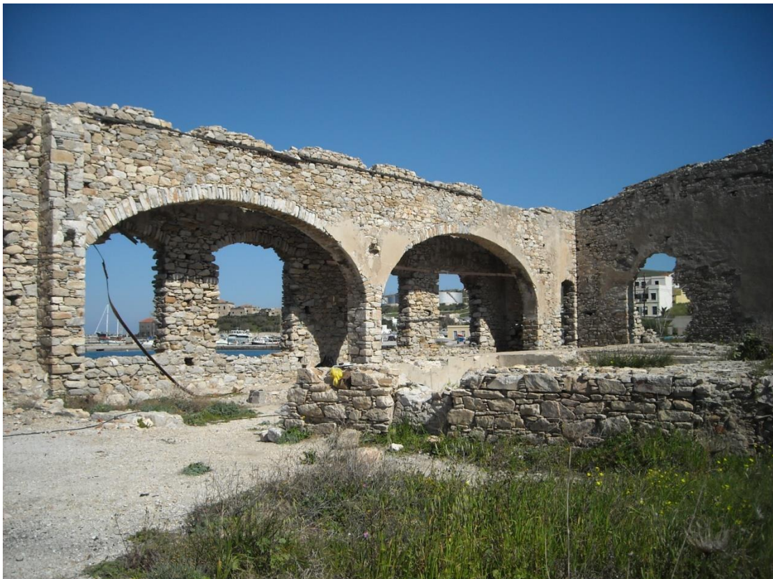
Εικόνα 94: Γενική άποψη καμάρων και δίλοβα ανοίγματα
