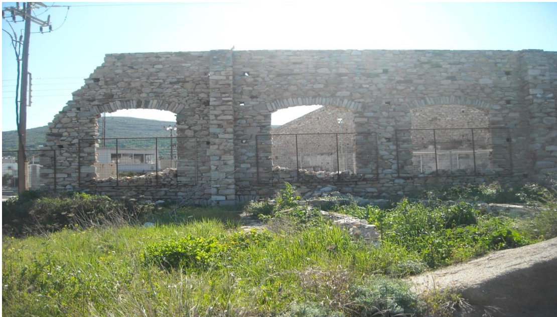
Εικόνα 80: Τοξωτά δίλοβα ανοίγματα, και απουσία προστατευτικών σιδεριών. Εμφανής η ημιλαξευτή λιθοδομή.
