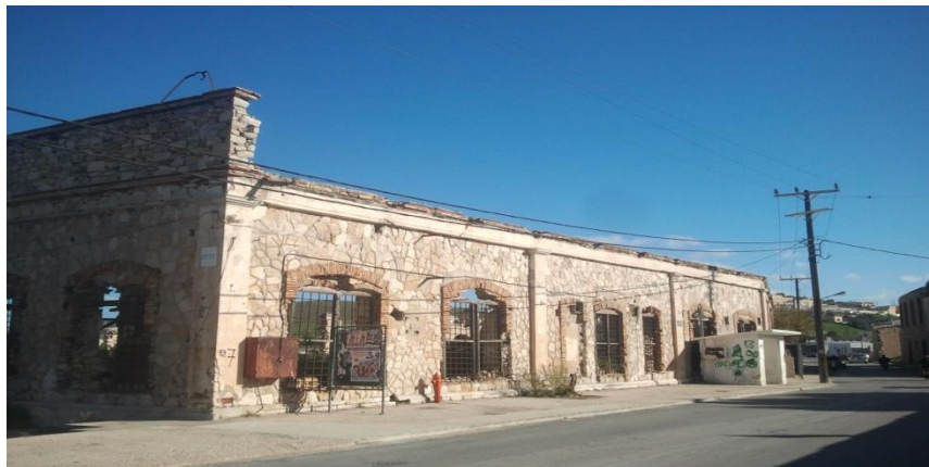
Εικόνα 63: Άποψη της όψης επί του δρόμου στο σημείο που δημιουργείται σπάσιμο
