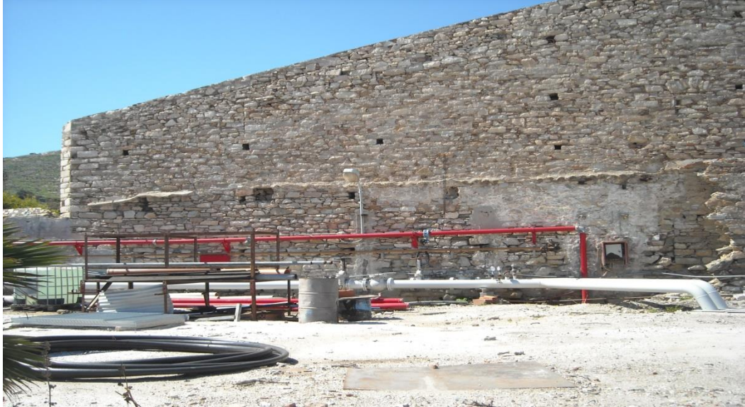
Εικόνα 115: Συνέχεια της πλευράς επί της Δ.Ε.Η. ίχνη επιχρίσματος που έχει αποκολληθεί είναι εμφανές στον τοίχο.
