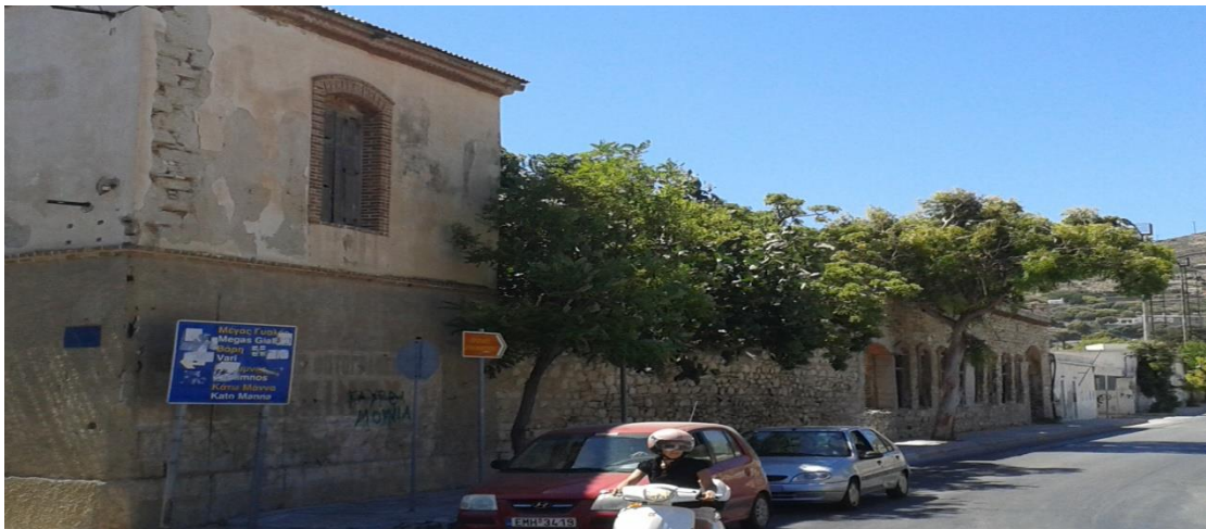
Εικόνα 118: Γενική άποψη της όψης επί της Επαρχιακής οδού Ερμούπολης-Φοινίκων.
