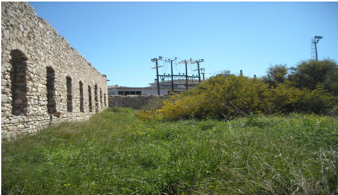
Εικόνα 140: Ανατολικός τοίχος όψη προς τη Δ.Ε.Η.
