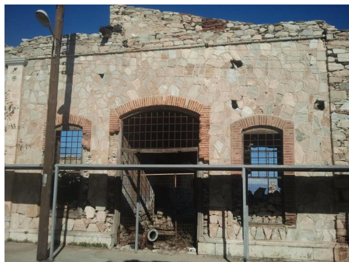
Εικόνα 51: Πόρτα και δυο παράθυρα εκατέρωθεν της με προστατευτικές σιδεριές. Τούβλα πλαισιώνουν τα ανοίγματα
