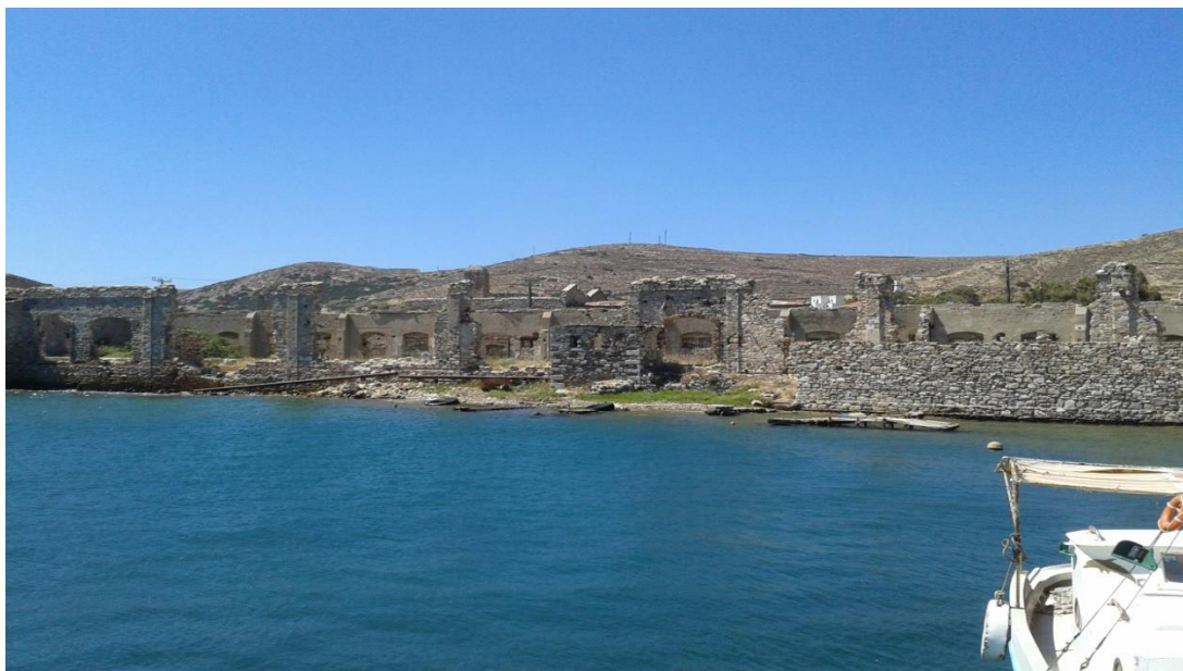
Εικόνα 69 : Γενική άποψη της όψης επί της θάλασσας. Λιθοδομή από διαφορών μεγεθών λίθων σε άτακτη τοποθέτηση.
