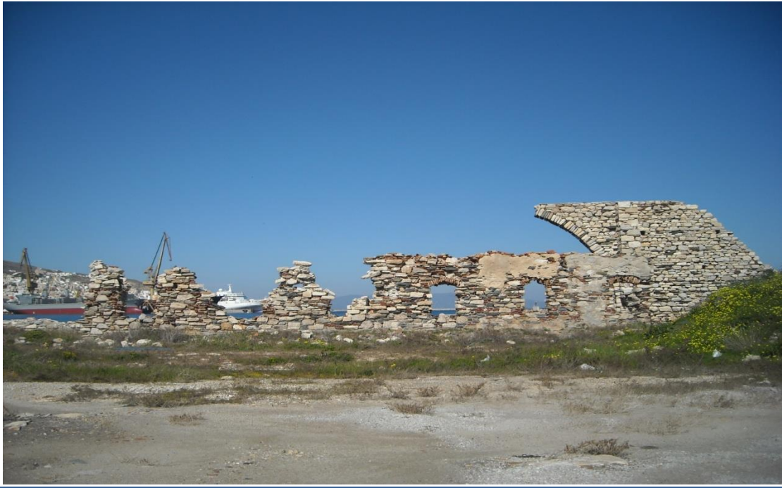
Εικόνα 91: Τοίχος που χει σωθεί στο εσωτερικό.
