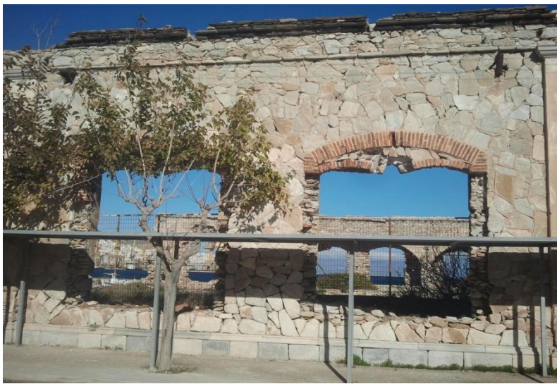
Εικόνα 53: Δίλοβα παράθυρα πλαισιωμένα από τούβλα. Κατάρρευση που πλαισίου τους ,καθώς δεν υπάρχουν και προστατευτικές σιδεριές. Χτιστό γείσο τρέχει στο άνω διάζωμα του τοίχου
