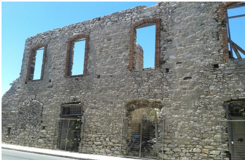
Εικόνα 110: Τοξωτά ανοίγματα με πλαίσιο από τούβλα και πετρά. Ημιλαξευμένοι εμφανείς λίθοι σε άτακτη τοποθέτηση.
