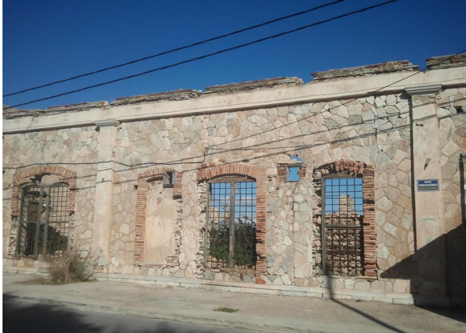
Εικόνα 60: Μονόλοβα και δίλοβα ανοίγματα. Κλειστό ένα μονόλοβο άνοιγμα . Αποκόλληση πλαισίωσης. Παραστάδες που έχει υποστεί αλλιώς ο χρωματισμός τους και αποκόλληση επιχρίσματος στο κάτω μέρος της βάσης.
