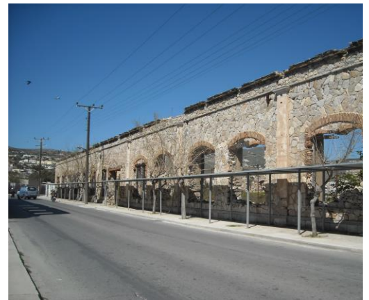
Εικόνα 9: Νότια όψη εργοστασίου.
