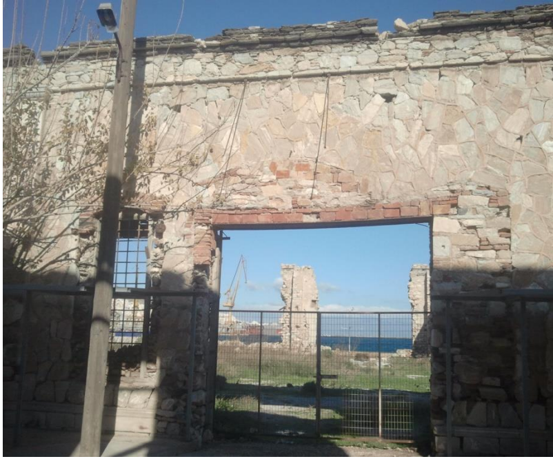
Εικόνα 11: Αποκόλληση τμήματος της τοιχοποιίας και των πλαισίων από τα τούβλα στην πόρτα και στο παράθυρο, καθώς και τμήμα του γείσου.
