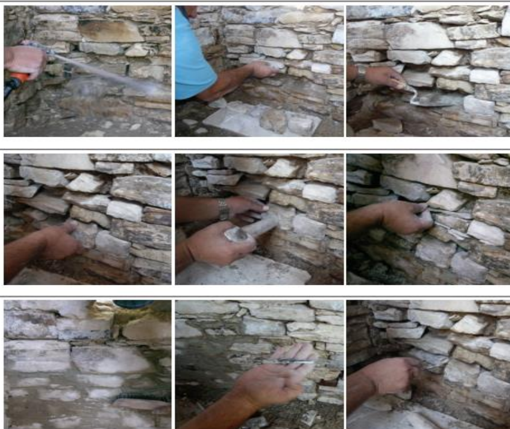
Εικόνα 35: Επισκευή τοιχοποιίας.
