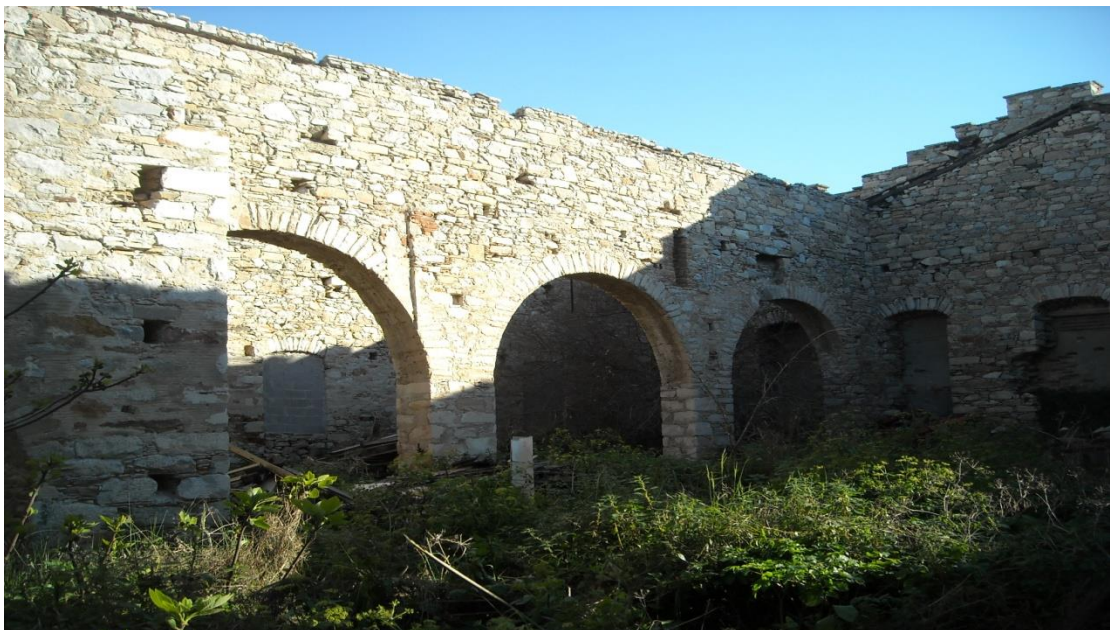
Εικόνα 132: Άποψη εσωτερικού τοίχου με καμάρες.
