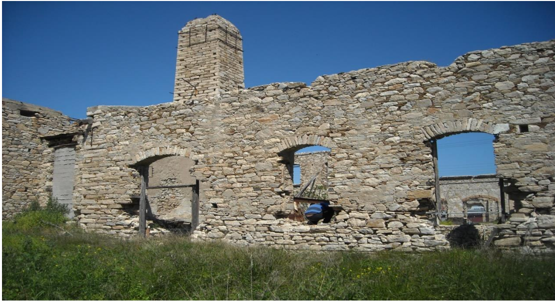
Εικόνα 141: Άποψη δυτικού τοίχου με ανοίγματα.
