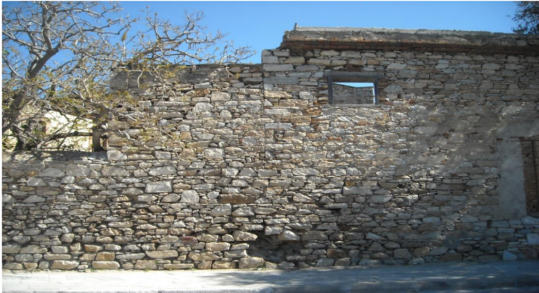
Εικόνα 121: Τοιχοποιία από εμφανής λίθους διάφορων μεγεθών. Αποκόλληση λιθοδομής.
