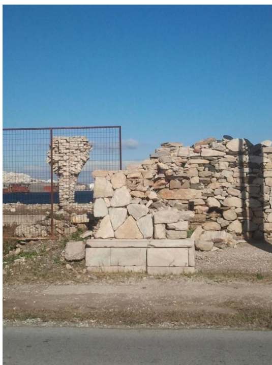
Εικόνα 47: Ερείπια τοίχου. Τμήμα του έχει καταστραφεί αριστερά και δεξιά.
