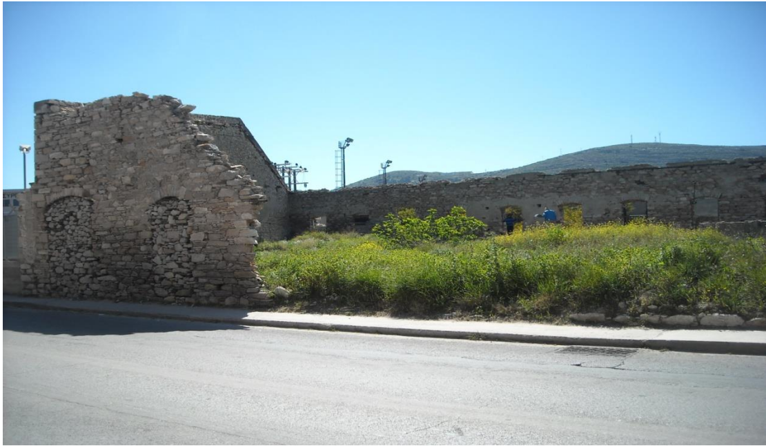
Εικόνα 111: Τμήμα τοίχου του ενιαίου μετώπου που έχει σωθεί επί της όψης.
