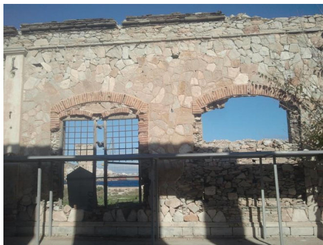
Εικόνα 54: Κλειστό το ένα δίλοβο άνοιγμα, ενώ στο άλλο έχουν σωθεί οι σιδεριές. Το πλαίσιο από τούβλα έχει αποκολληθεί σε τμήμα του, καθώς και μέρος του γείσου.
