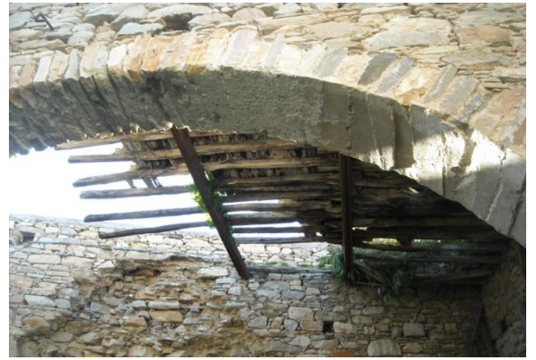
Εικόνα 11: Στέγη στο βοηθητικό κτίσμα
