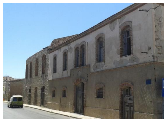
Εικόνα 12: Βόρεια όψη βοηθητικού κτίσματος.
