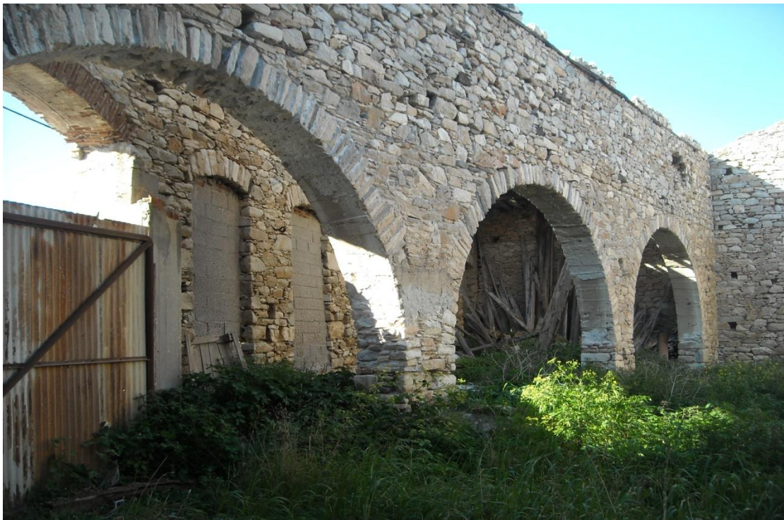
Εικόνα 126: Εσωτερικός τοίχος με καμάρες.
