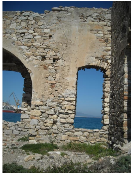
Εικόνα 23: Ίχνη επιχρίσματος.
