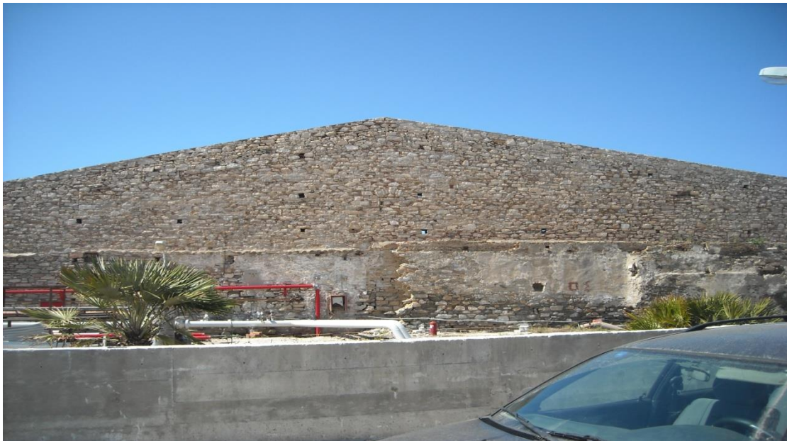
Εικόνα 114: Γενική άποψη της όψης της Δ.Ε.Η. Τριγωνικό αέτωμα δημιουργείται και χαρακτηριστικό είναι η ημιλαξευτή τοιχοποιία σε άτακτη τοποθέτηση. Είχε επιχρισθεί, αλλά έχουν απομείνει μόνο ίχνη του επιχρίσματος.
