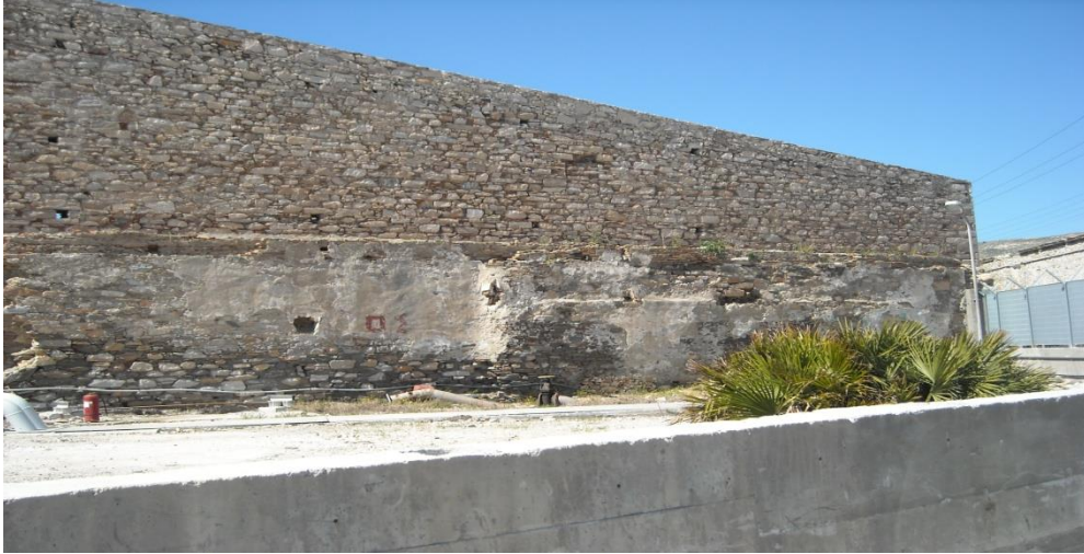
Εικόνα 113: Αρχή της όψης επί της Δ.Ε.Η. Εμφανή η λιθοδομή της. Το επίχρισμα έχει αποκολληθεί, αλλά μένουν ορατά ίχνη στην όψη.
