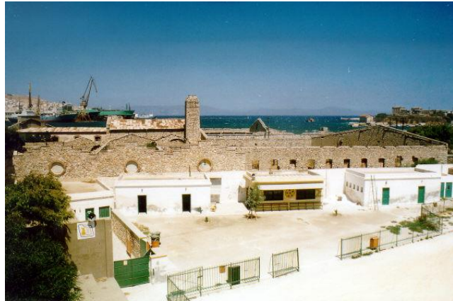
Εικόνα 3: Νότια όψη του συγκροτήματος.
