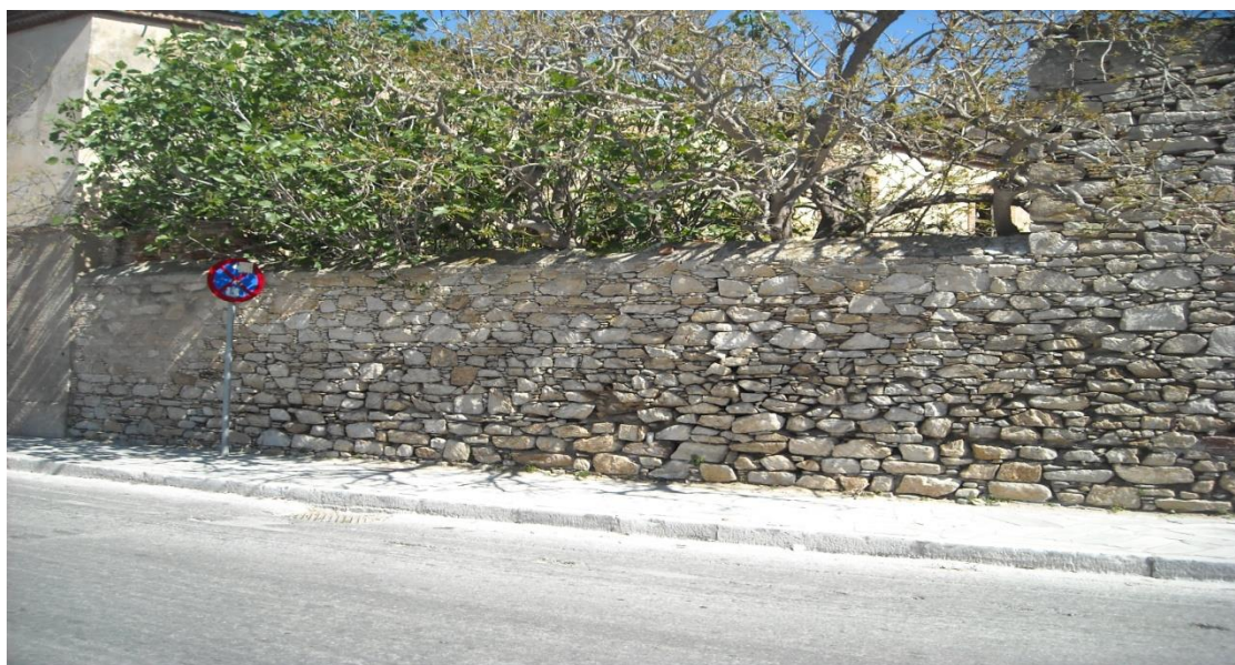
Εικόνα 120: Χαμηλωμένος τοίχος με εμφανή την λιθοδομή του.
