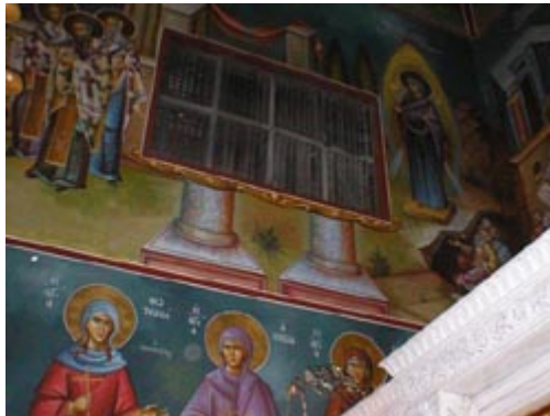
Παναγία η Δεξιά, Θεσσαλονίκη. Η απόληξη του αεραγωγού "πλαισιώθηκε" στην αγιογράφιση Virgin Mary the Dexia in Thessaloniki. The air duct was incorporated in the paintings. Πηγή: Αρχείο συγγραφέων / Source: Authors' Archive
