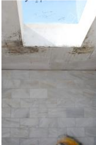
Εικόνα 60: Σταθερό Άνοιγμα Οροφής
