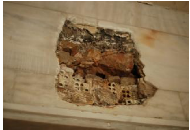
Εικόνα 17: Λιθοδομή Πάνω από Άνοιγμα Πόρτας, στο Εσωτερικό του
