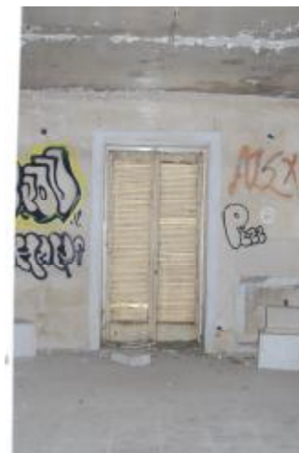
Εικόνα 55: Εσωτερική Πλευρά Μπαλκονόπορτας
