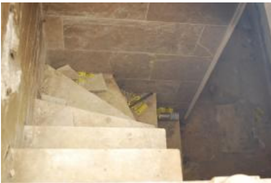
Εικόνα 29α: Η Σκάλα που Οδηγεί στο Υπόγειο
