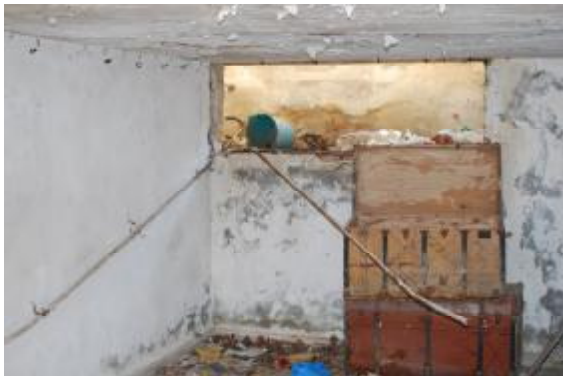
Εικόνα 30: Ένας Χώρος στο Υπόγειο του Κυρίως Ογκου
