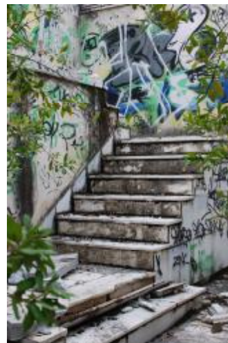
Εικόνα 56α: Το Εξωτερικό κλιμακοστάσιο για την Πρόσβαση στο Δώμα, Σήμερα
