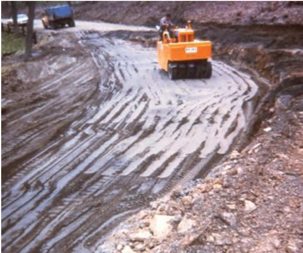
Κατασκευή δρόμου με χρήση ιπτάμενης τέφρας (Fly Ash)
