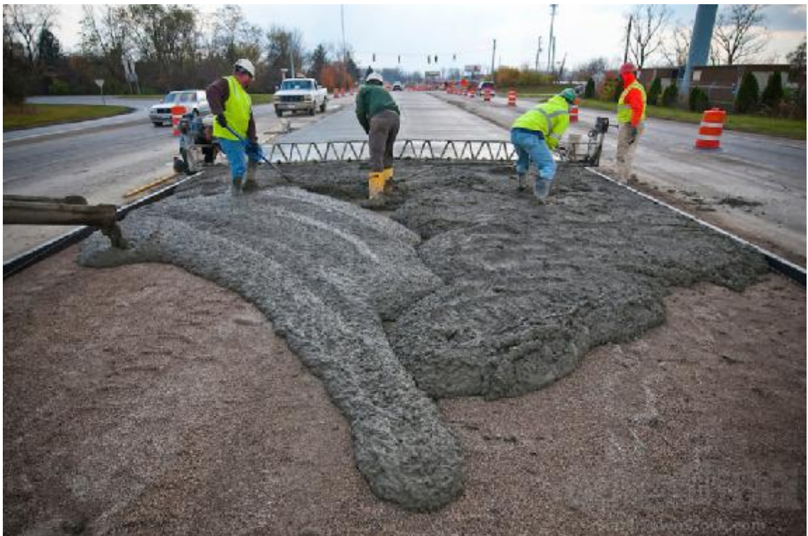
Σχ: Κατασκευή ενδιάμεσης λωρίδας από άοπλο σκυρόδεμα.
