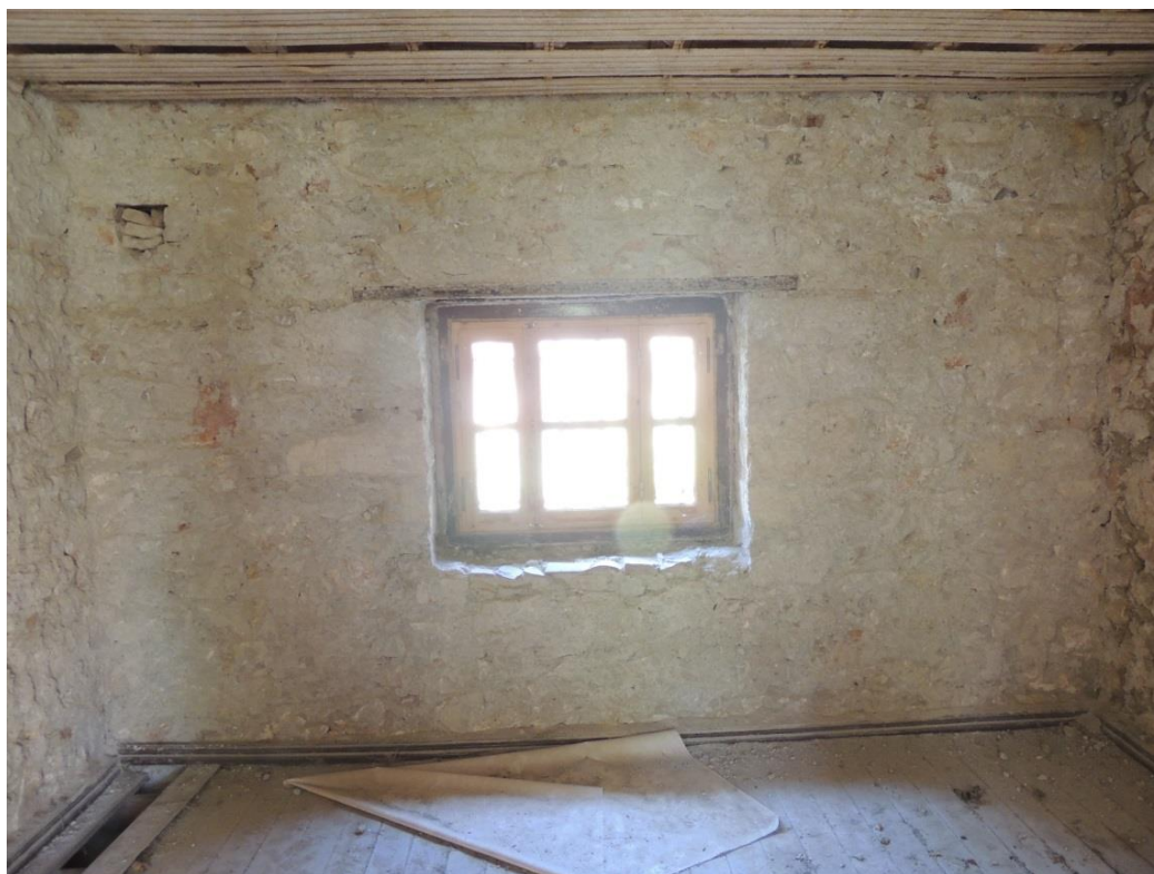
Α.2 εικ.6: Η εμφανή λιθοδομή του δωματίου στο ισόγειο, όπου έχει γίνει αποσάθρωση επιχρίσματος.
