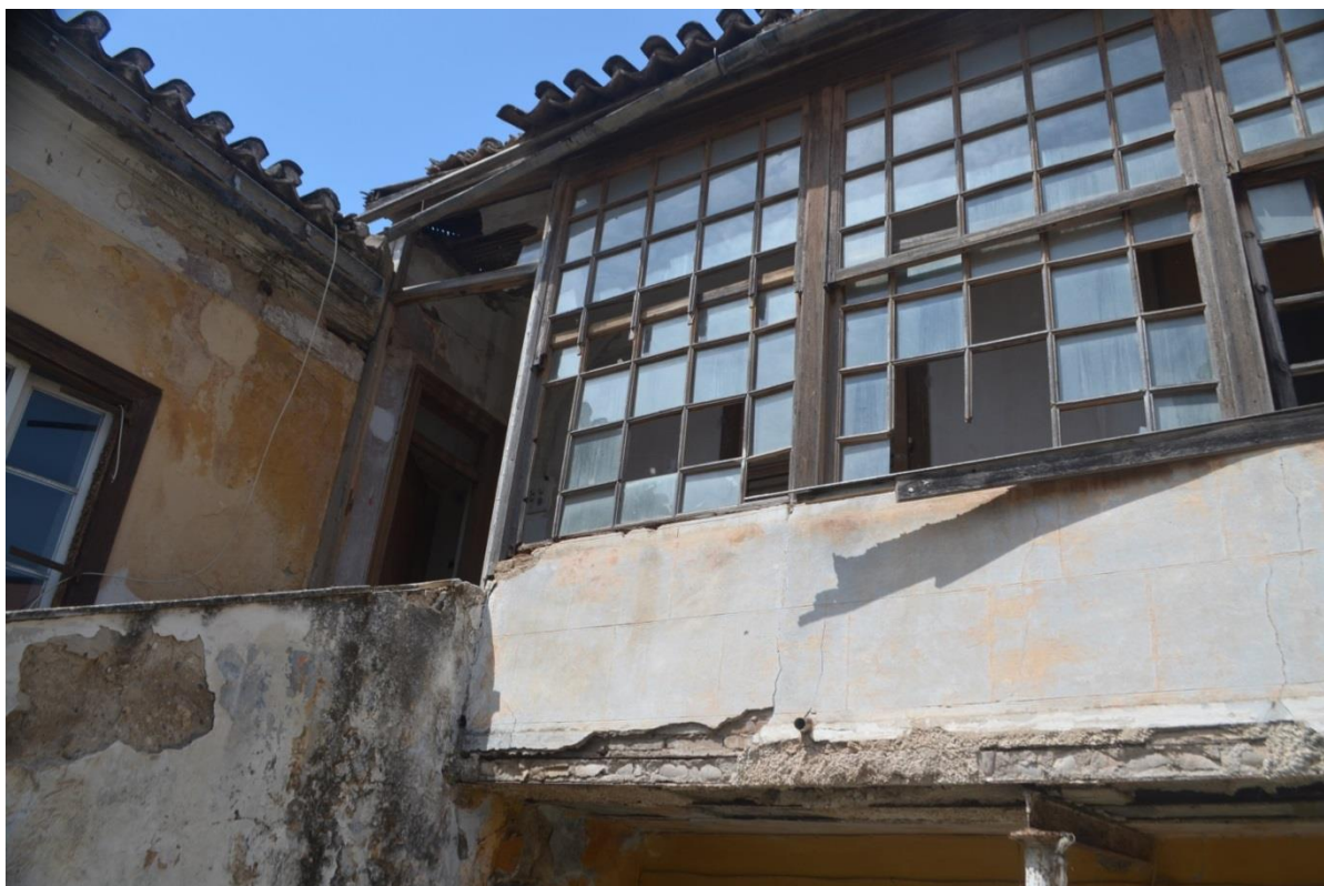
Κτι.Α εικ.11: Το ξύλινο υαλοστάσιο του λιακωτού τύπου καρμανιόλα.
