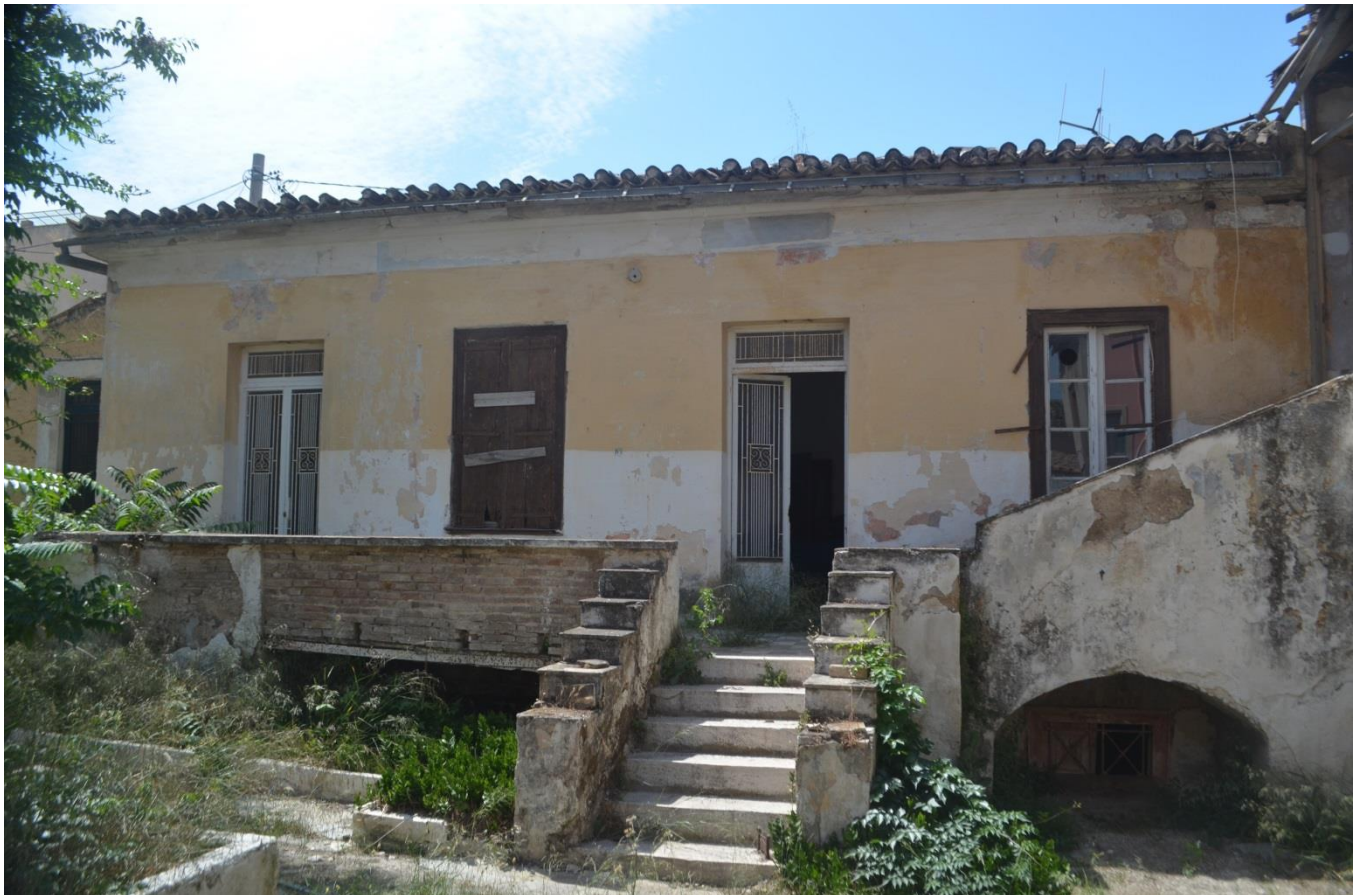
Κτι.Β εικ.3: Εσωτερική όψη κτιρίου Α, βλέπουμε τις μαρμάρινες βαθμίδες στην κλίμακα και τα μεταγενέστερα κουφώματα.
