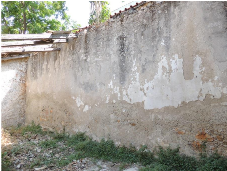
Γ.1 εικ.52 Τοιχοποιία ξεγυμνωμένη από επιχρίσματα και με εμφανή σημάδια υγρασίας
