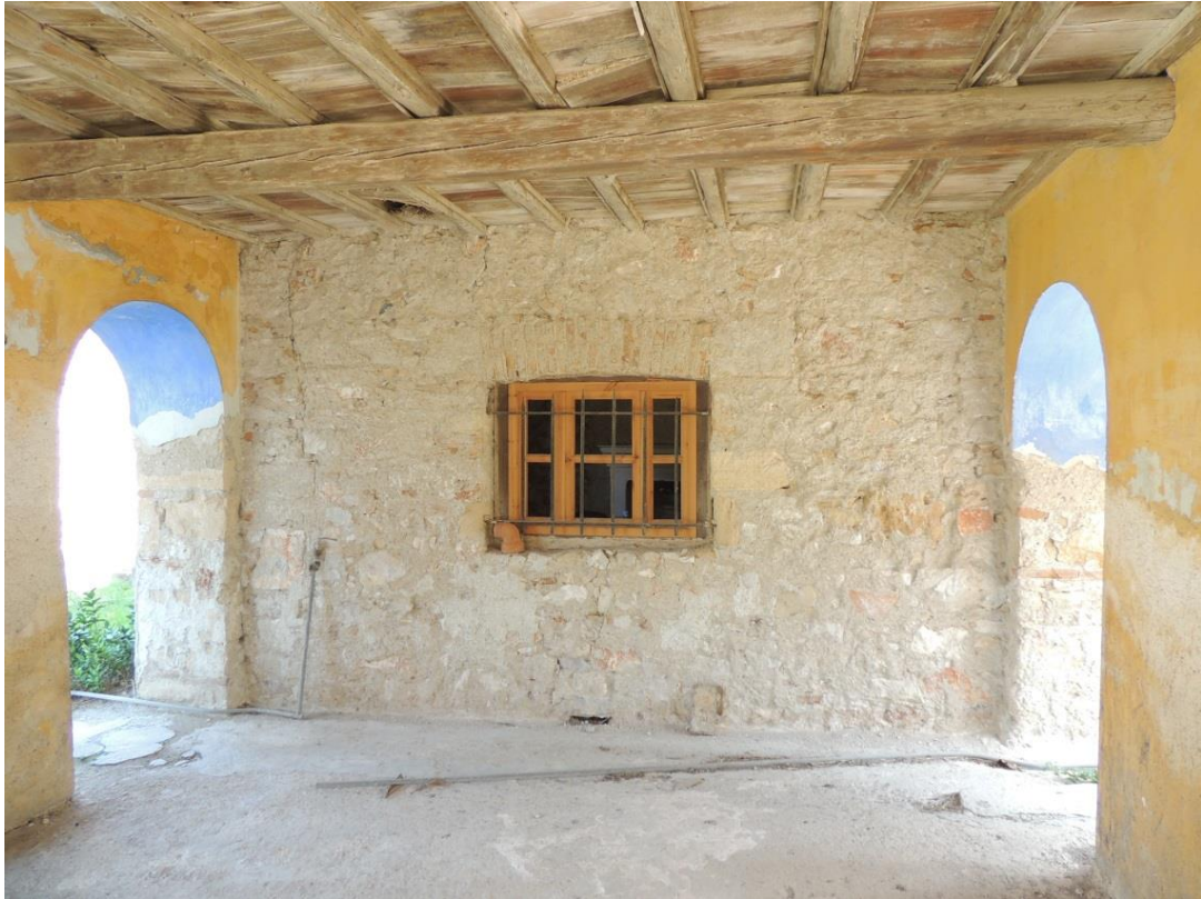
Α.3 εκ.19: Η εμφανή λιθοδομή στο εξωτερικό του κτιρίου Α.
