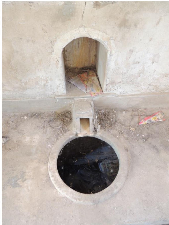
Γ.1 εικ.44 Δοχεία υποδοχής μούστου. Το μάρμαρο έχει υποστεί φθορές από την εγκατάλειψη
