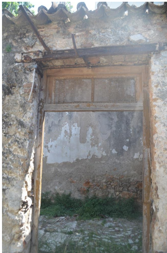
Γ.1 εικ.25 Κούφωμα σαπισμένο από την έκθεσή του στα καιρικά φαινόμενα
