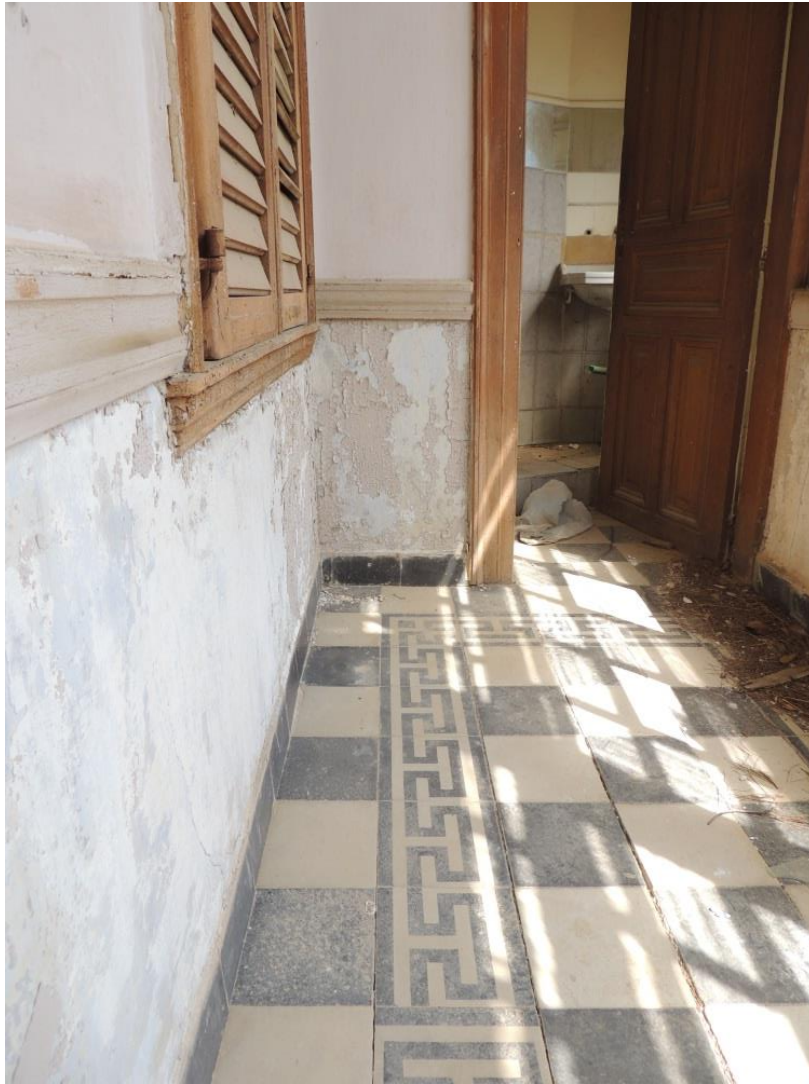
Κτι.Α εικ.10: Δάπεδο λιακωτού- χαγιάτι ιδιαίτερου κάλους
