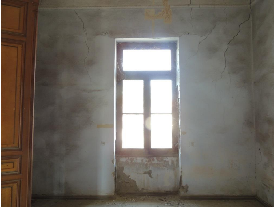
Α.4 εικ.40 Η τοιχοποιία στον όροφο, έχουμε υγρασία και αποσάθρωση τοιχοποιίας
