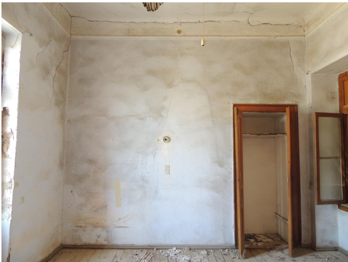
Κτι.Α εικ.8: Εσωτερική τοιχοποιία του ορόφου στο κτίριο Α, με επίχρισμα τριπτό- τριβιδιστό
