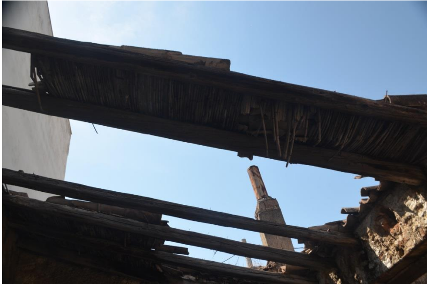
Γ.1 εικ.31 Λεπτομέρεια Στέγης
