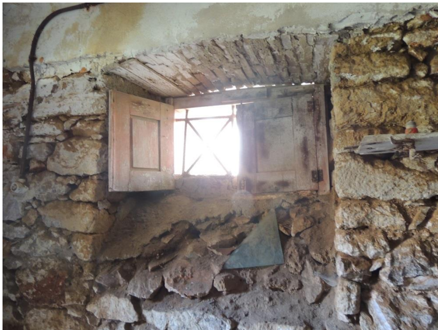
Β.1 εικ.5 Τοιχοποιία ξεγυμνωμένη από το επίχρισμα και σαπισμένα κουφώματα
