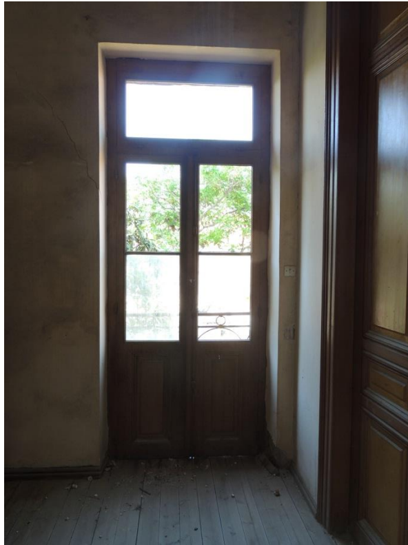
Α.4 εικ.27 Δίφυλλή πόρτα στον όροφο
