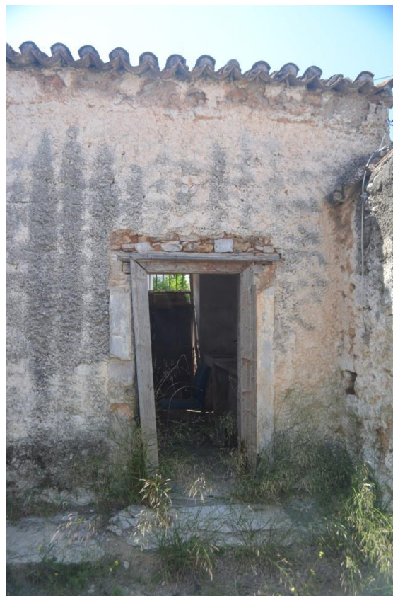
Γ.1 εικ.8 Τοιχοποιία ξεγυμνωμένη και με εμφανή υγρασία καθώς και σαπισμένο κούφωμα
