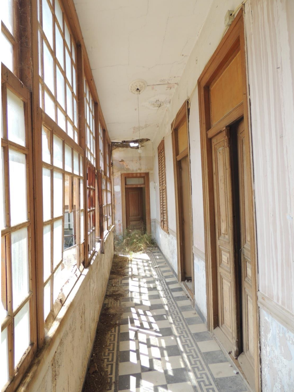
Κτι.Α εικ.9: Μακρόστενος διάδρομος τον όροφο του κτιρίου Α, λιακωτό- χαγιάτι
