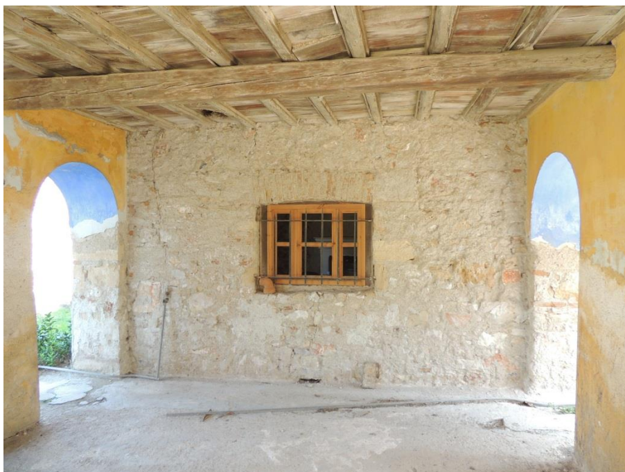
A.3 εικ.19 Εμφανή λιθοδομή, χωρίς προβλήματα πλην την ξεγύμνωση του επιχρίσματος
