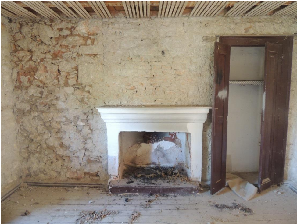
Α.2 εικ.3 Το τζάκι του δωματίου στο ισόγειο καθώς και ξεγυμνωμένη από επίχρυσμα τοιχοποιία
