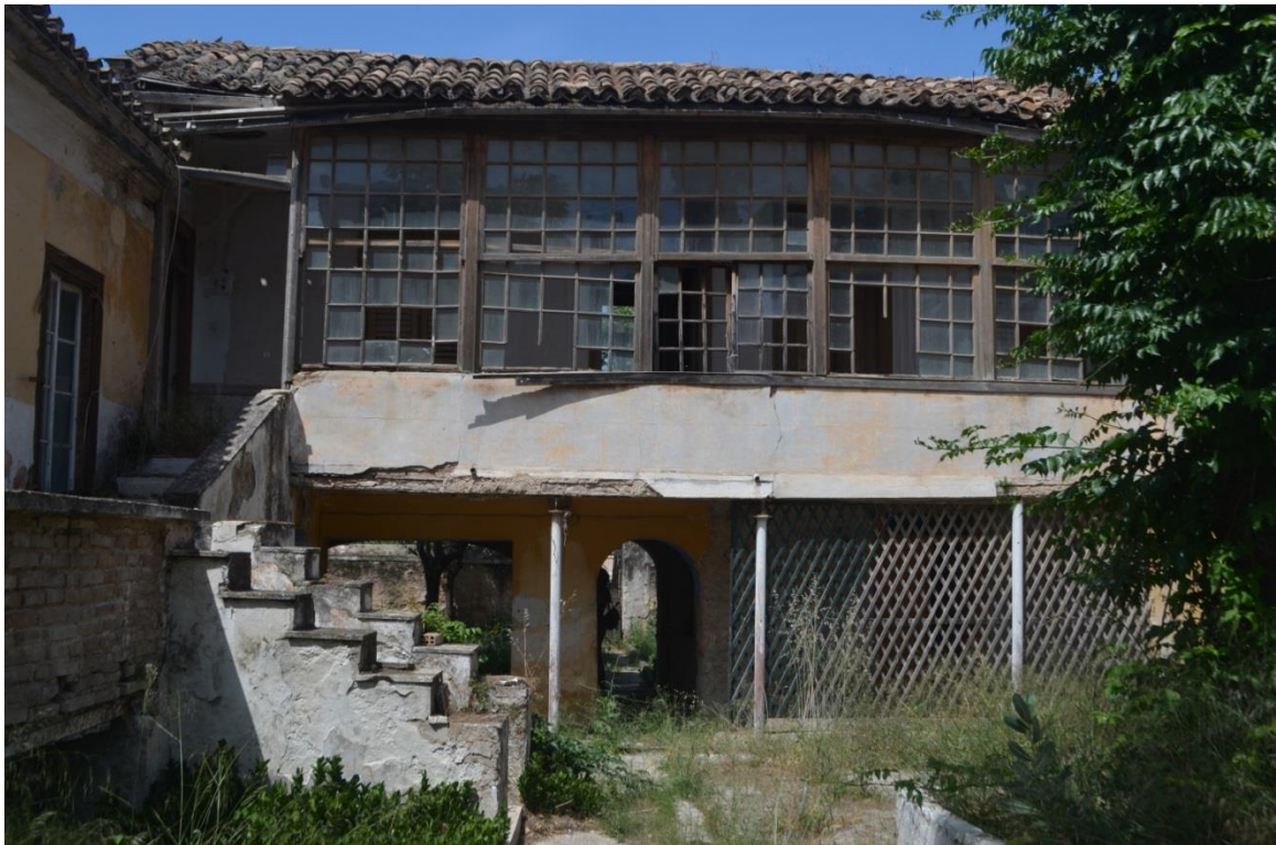
Νότια όψη κτιρίου Α
