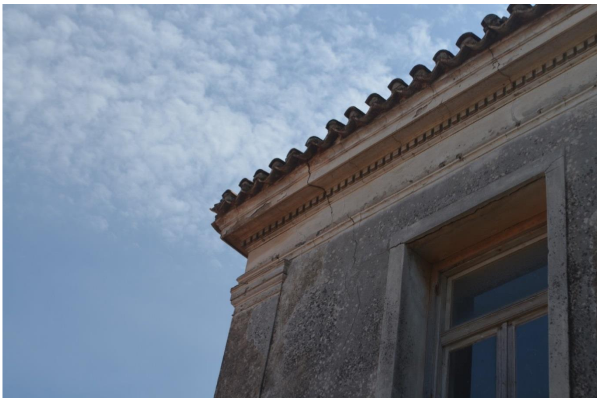
Πρόσοψη κτιρίου Α, διακοσμητικά στοιχεία τραβηγτών κονιαμάτων
