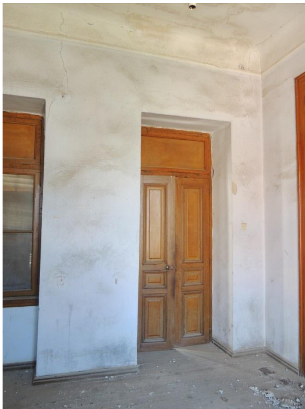
Α.4 εικ.38 Τοιχοποιία στον όροφο και παραδοσιακό ξύλινο κούφωμα
