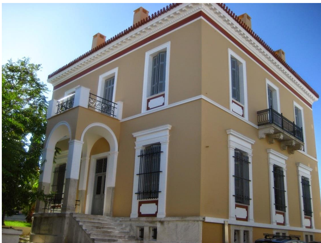
2. Διατηρητέο κτήριο- Κτήριο Δροσοπούλου, κατοικία παλιού Δημάρχου
