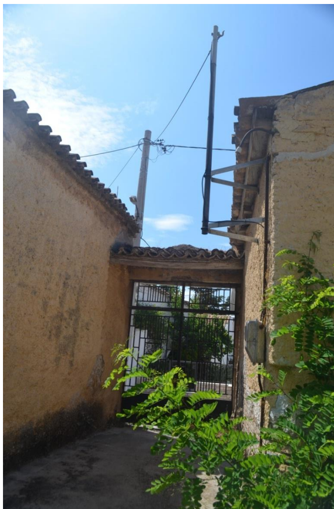
Περ.χω. εικ.1: Ο διάδρομος που οδηγεί στην μίας απ τις δύο κύριες εισόδους του κτιριακού μας συγκροτήματος, στο βάθος φαίνεται και η περίτεχνη πόρτα.
