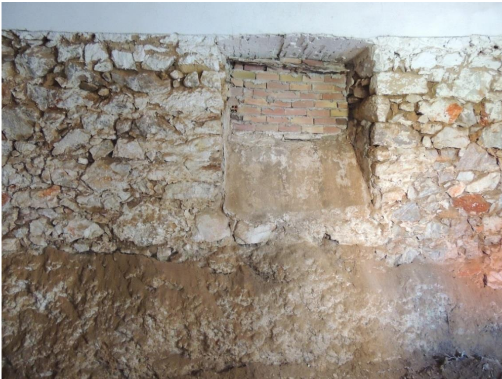
Κτι.Β εικ.1: Κλείσιμο φεγγιτών ημιυπόγειου χώρου για την καλύτερη συντήρηση των κρασιών.
