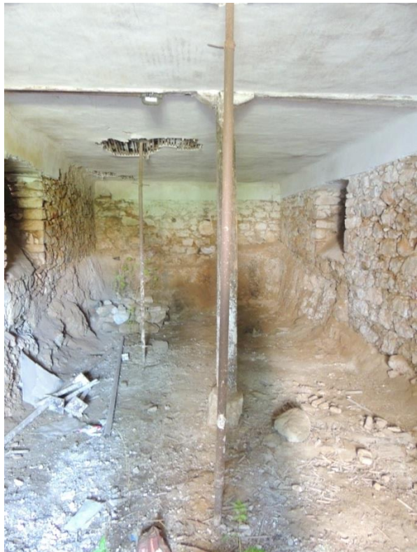
Εικ.2 Μέθοδος στήριξης στο ημιυπόγειο
