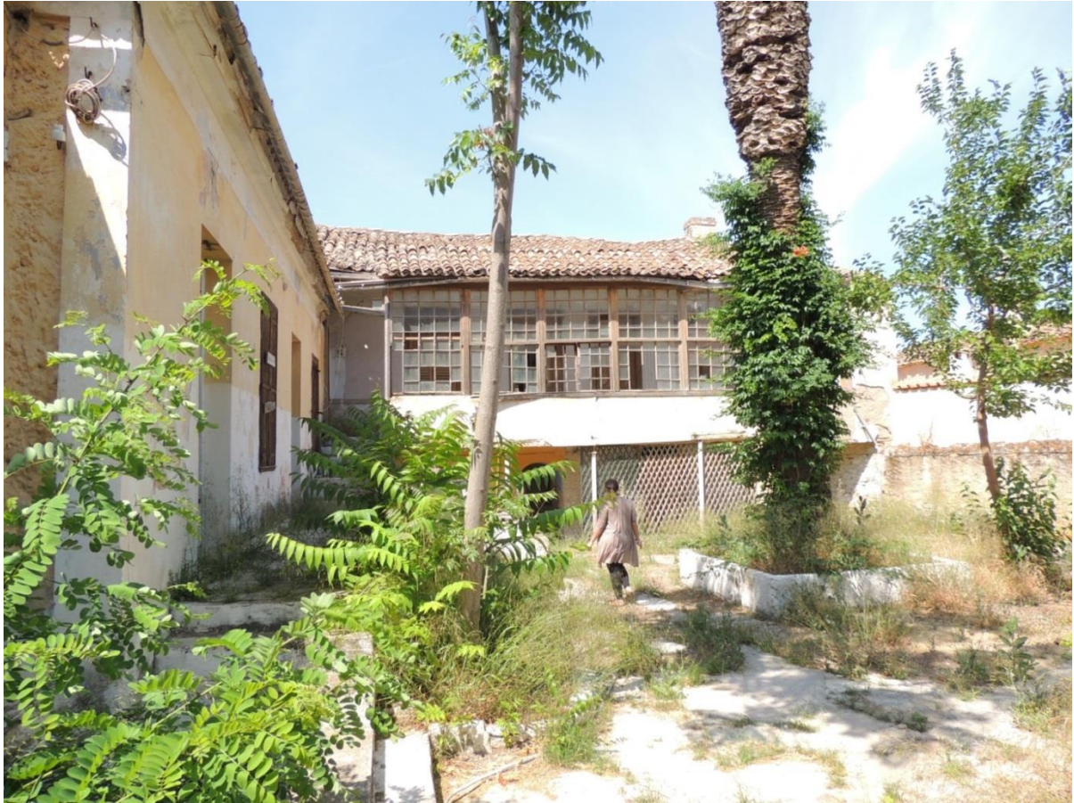
Περιβάλλοντας χώρο- αυλή, όπως διακρίνεται απ την νότια πλευρά
