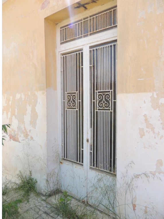
Β.2 εικ.19 Σιδερένιο εξωτερικό κούφωμα, μεταγενέστερο
