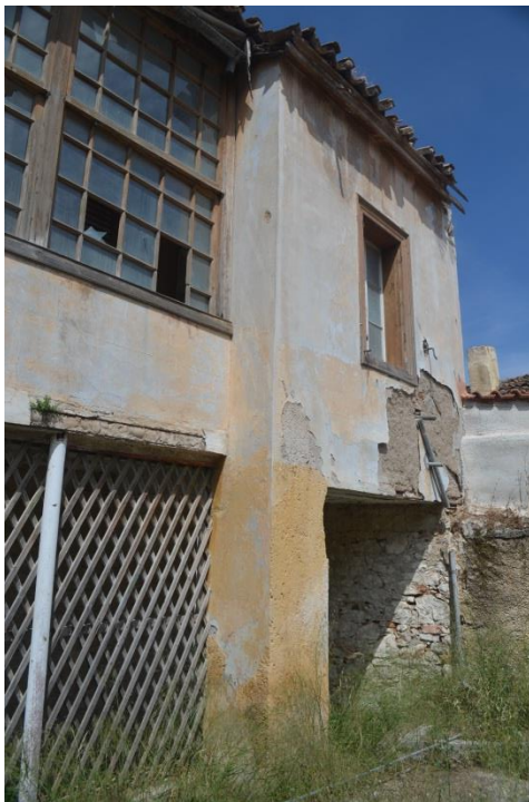
Α.1 εικ.12 Όψη κτηρίου Α προς την αυλή
