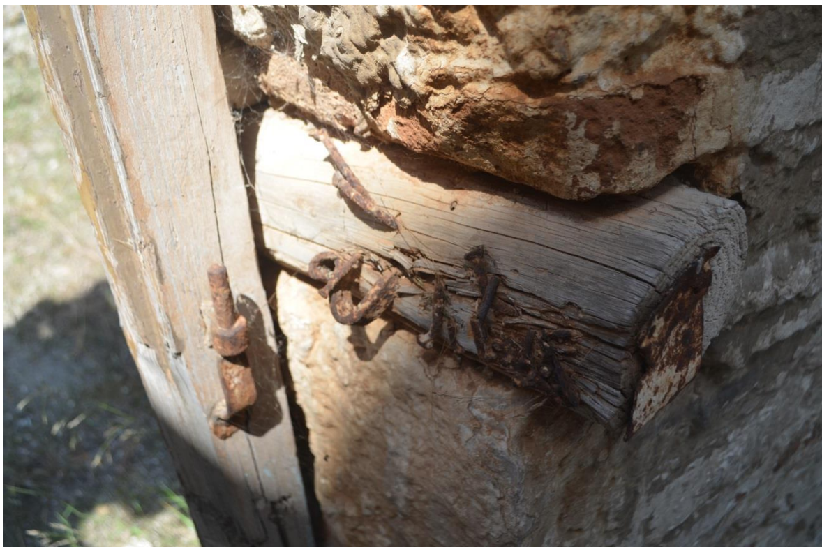
Γ.1 εικ.37: Λεπτομέρεια από κούφωμα του κτιρίου Γ
