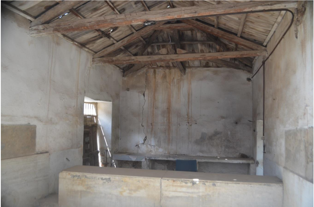
Κτι.Γ εικ.1: Η Στέγη στο κτίριο Γ.
