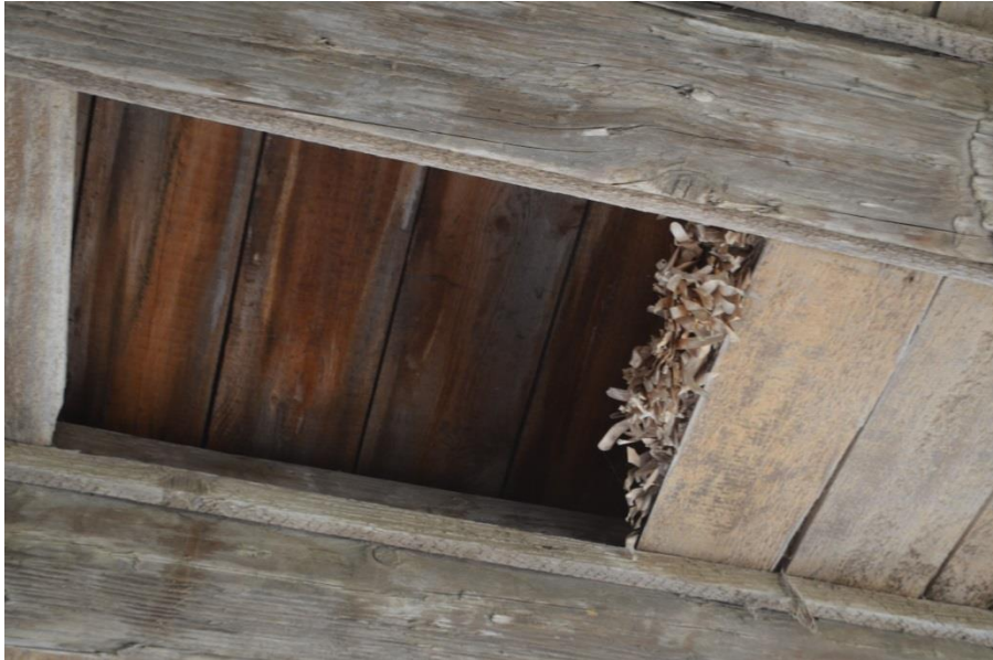
Α.3 εκ.3 Ψευδοροφή ισόγειου, ξυλοπατοδοκοί
