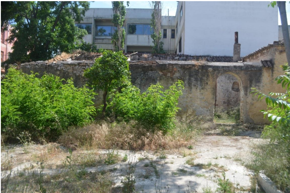
Βόρεια Όψη κτιρίου Γ
