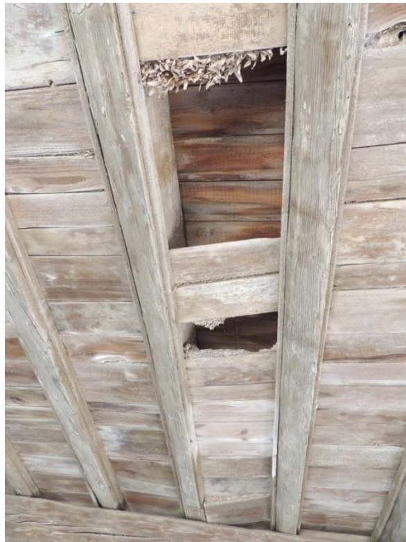
Α.3 εικ.11: Η ψευδοροφή στον εσωτερικό χώρο του ισογείου. Έχει καθαίρεση από το ξύλινο μαγαδάτι και μέσα βλέπουμε τις τρίχες αίγας.
