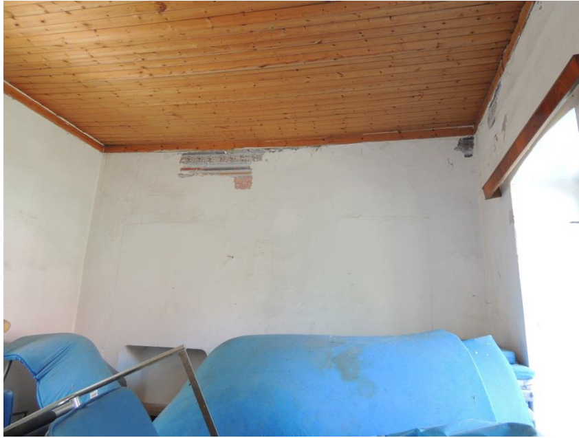
Β.2 εικ.14 Κομμάτι διακοσμητικού διάκοσμος στο εσωτερικό του κτηρίου Β
