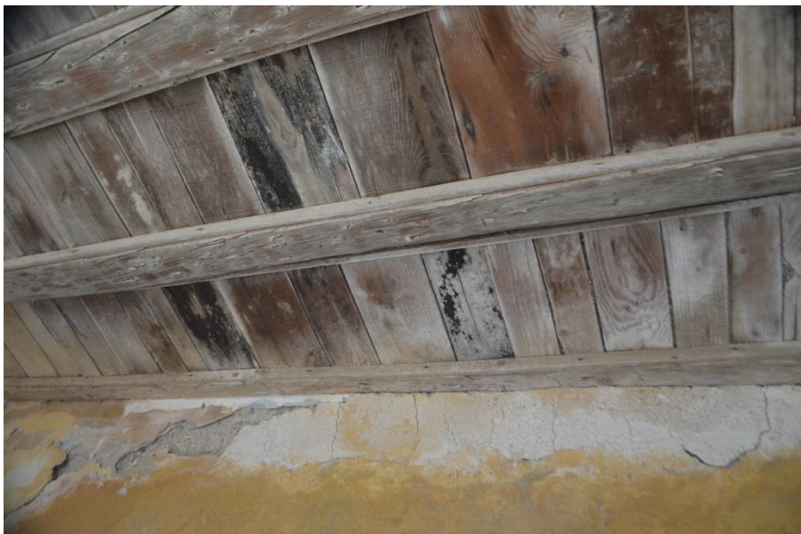
Α.3 εκ.5 Ψευδοροφή, ξυλοπατογοκοί και μισσάνιδα
