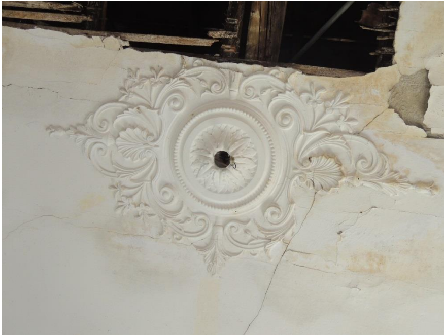
Α.4 εικ.18 Γύψινα στοιχεία στην ψευδοροφή του κτιρίου
