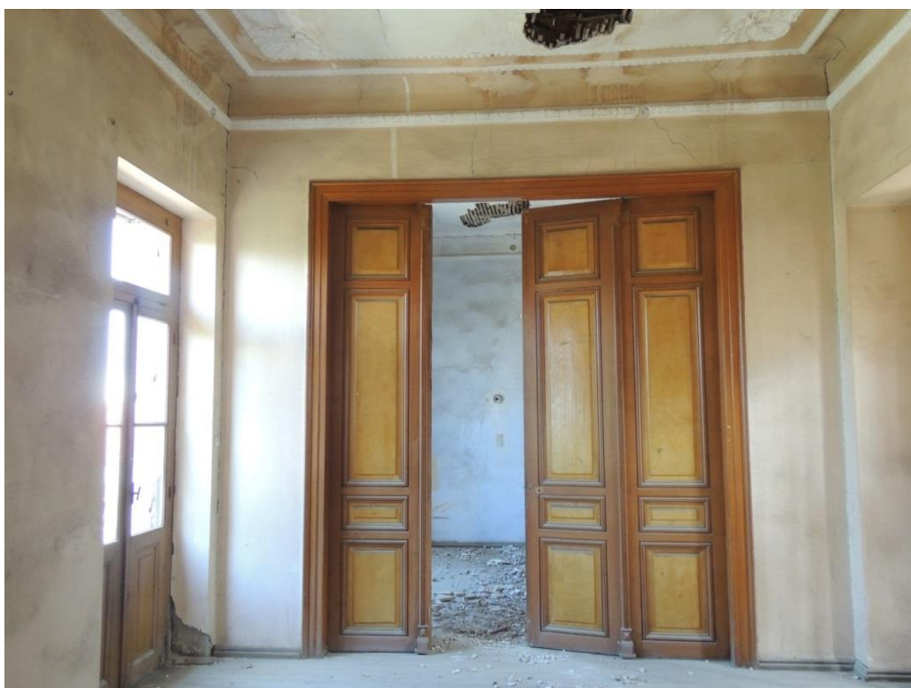
Α.4 εικ.26: Η επιβλητική ξύλινη πόρτα που υπήρχε στο εσωτερικό του ορόφου στο κτίριο Α. Έχει προσβληθεί από μικροοργανισμούς αν σημεία.
