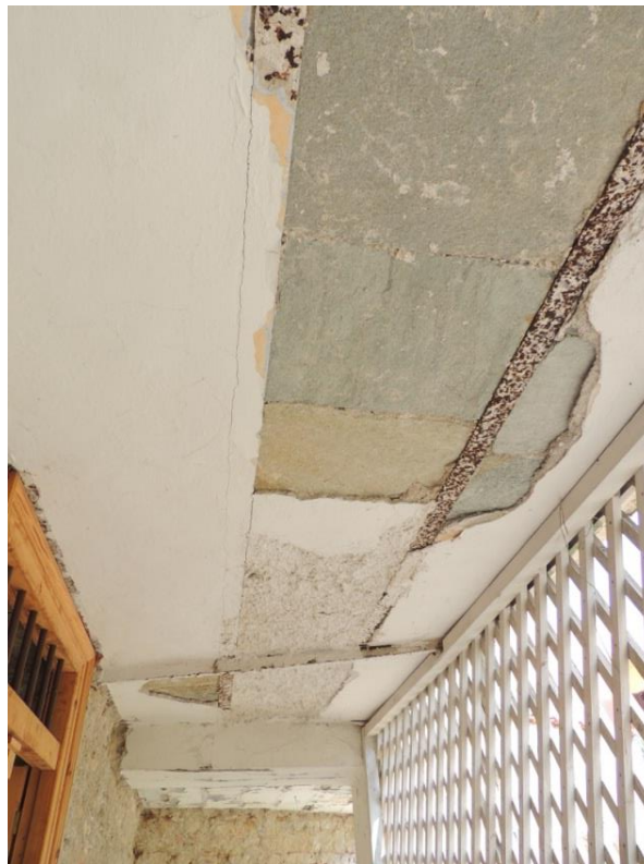
Κτιρ.Α εικ.5 Άνοψη διαδρόμου ισογείου, εμφανείς οι σιδηροδοκοί
