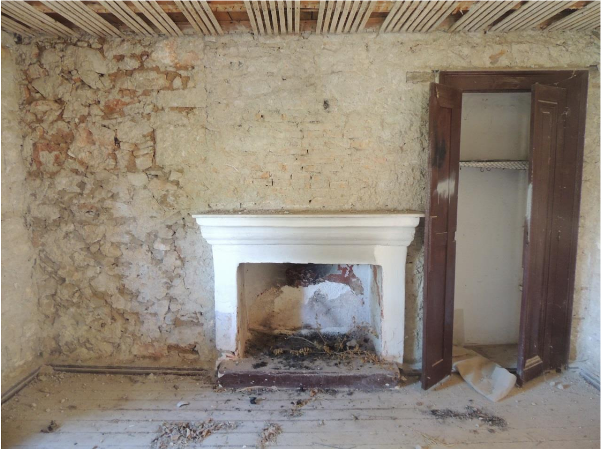
Κτι. Α εικ.3: Μονόχωρο δωμάτιο στο ισόγειο του κτιρίου Α, με τοιχοποιία από λιθοδομή
