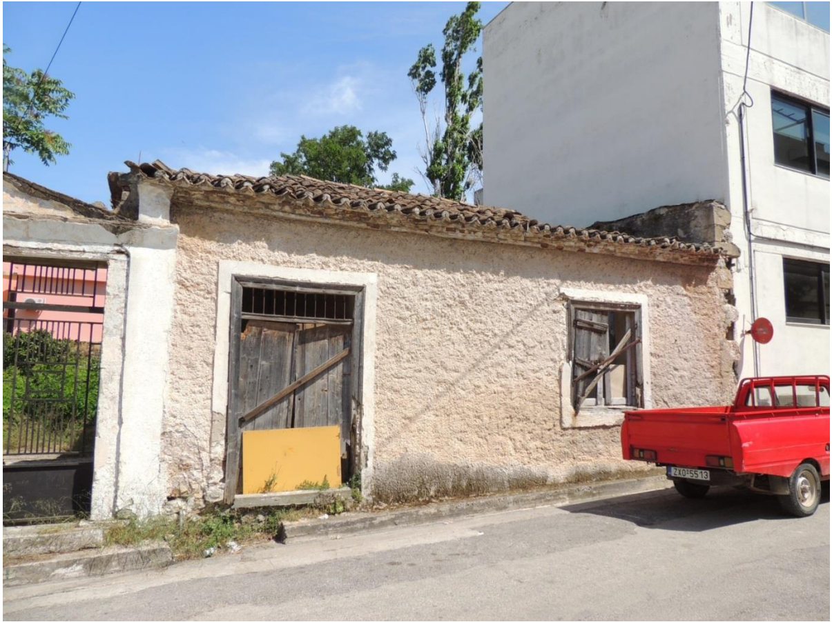
Όψη κτιρίου Γ επί την οδό Ε. Παπαθανασίου
