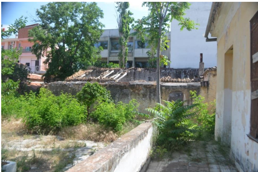
Γεν. εικ.3 Περιβάλλοντας χώρος από το κτήριο Β προς το κτήριο Γ
