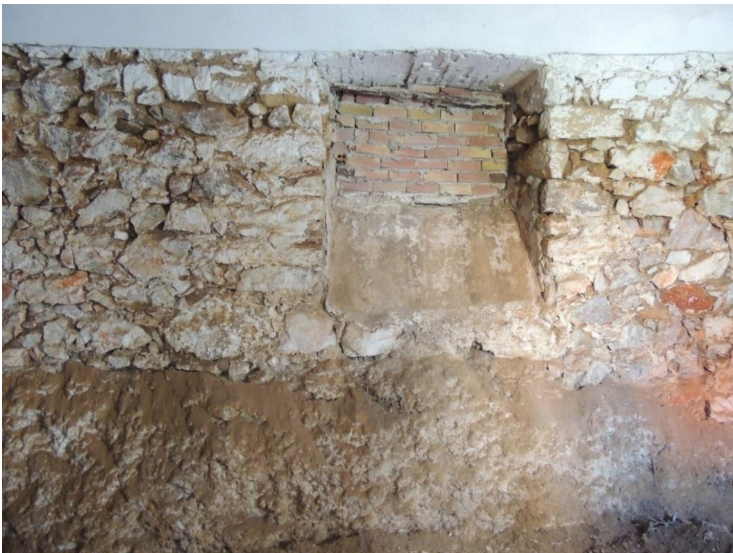
Β.1 εικ.8: Σημείο απ το ημιυπόγειο. Κλειστό κούφωμα, για λόγους συντήρησης κρασιών και τοιχοποιία εντελώς ξεγυμνωμένη από επιχρίσματα.
