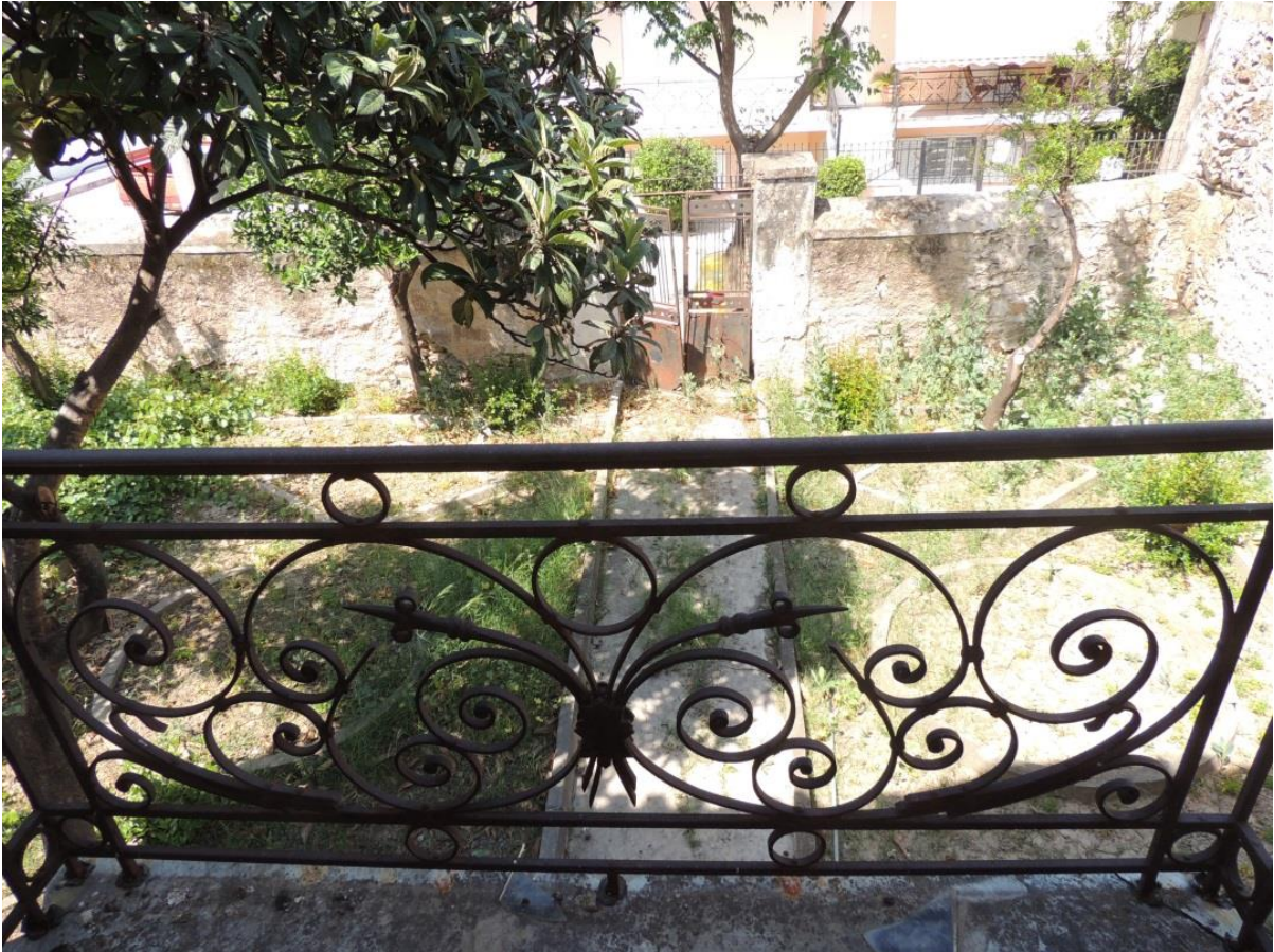
Περ.χω. εικ.2: Η αυλή όπως φαίνεται απ το όροφο του κτιρίου Γ, το βορειοανατολικό κομμάτι της και η κεντρική είσοδος του κτιριακού συγκροτήματος.
