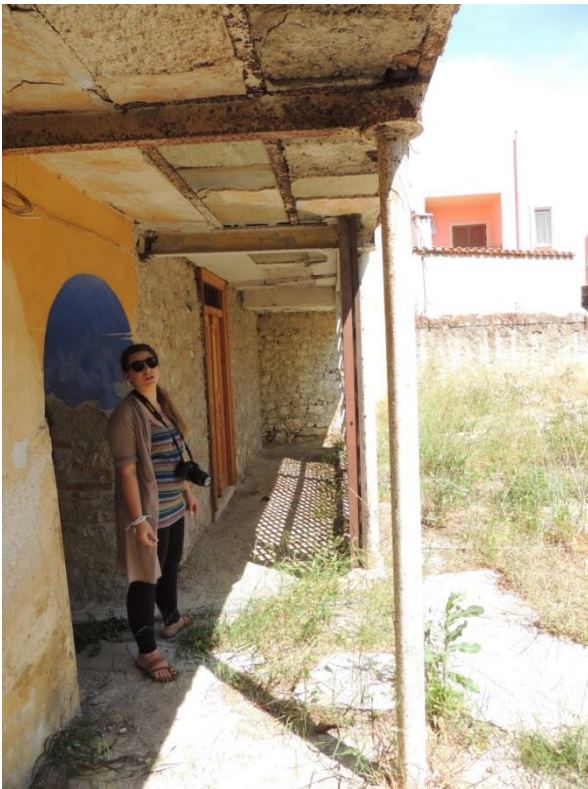
Εικ.1 Μέθοδος στήριξης στο όροφο Α
