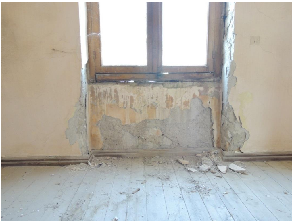
Α.4 εικ.24: Κομμάτι απ την τοιχοποιία του ορόφου στο κτίριο Α. Έχουμε προβλήματα αποσάθρωσης επιχρισμάτων και εισχώρησης όμβριων υδάτων (υγρασία). Η λιθοδομή φαίνεται να είναι σε καλή κατάσταση.
