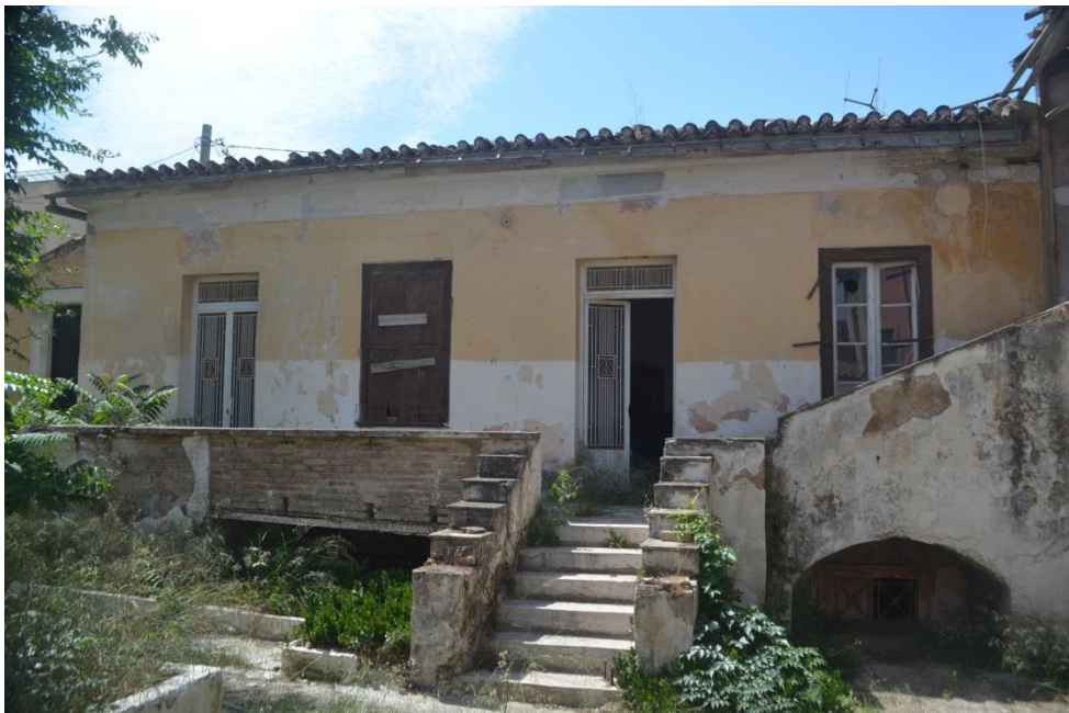
Ανατολική όψη κτιρίου Β
