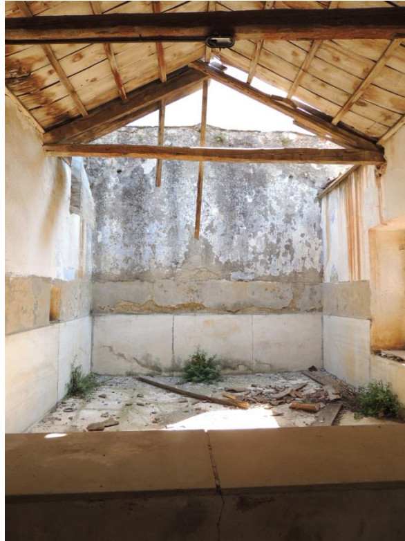
Γ.1 εικ.43 Το εσωτερικό του χώρου του πατητηριού
