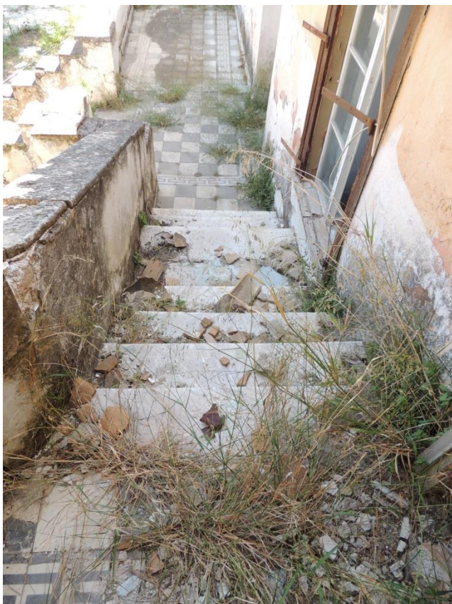
Α.4 εικ.49: Η κλίμακα που οδηγεί απ το κτίριο Β στον όροφο του κτιρίου Α. Τα μάρμαρα έχουν σπάσει σε κάποια σημεία και απ την πάροδο των χρόνων έχουν «θολώσει».
