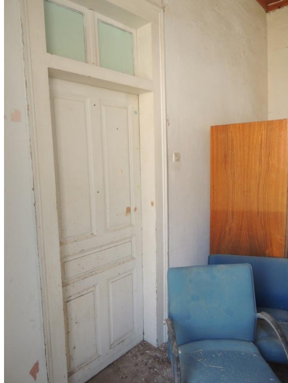
Β.2 εικ.17 Εσωτερικό ξύλινο κούφωμα
