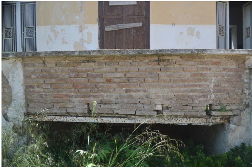
Β.2 εικ.9 Τοιχοποιία από τούβλο χωρίς καθόλου επίχρισμα
