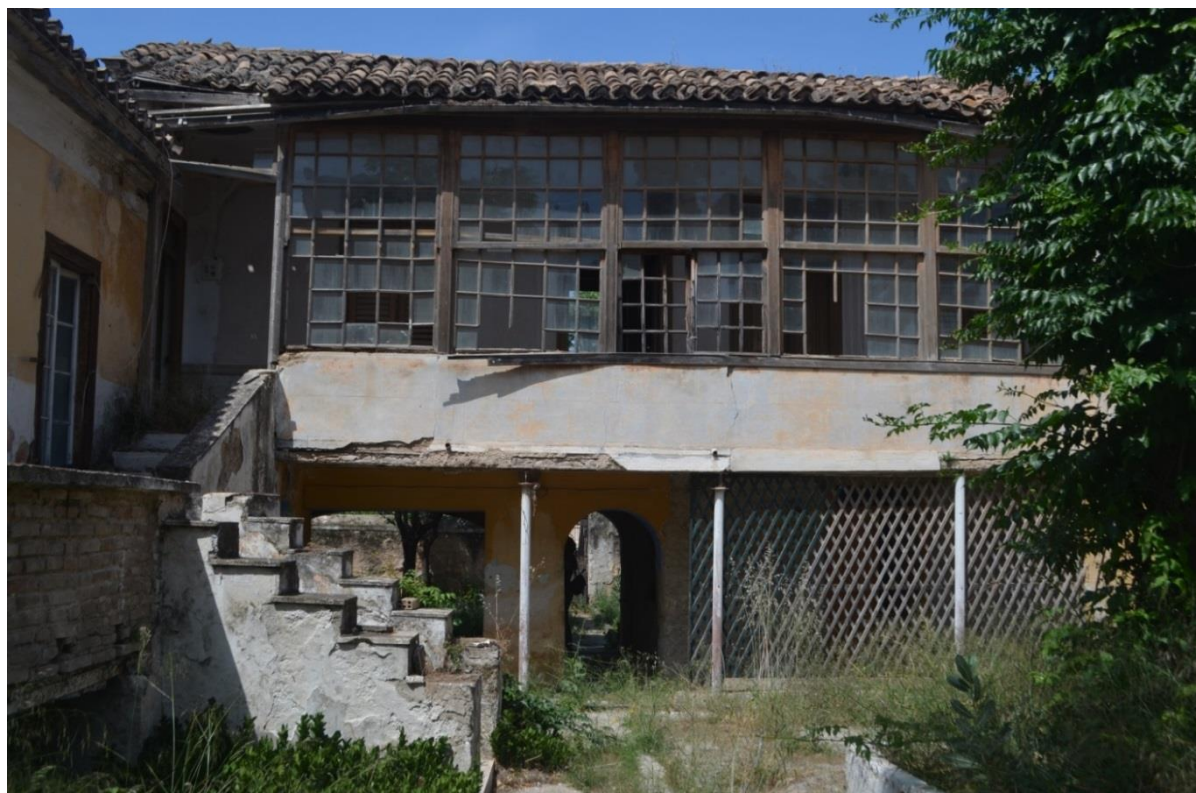
Εσωτερική όψη κτιρίου Α, λιακωτό- χαγιάτι
