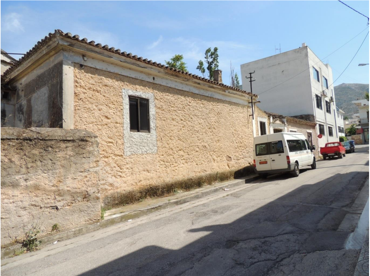
Όψη κτιρίου Β, επί της οδού Ε. Παπαθανασίου
