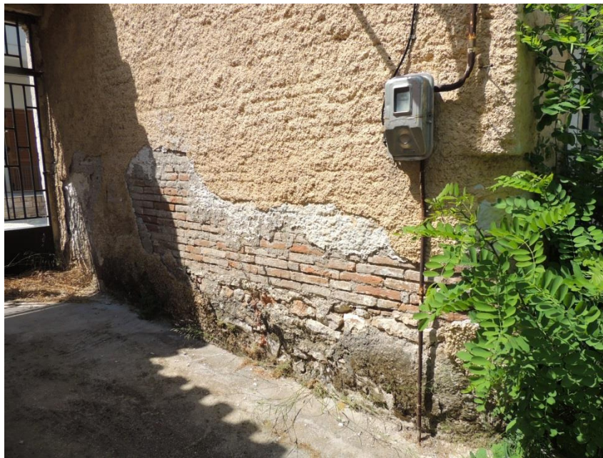
Β.2 εικ.21 Εξωτερική αποσαθρωμένη τοιχοποιία από το παράσιτο
