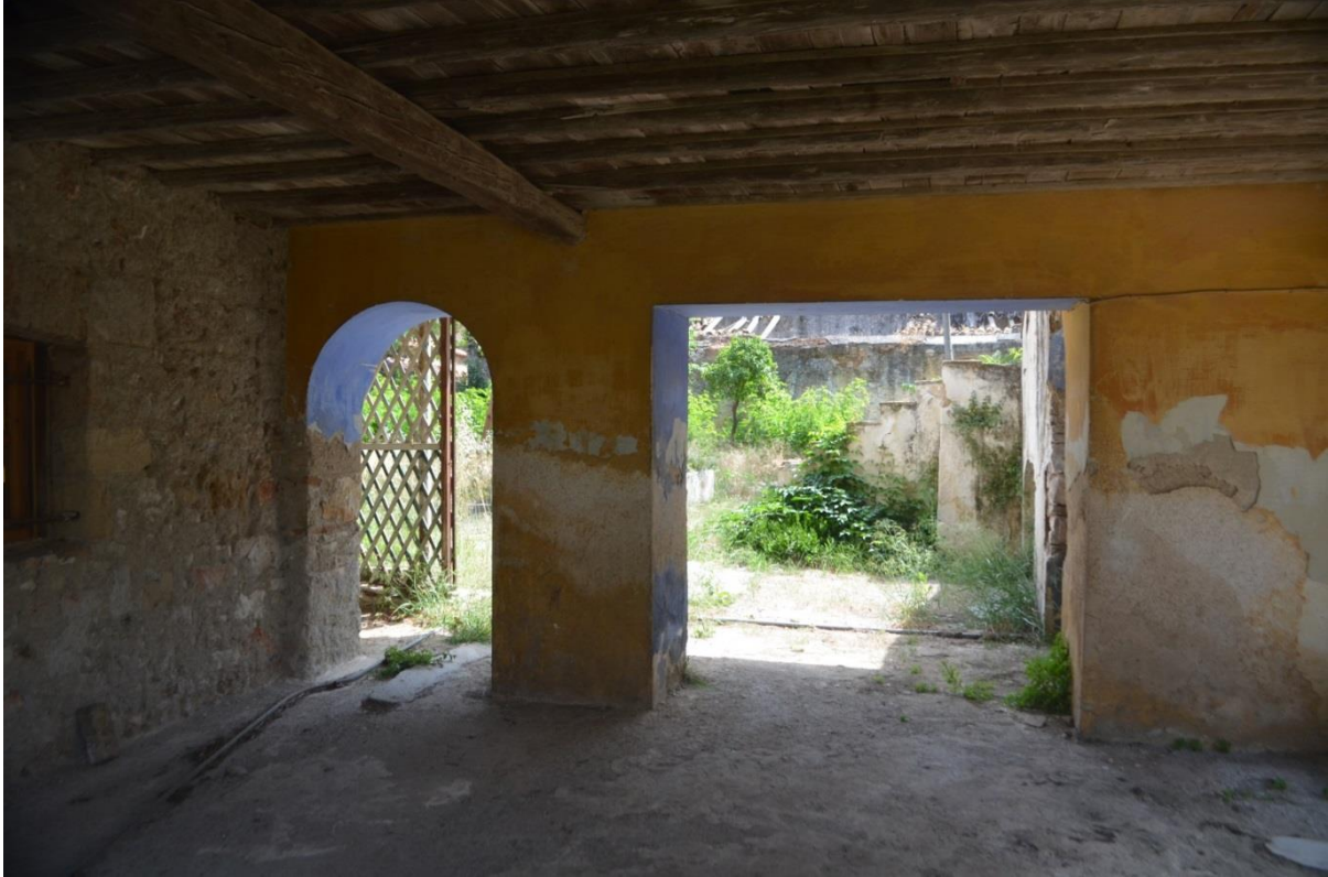
Κτι.Α εικ.2: επιχρισμένοι τοίχοι με τριπτά- τριβιδιστά επιχρίσματα
