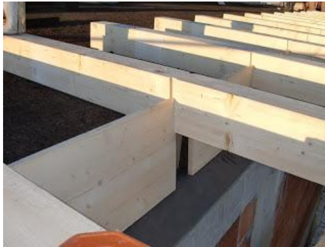
Εικόνα 1- 4 Κατασκευή κεραμοσκεπής- στέγης
