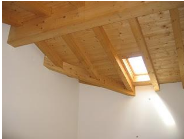
Εικόνα 0-1-6 Ξύλινη στέγη σοφίτας
