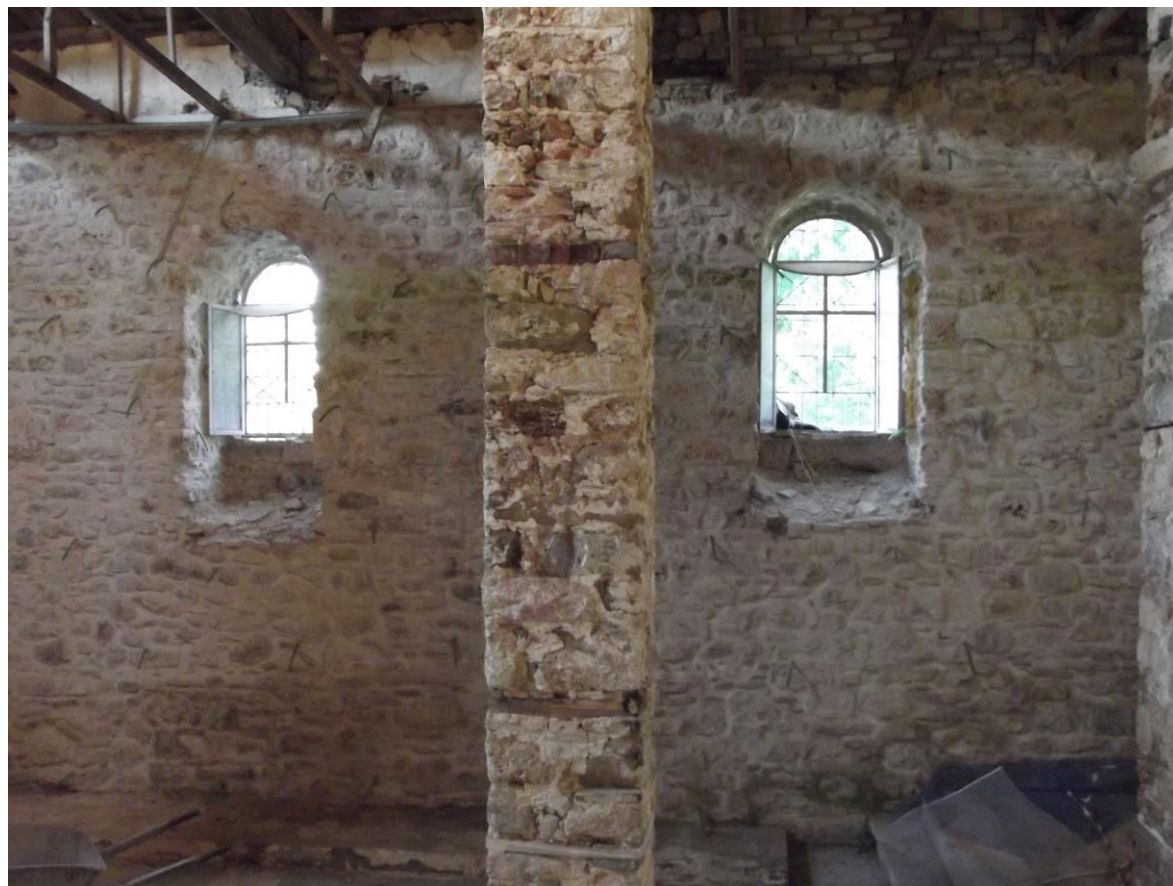
Εικόνα 46: Βόρεια όψη εσωτερικά
