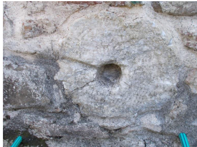
Εικόνα 13: Σφόνδυλος με αύλακα μολυβδοχόησης στη βόρεια όψη
