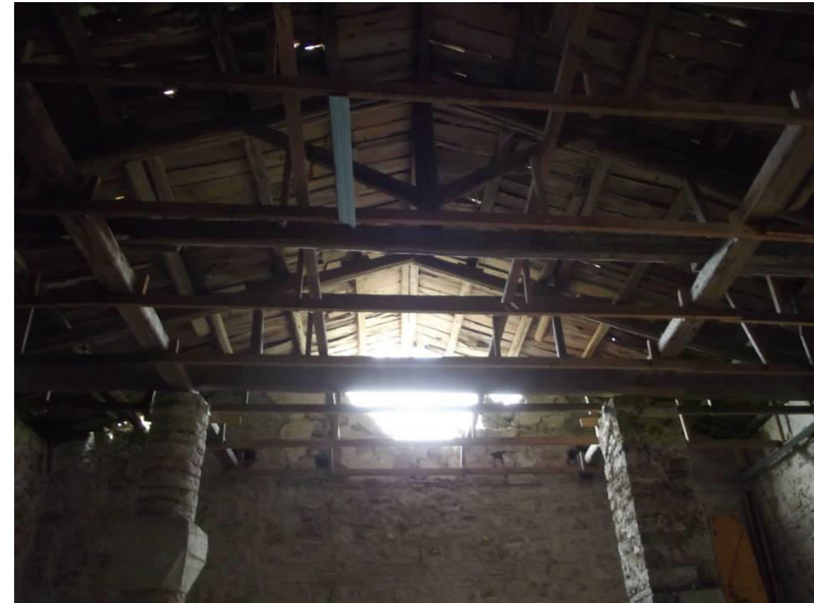
Εικόνα 33: Άποψη εσωτερικά στέγης
