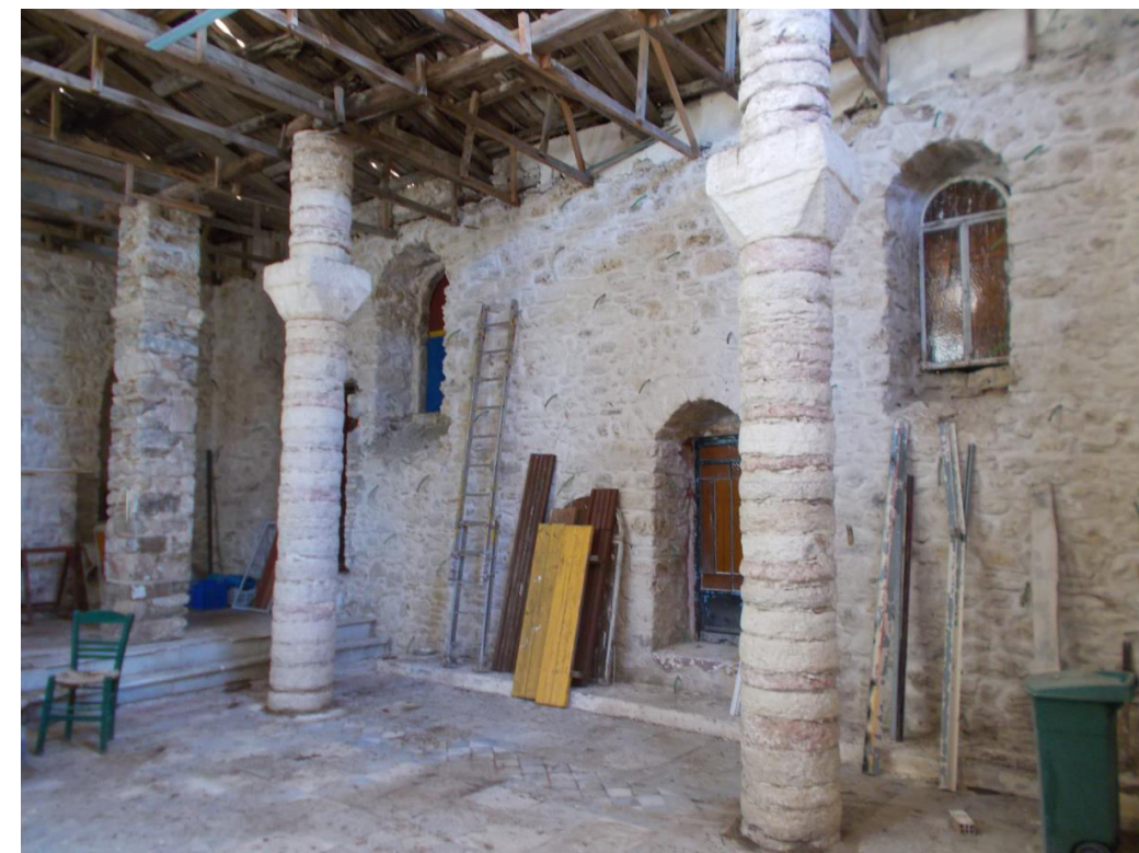
Εικόνα 35: Νότια όψη εσωτερικά του ναού.
