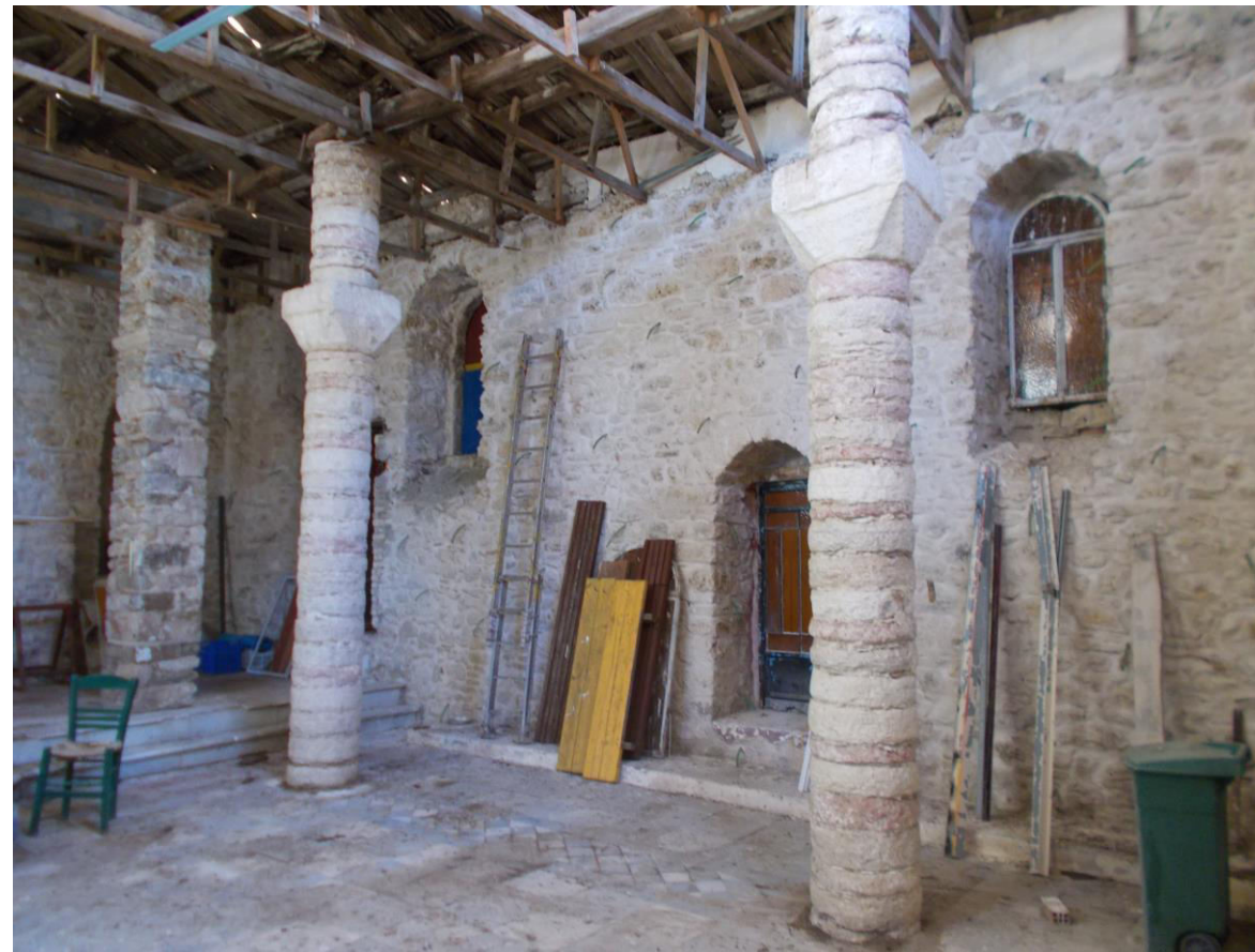
Εικόνα 44: Νότιο όψη εσωτερικά
