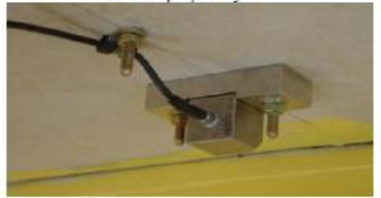
Αισθητήρες παραμόρφωσης στις ράβδους σύνδεσης καταστρώματος
