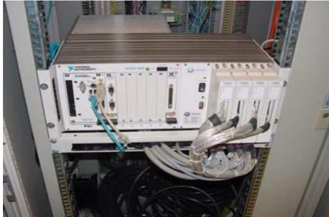
Εικόνα 11: Μονάδα ψηφιοποίησης και καταγραφής δεδομένων.
