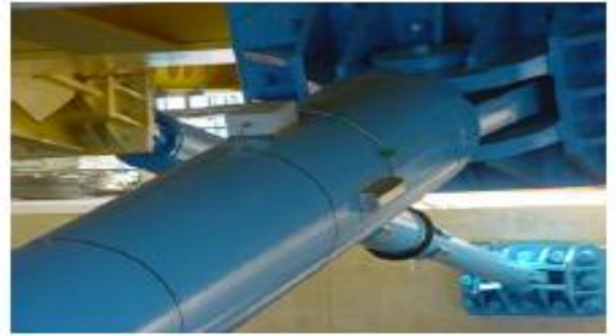
Αισθητήρες παραμόρφωσης στις ράβδους σύνδεσης καταστρώματος
