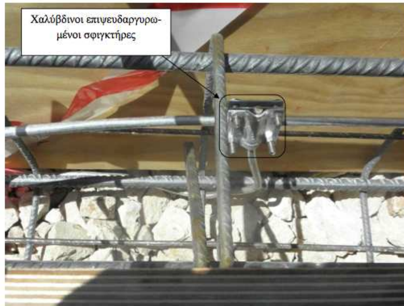
Σχήμα 66: Συμβολή χάλυβα και χαλκού εντός του σκυροδέματος
