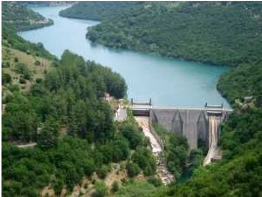
Σχήμα 12: Υ/Δ σταθμός Λάδωνα
