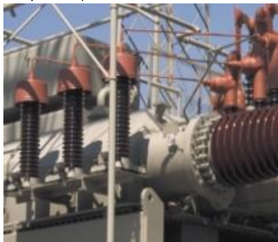
Εικόνα 3.15: Διαμορφωμένα πολυμερικά καλύμματα, σε διάφορα σχήματα, για τη μόνωση ακροδεκτών μονωτήρων ή αλεξικέραυνων, πυκνωτών, μπαρών κλπ [8]
