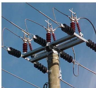
Εικόνα 4.1: Μονωτήρες διελεύσεως και τέρματος για εναέρια δίκτυα Χαμηλής, Μέσης και Υψηλής Τάσης . [8]
