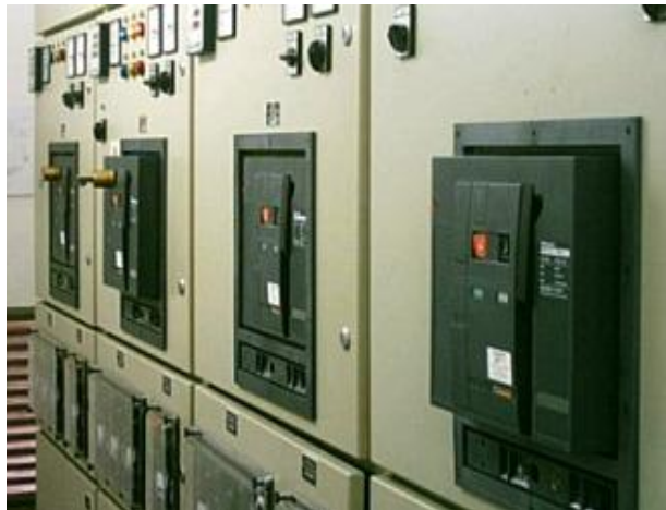
Εικόνα 4.2: Συγκροτήματα διακοπών εσωτερικού χώρου. [12]
