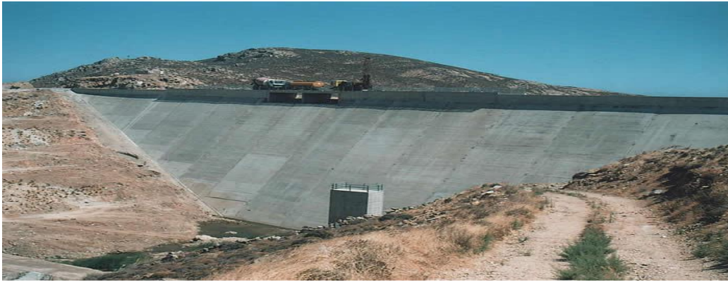
Εικόνα 2.1.2 Φράγμα από σκυρόδεμα
