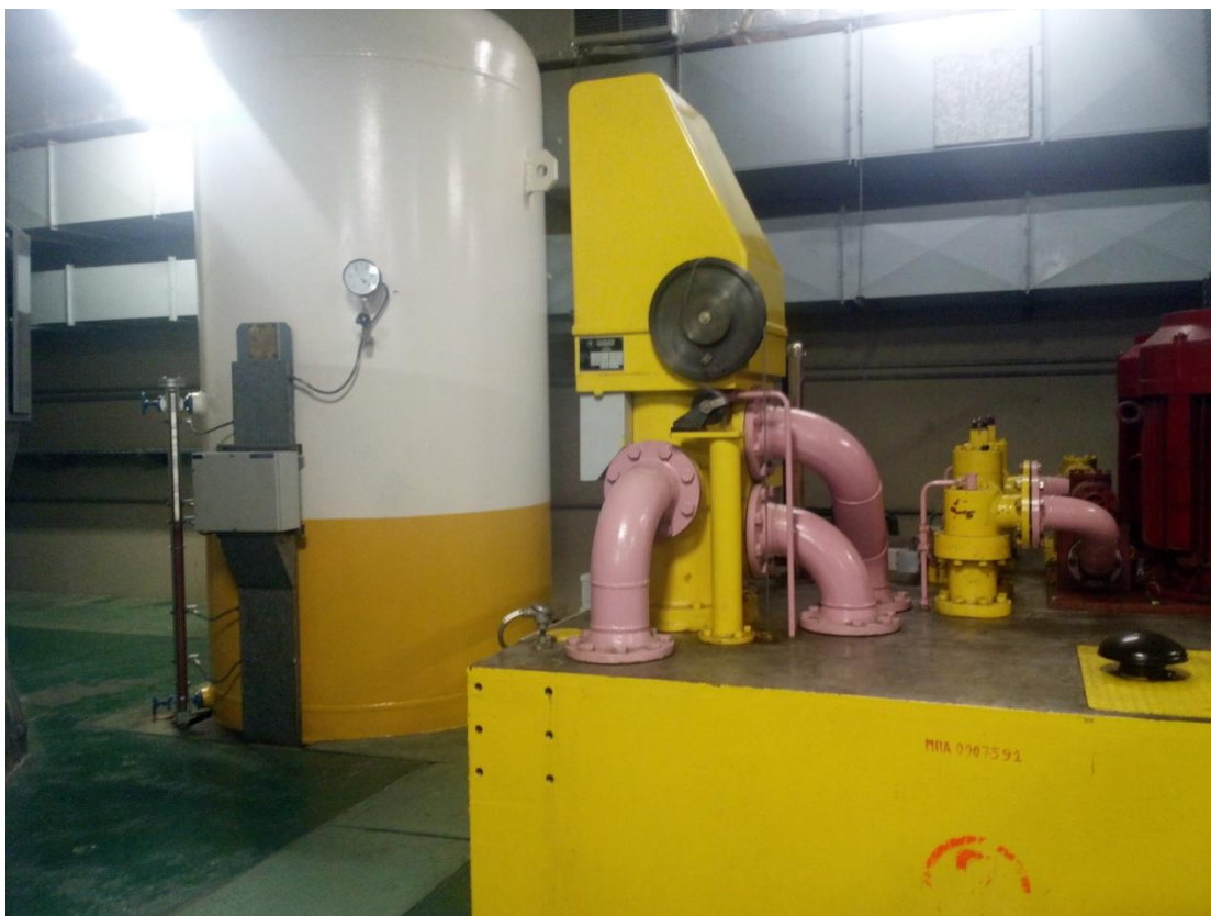
Εικόνα 3.6.6 Ρυθμιστής στροφών
