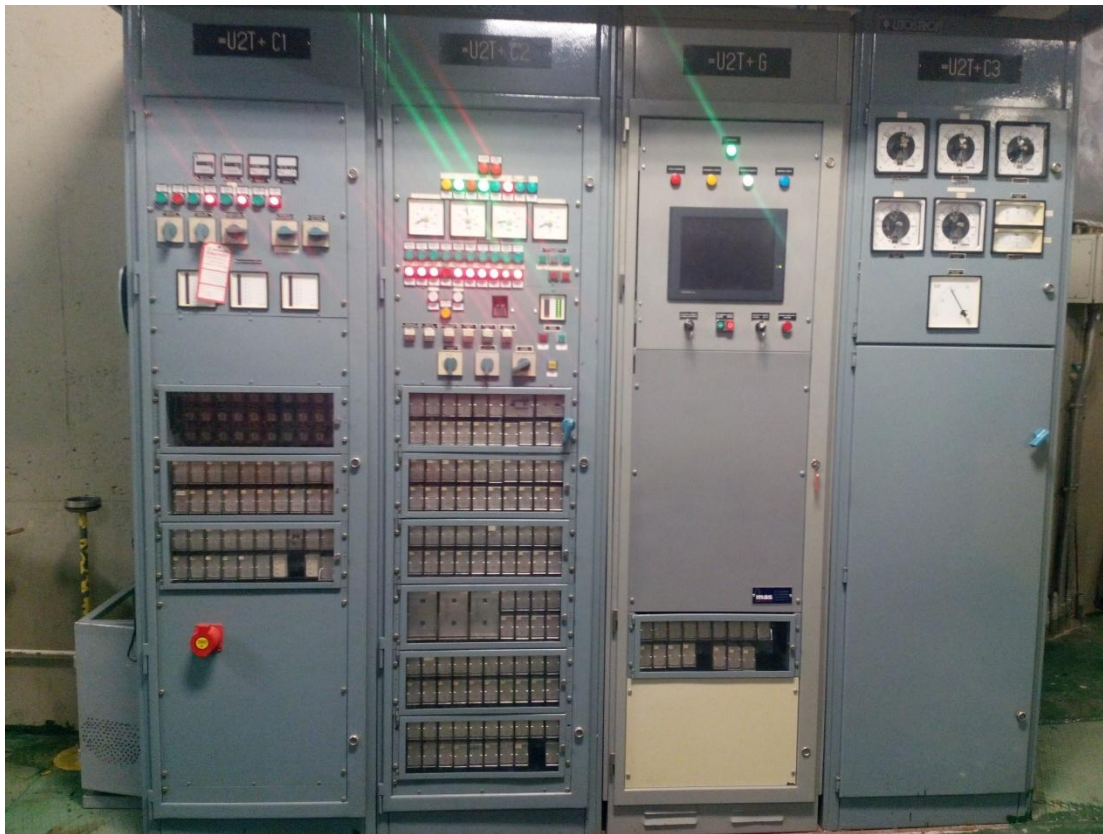
Εικόνα 3.6.2.1 Ηλεκτρονικός ρυθμιστής στροφών
