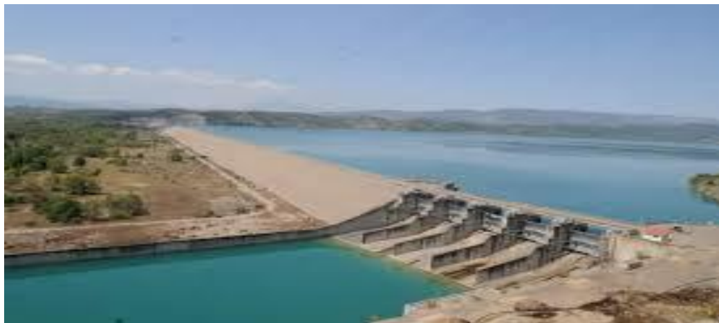
Εικόνα 2.1.2 Φράγμα από γαιώδη υλικά
