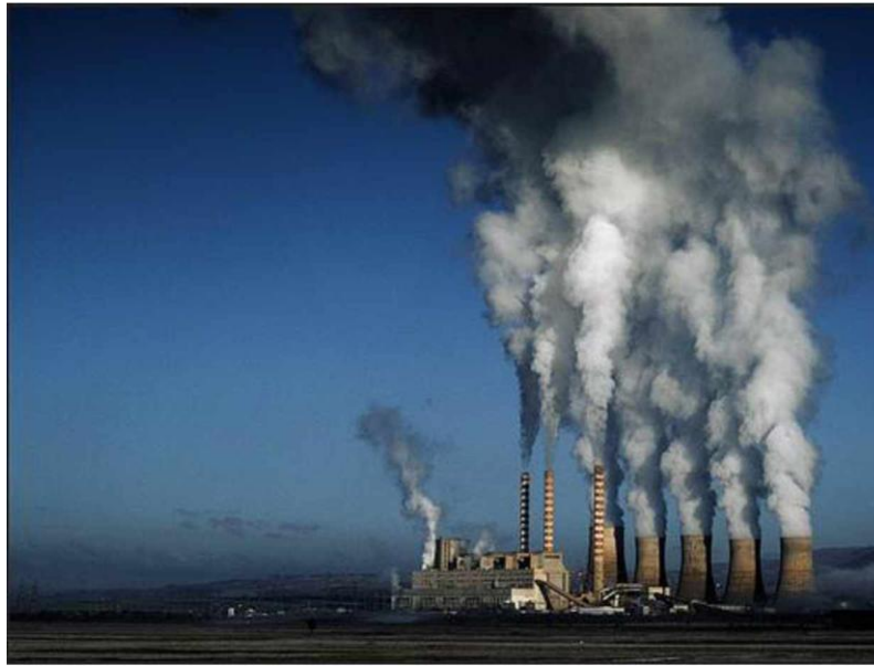
Εικόνα 1.1: Θερμοδυναμικό εργοστάσιο παραγωγής ηλεκτρικής ενέργειας στην Ελλάδα.
