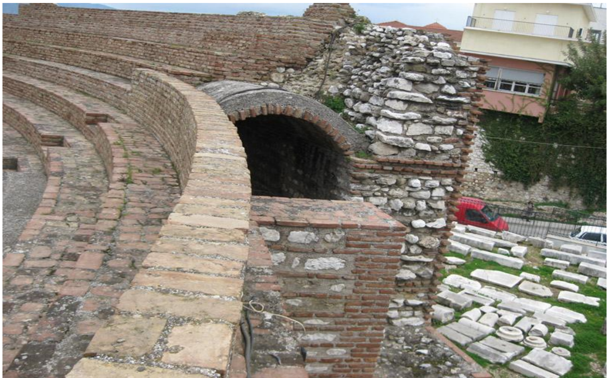
Άποψη του άνω κοίλου: φαίνεται η στήριξή του σε θολωτό διάδρομο
