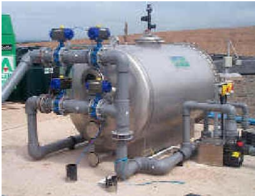
Σχήμα 3.6 - Φίλτρο πίεσης από ατσάλι ( www.drynenaqua.com )
