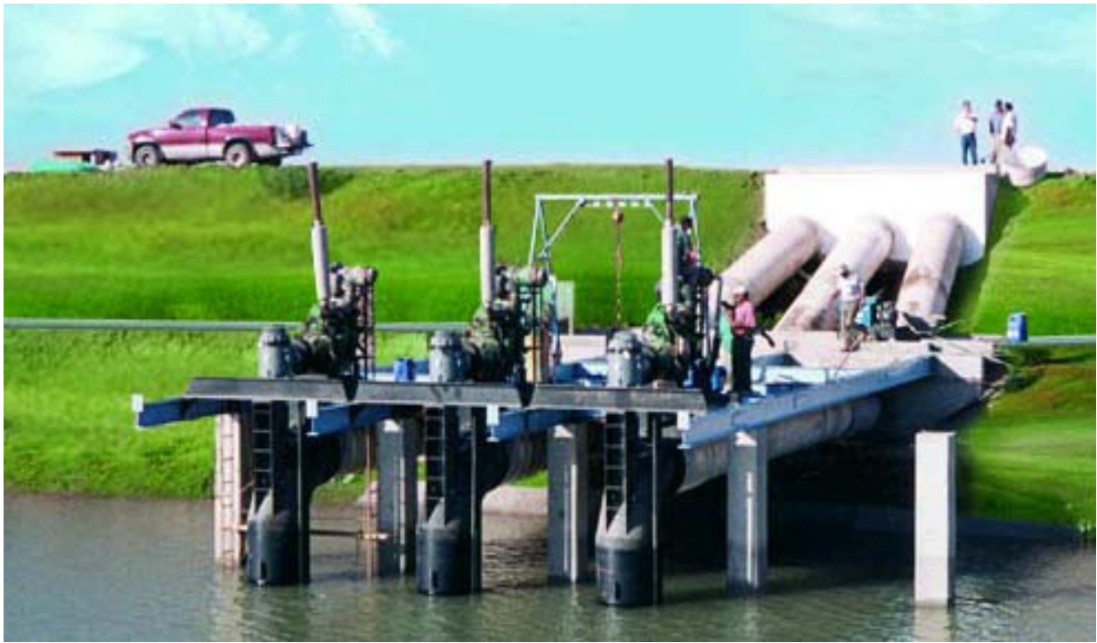
Σχήμα 2.24- Κεντρικό αντλιοστάσιο με αξονική αντλία με προωστήρα
