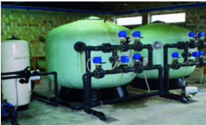
Σχήμα 3.4 - Φίλτρο άμμου με σταθερή πίεση
