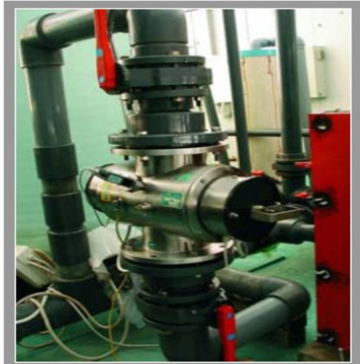
Σχήμα 3.18- Λαμπτήρας UV
