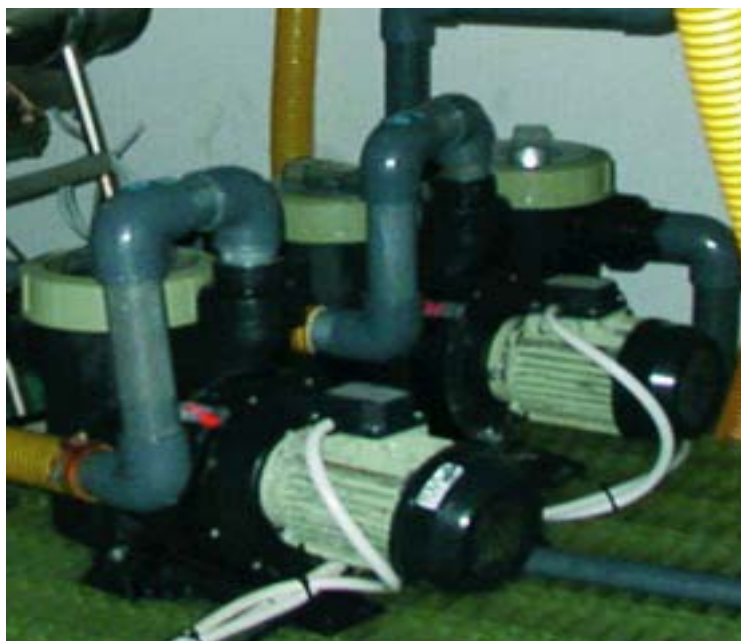
Σχήμα 2.26- Φυγοκεντρική αντλία
