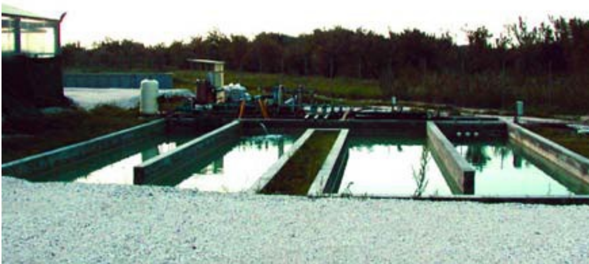
Σχήμα 3.17- Δεξαμενές ιζηματοποίησης από μπετό
