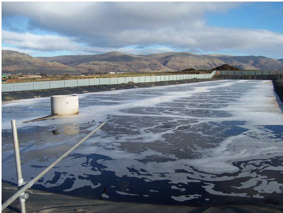
Σχήμα 3.16 – Λίμνες καθίζησης
