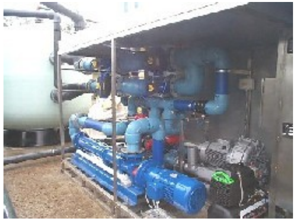
Σχήμα 3.7 - Φίλτρο πίεσης από λεπτό ατσάλι ( www.drynenaqua.com )
