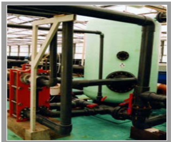
Σχήμα 3.11 - Βιοφίλτρο πίεσης και εναλλάκτης θερμοτήτας ( www.drynenaqua.com )
