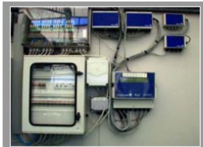
Σχήμα 3.28 – Σύστημα ελέγχου οξυγόνου
