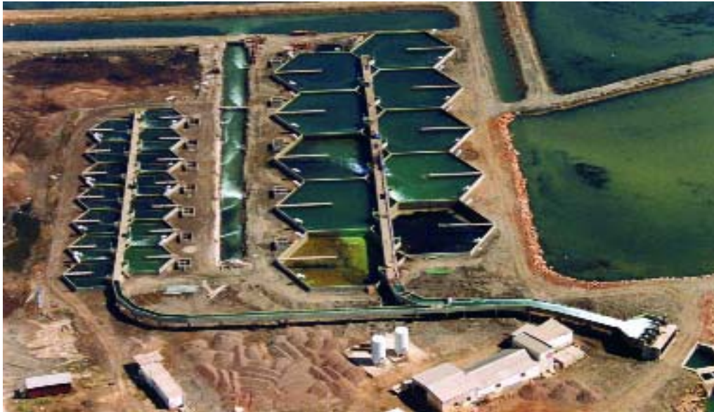
Σχήμα 2.16- Αεροφωτογραφία μιας καλλιέργειας που δείχνει το κύριο αντλιοστάσιο
