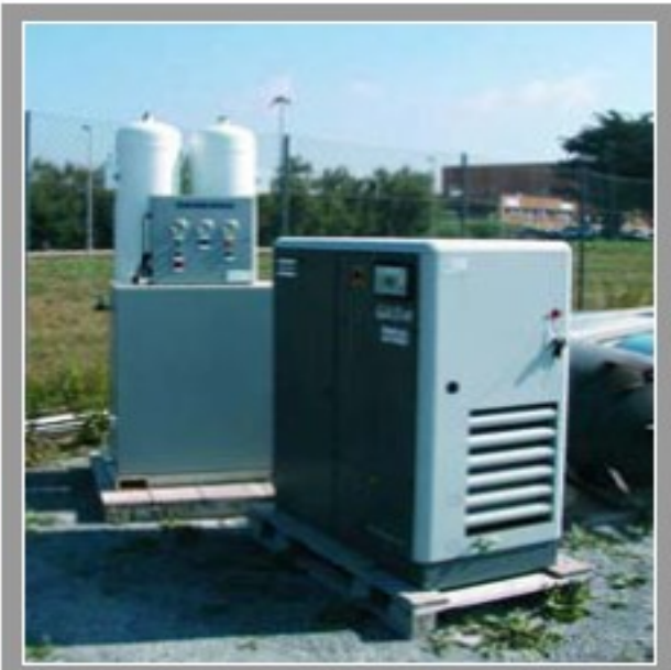
Σχήμα 3.22- Γεννήτρια οξυγόνου
