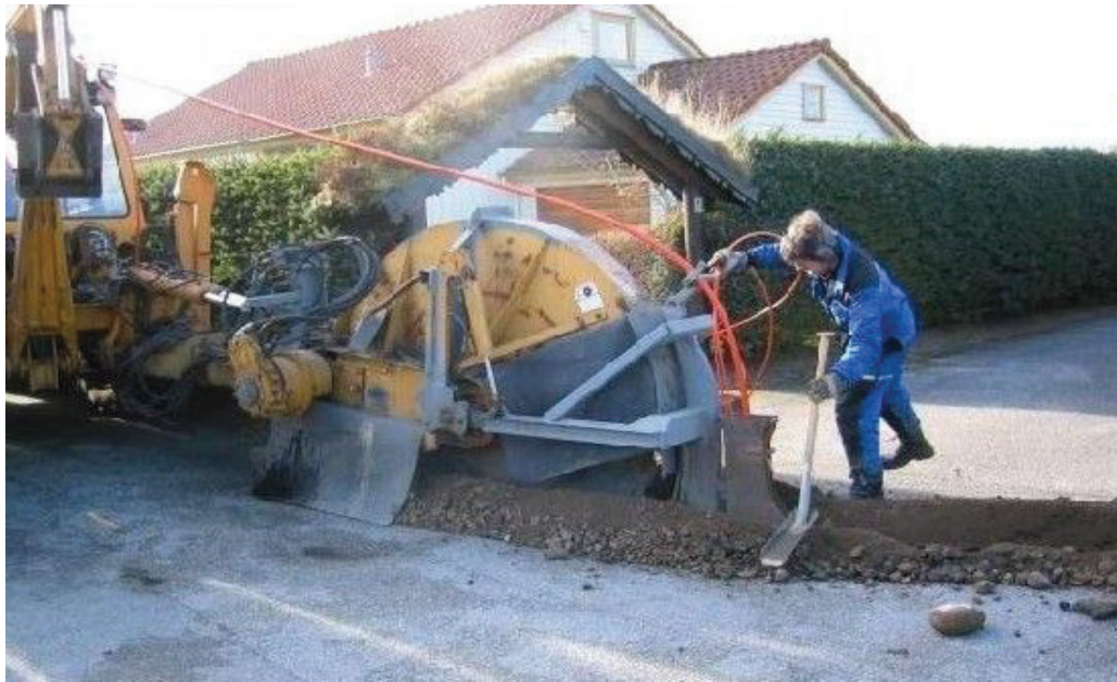
Σχήμα 3.20: Μηχάνημα τύπου mini-trencher
