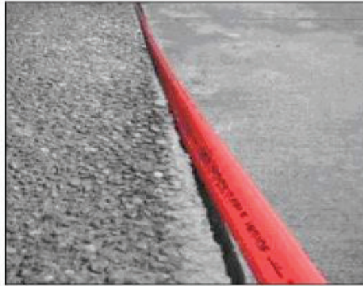
Σχήμα 3.13: Μικροσωλήνας M4
