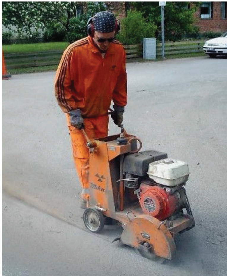
Σχήμα 3.21: Μέθοδος micro-trencher
