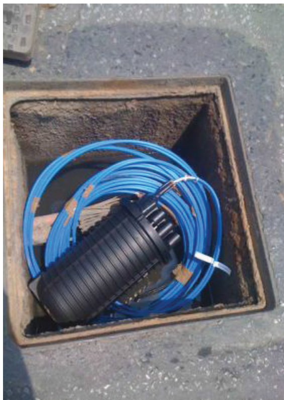
Σχήμα 3.23: Μούφα σε φρεάτιο
