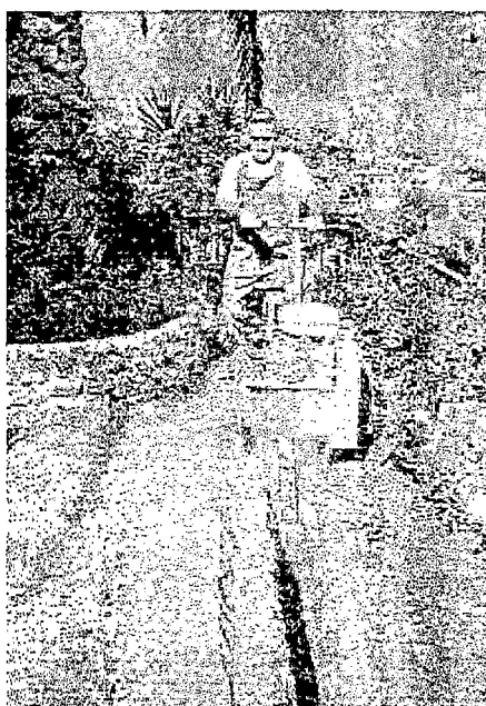
Εικόνα 11.1. Διάνοιξη χαντακιού
