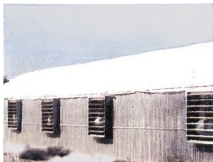
64. Θερμοκήπιο α) με αερισμό δυναμικό με εξαεριστήρες ή β) φυσικός μεσυνδυασμό παραθύρων οροφής και πλαϊνών.
