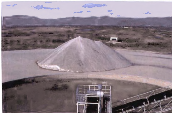
Εικ.4.3 Αλικές Πολιχνίτου. Τμήμα εγκαταστάσεων
