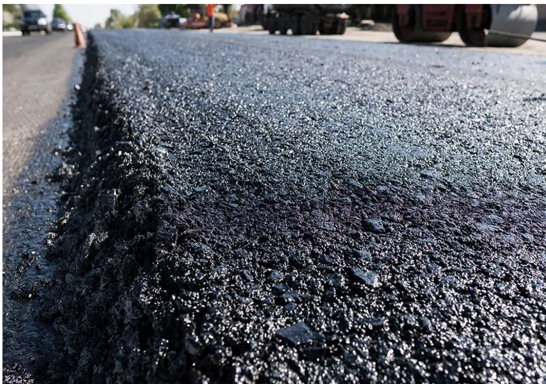
Εικόνα 4.2: Ασφαλτικό υλικό που περιέχει πολυμερή
