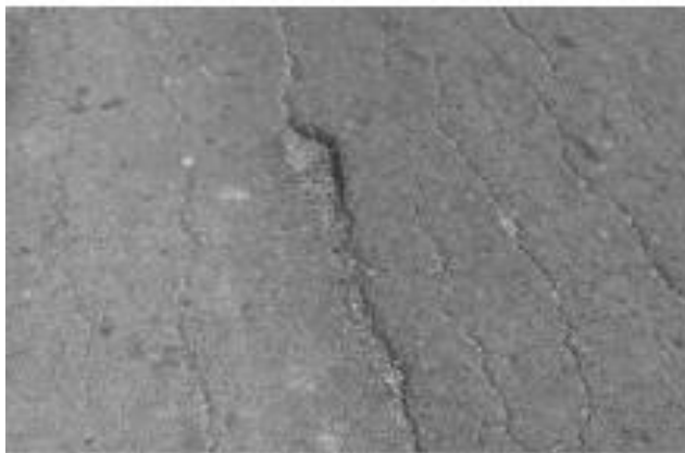
Εικόνα 3-3: Παράδειγμα διαμήκους ρωγμής.
