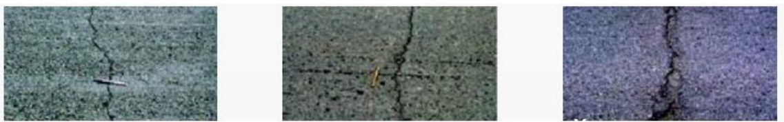
Εικόνα 3-4: Εγκάρσιες ρηγματώσεις.
