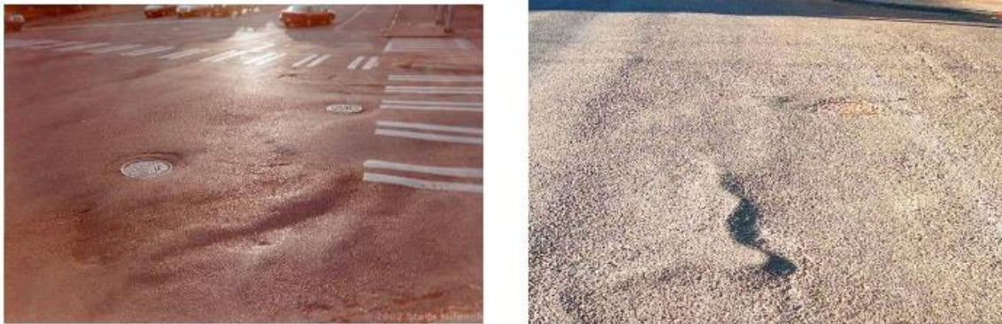
Εικόνα 3-11: Κατά πλάτος αυλακώσεις- κυματώσεις.
