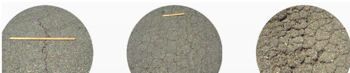
Εικόνα 3-2: Επ'πιπεδα σοβαρότητας ρωγμών τύπου αλιγάτορα.
