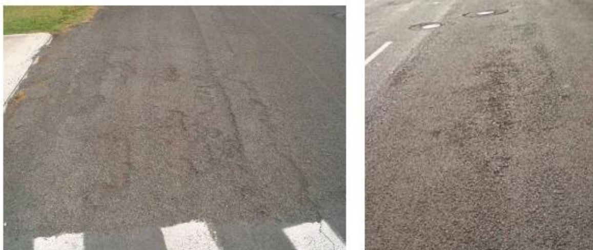
Εικόνα 3-14: Αποκόλληση αδρανών.
