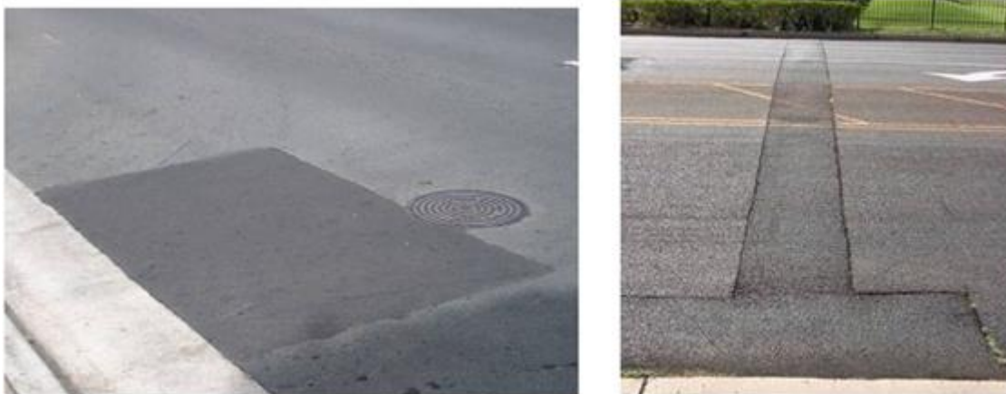
Εικόνα 3-13: Μπαλώματα.
