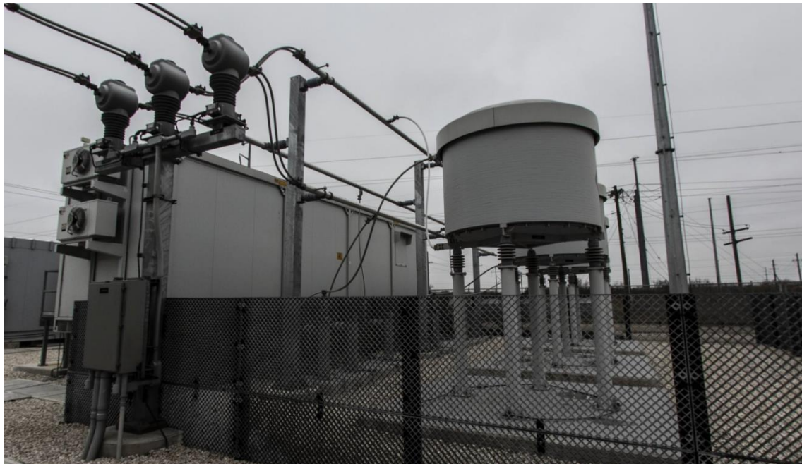
Εικόνα 4.13: Ο STATCOM διασυνδεδεμένος σε έναν υποσταθμό [6]
