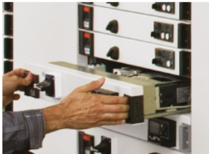
Εικόνα 2.3 Πίνακας διανομής με αποσπώμενες λειτουργικές μονάδες στα συρτάρια.[3]
