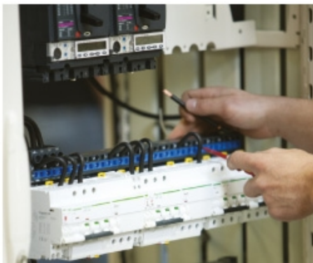
Εικόνα 2.1 Συναρμολόγηση τελικού πίνακα διανομής με σταθερές λειτουργικές μονάδες.[3]
