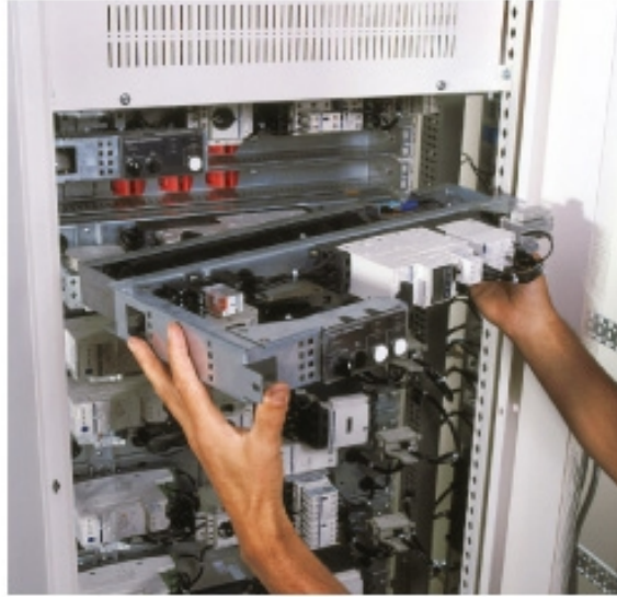
Εικόνα 2.2 Πίνακας διανομής με αποσυνδεόμενες λειτουργικές μονάδες.[3]
