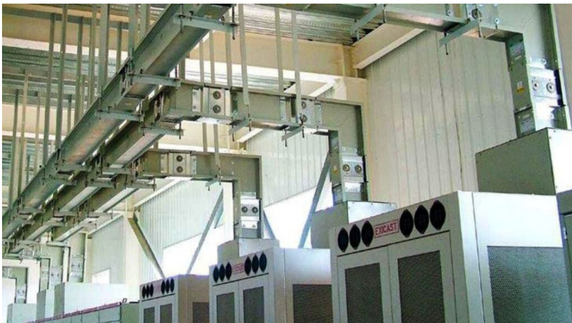
Εικόνα 1.3 Εναέρια κανάλια τροφοδοσίας[1]
