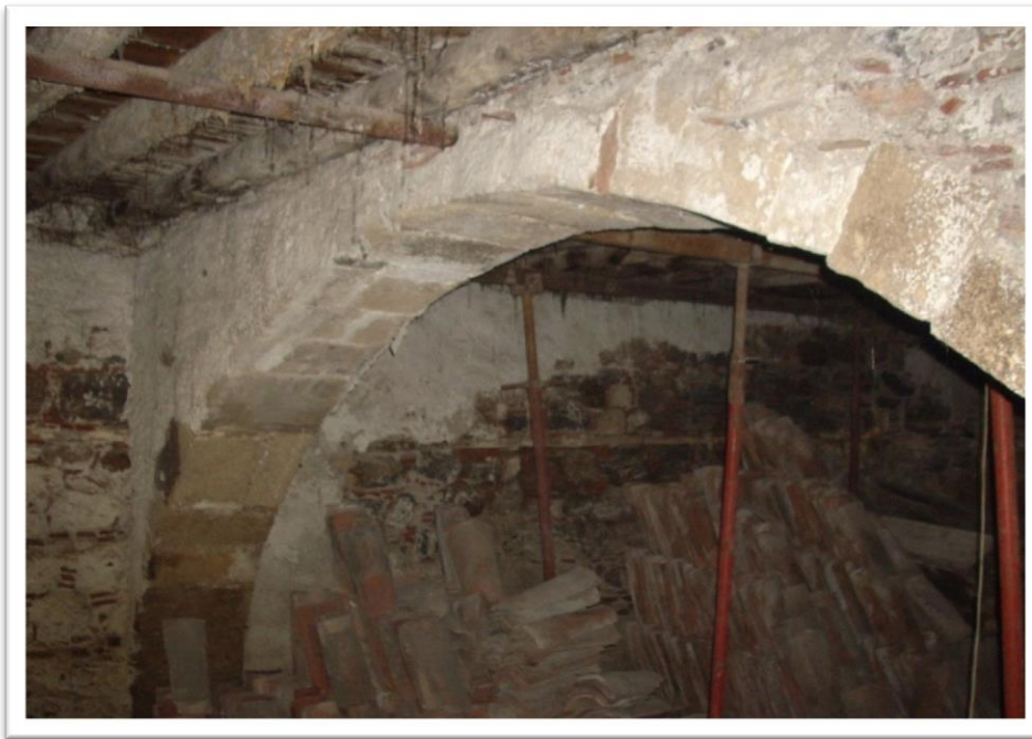
Εικόνα 15. Τοξωτή φέρουσα κατασκευή στο χαμώι. Πηγή: Προσωπικό αρχείο.
