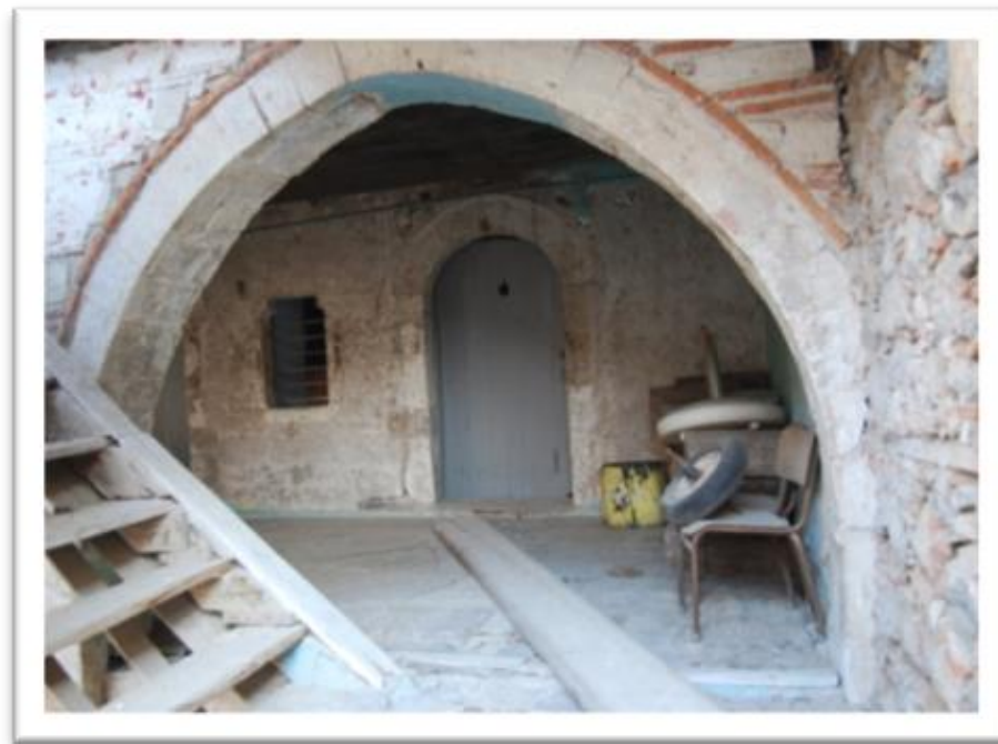
Εικόνα 18. Οξύρυγχη καμάρα στο μετζοπάτωμα. Πηγή: Προσωπικό αρχείο.
