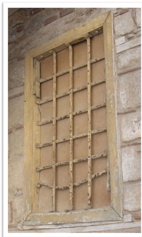
Εικόνα 38. Εξωτερική όψη παραθύρου στο χαμώι. Πηγή: Προσωπικό αρχείο.
