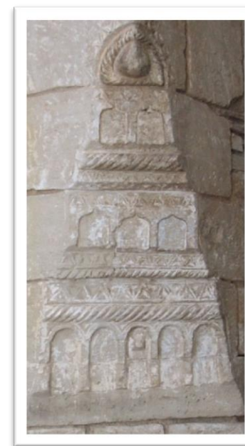
Εικόνα 41. Φαλτσογωνία στην εξωτερική νοτιοανατολική γωνία του χαμωγιού. Πηγή: Προσωπικό αρχείο.
