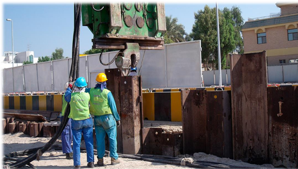
Εικόνα 2.7 – Αφαίρεση πασσαλοσανίδων
