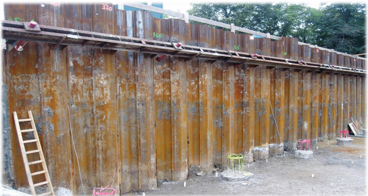
Εικόνα 3.4 (γ) –Αγκυρωμένος πασσαλότοιχος.
