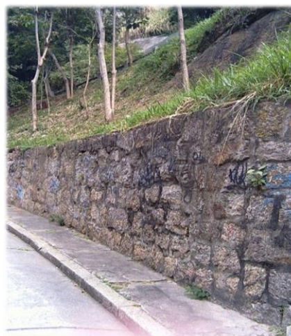
Εικόνα 1.1 – Πέτρινος τοίχος αντιστήριξης τύπου βαρύτητας
