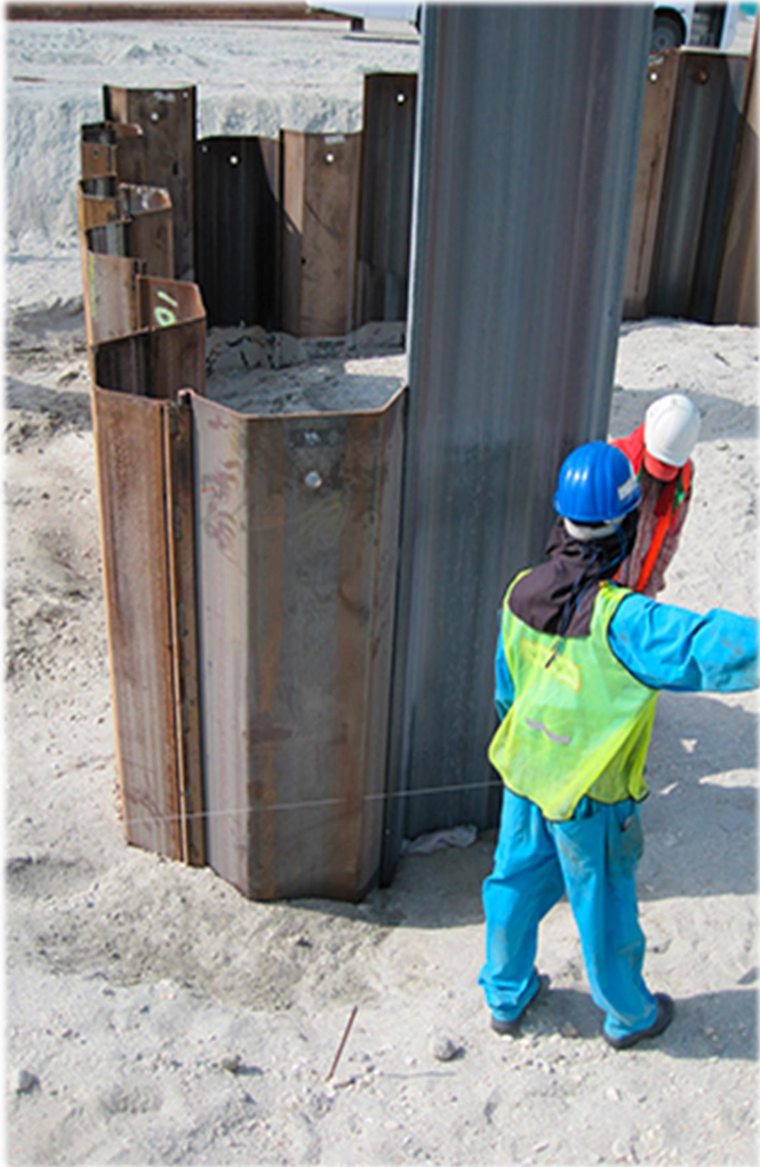
Εικόνα 2.5 (α) – Τοποθέτηση πασσαλοσανίδων.
