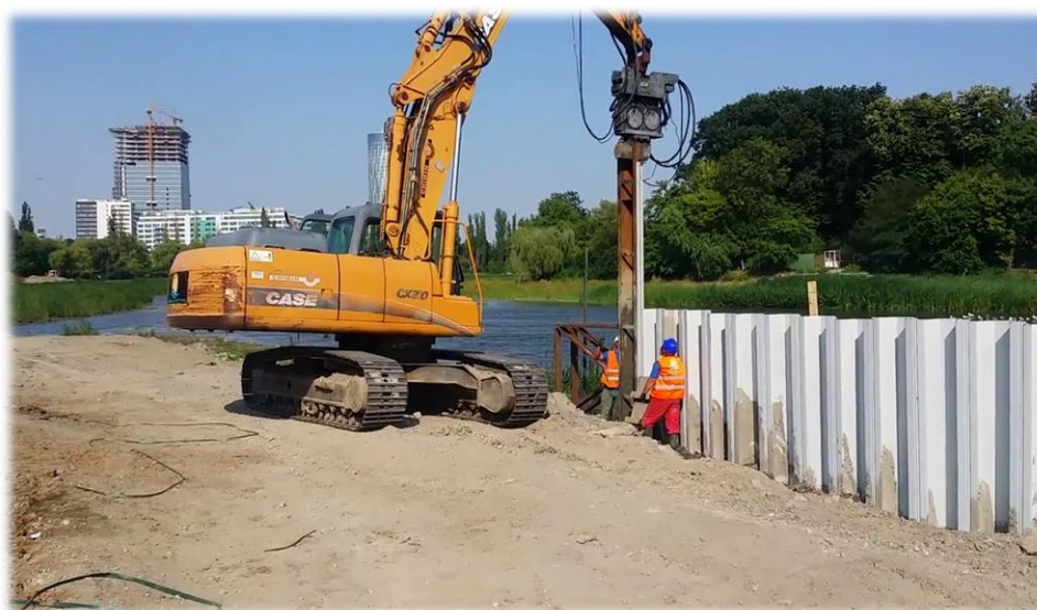
Εικόνα 2.6 (β) – Τοποθέτηση πασσαλοσανίδων.
