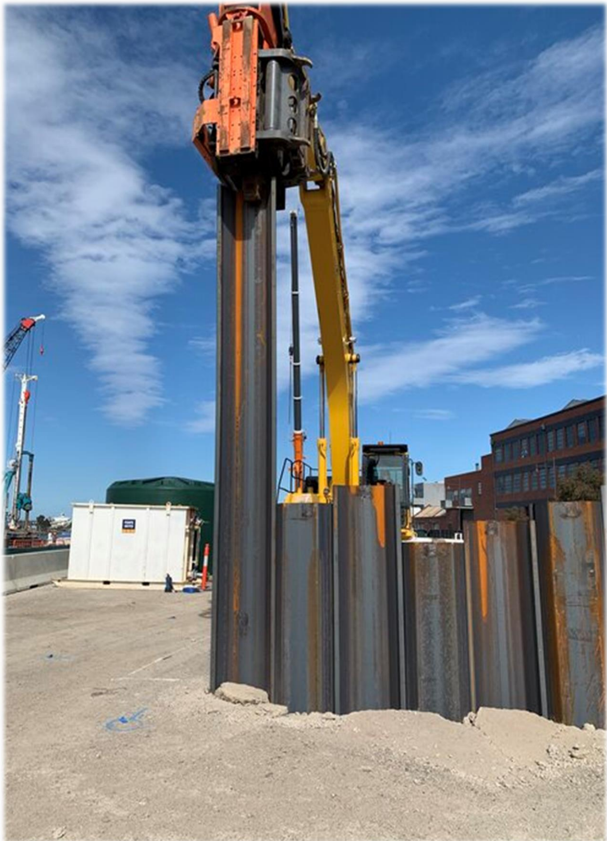
Εικόνα 2.5 (β) – Τοποθέτηση πασσαλοσανίδων.
