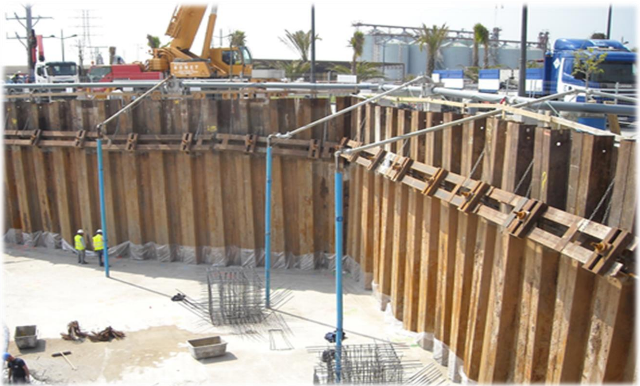
Εικόνα 3.4 (δ) –Αγκυρωμένος πασσαλότοιχος.
