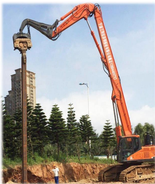
Εικόνα 2.6 (γ) – Εγκατάσταση πασσαλοσανίδων.
