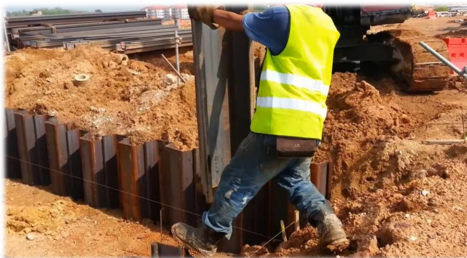
Εικόνα 2.6 (α) – Εγκατάσταση πασσαλοσανίδας.
