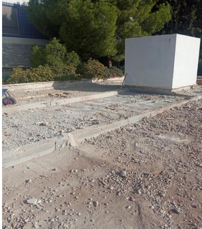
Εικόνα 13. Αφαίρεση στρώσης οπτοπλινθοδομής από την πλάκα ορόφης ορόφου
