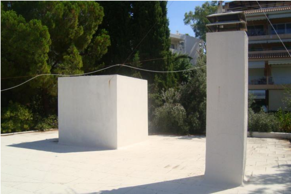
Εικόνα 9. Δεξαμενή και καπνοδόχος στο δώμα
