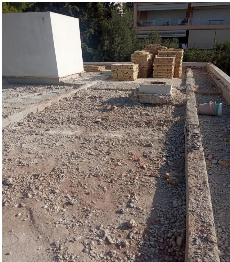
Εικόνα 14. Αφαίρεση στρώσης οπτοπλινθοδομής από την πλάκα ορόφης ορόφου
