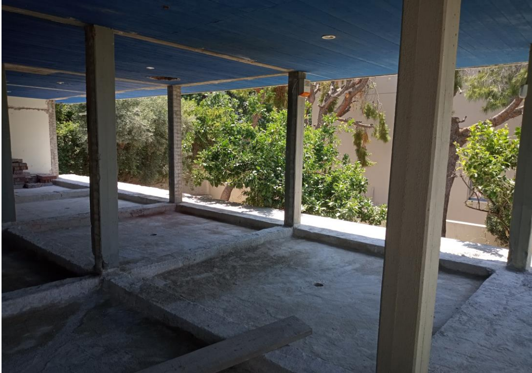
Εικόνα 17. Υποστυλώματα και αποκάλυψη ανεστραμμένων δοκών στην οροφή ισογείου
