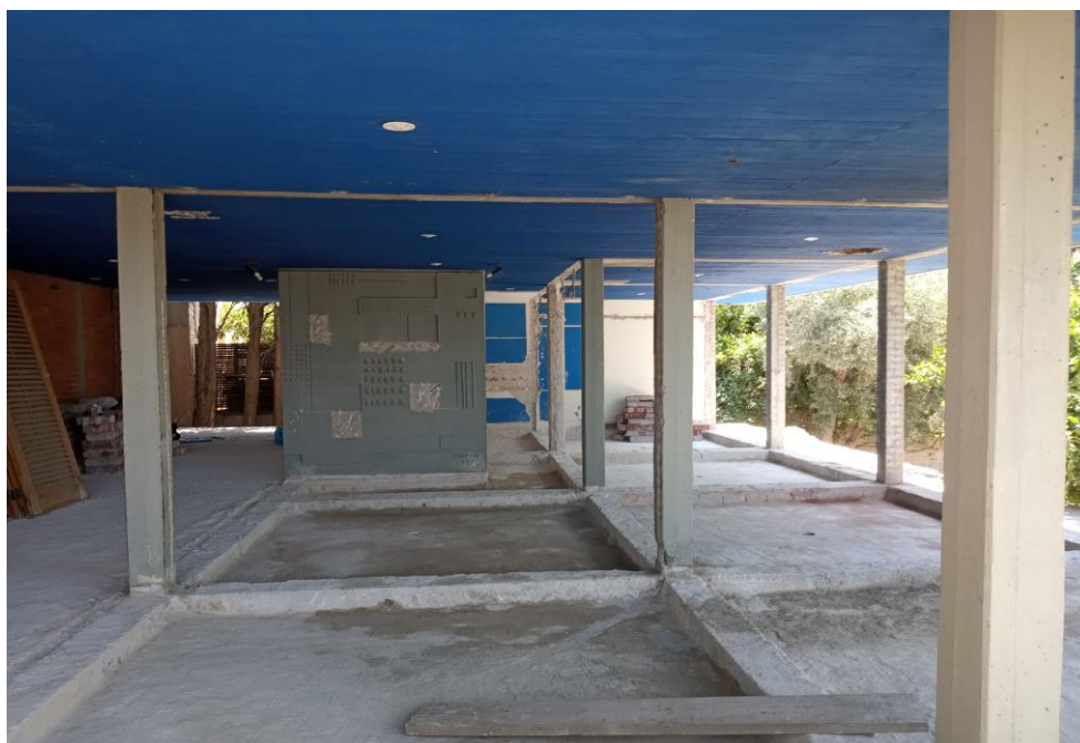
Εικόνα 16. Υποστυλώματα και ποκάλυψη ανεστραμμένων δοκών στην οροφή ισογείου
