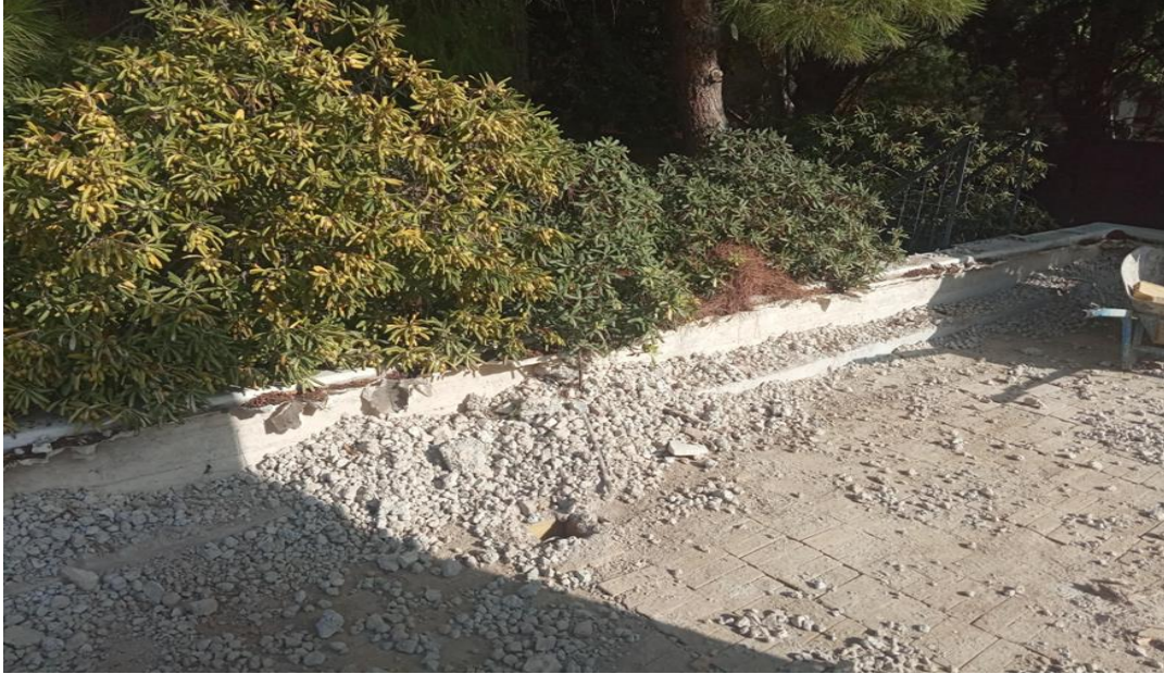
Εικόνα 11. Αφαίρεση στρώσης οπτοπλινθοδομής από την πλάκα ορόφης ορόφου
