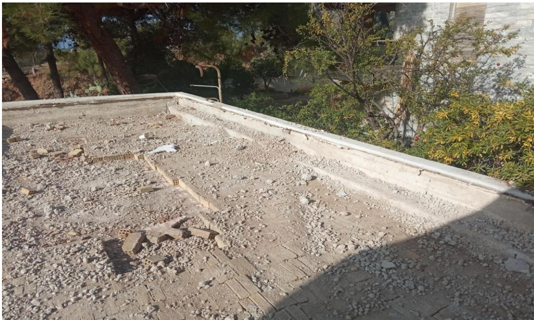
Εικόνα 12. Αφαίρεση στρώσης οπτοπλινθοδομής από την πλάκα ορόφης ορόφου
