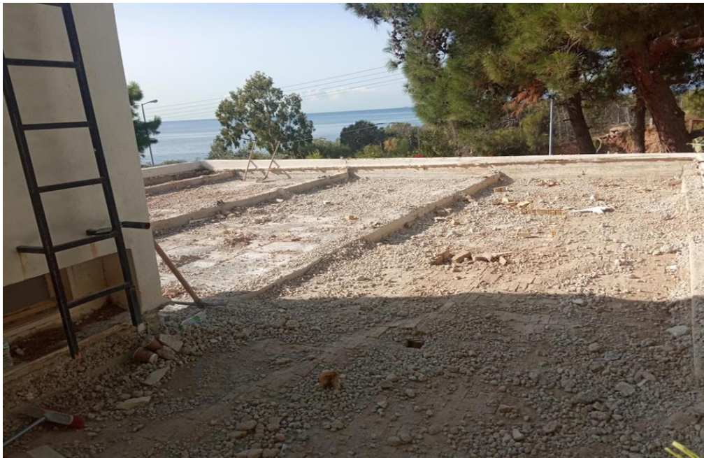
Εικόνα 10. Ανεστραμμένες δοκοί στην οροφή ορόφου
