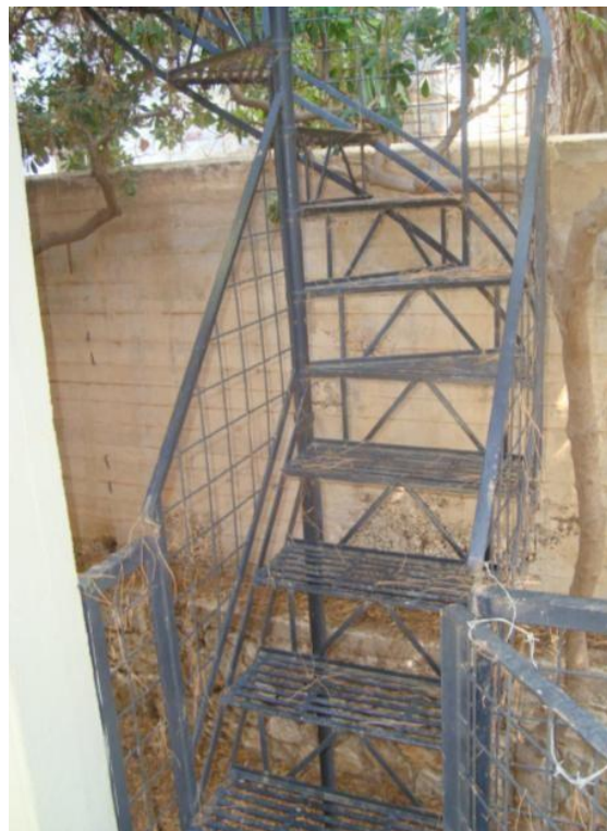
Εικόνα 8. Εξωτερική μεταλλική κλίμακα
