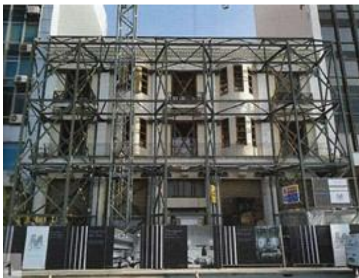
Εικόνα 194: Προσωρινή αντιστήριξη διατηρητέας όψης. (ΚΤΙΠΙΟ 2022, σελ.65)
