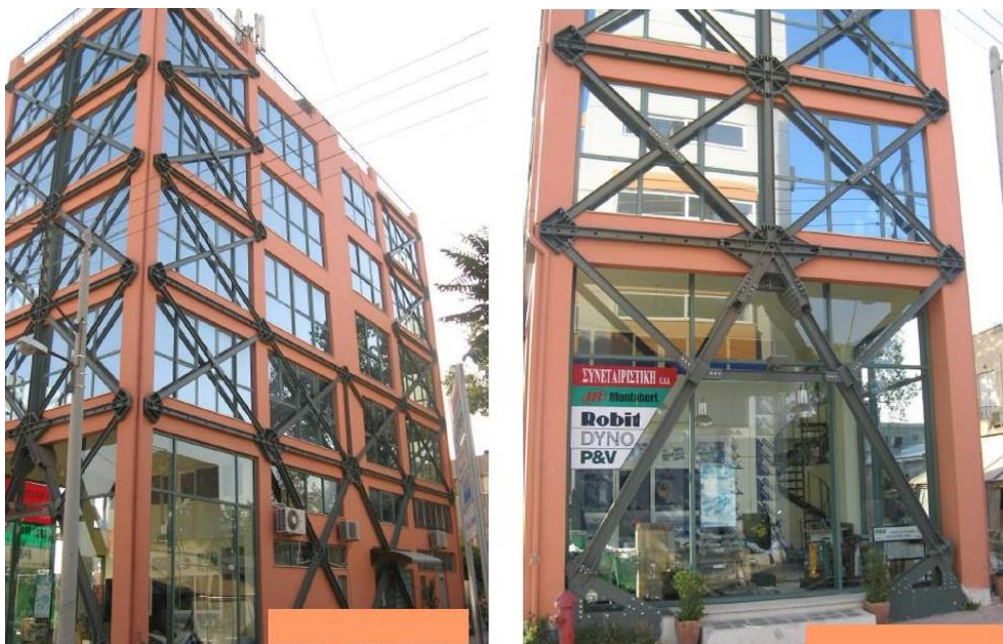
Εικόνα 94: Εξωτερικά μεταλλικά συστήματα σε κτίριο. (αρχείο Μπισκίνη Δ.)
