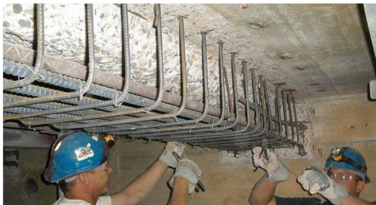
Εικόνα 89: Κατασκευή μανδύα οπλισμένου σκυροδέματος σε δοκό.
