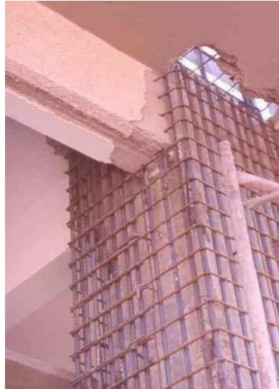
Εικόνα 79: Ενίσχυση με μανδύα από οπλισμένο σκυρόδεμα. (Δρίτσος 2005)
