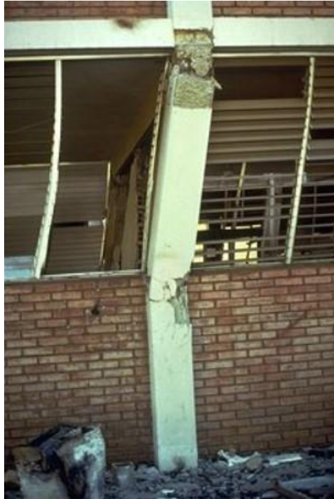
Εικόνα 8: Διατμητική αστοχία κοντού υποστυλώματος. (αρχείο Μπισκίνη Δ.)
