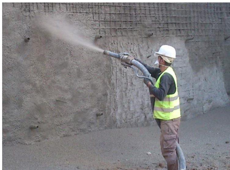
Εικόνα 64: Εφαρμογή εκτοξευόμενου σκυροδέματος. (αρχείο Μπισκίνη Δ.)
