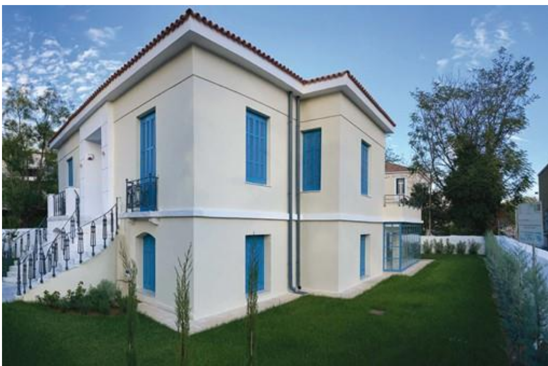
Εικόνα 196: Το κτίριο μετά την αποκατάσταση. (ΚΤΙΡΙΟ 2022, σελ.115)
