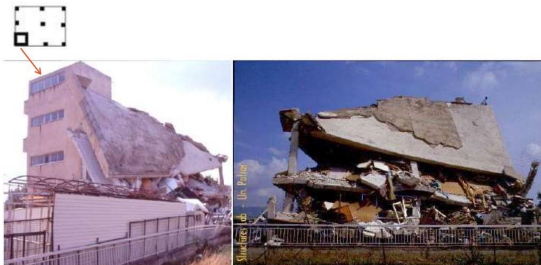
Εικόνα 3: Κατάρρευση κτιρίου κατά τη στρεπτική απόκριση περί το δύσκαμπτο πυρήνα κλιμακοστασίου στη γωνία. (αρχείο Μπισκίνη Δ.)
