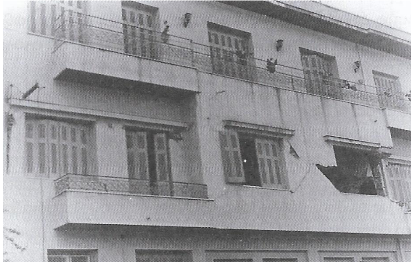
Εικόνα 102: Μερική κατάρρευση έρκερ. (Καραντώνη 2012, σελ.173)
