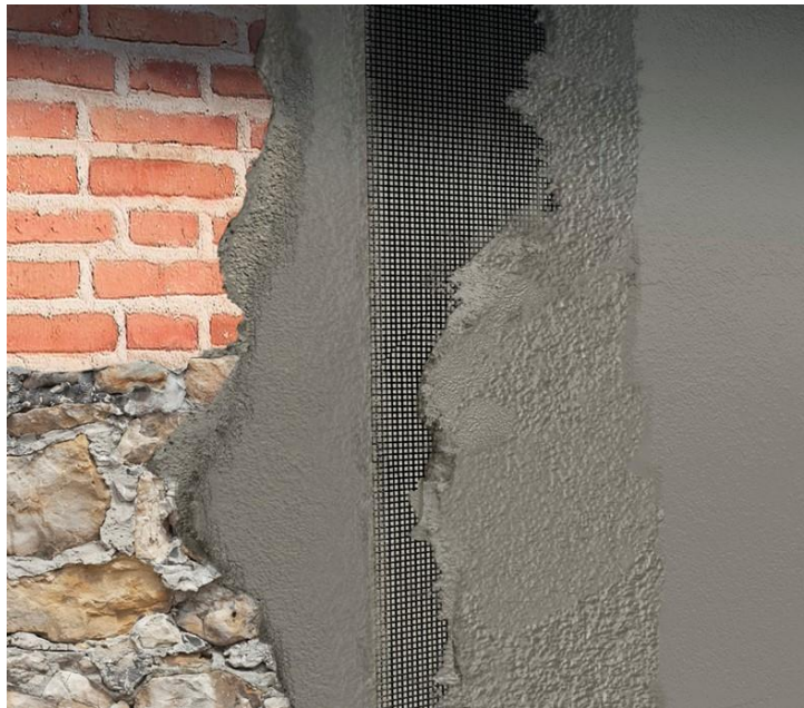
Εικόνα 168: Εφαρμογή ινοπλισμένου επιχρίσματος σε λιθοδομή. (SIKA Hellas)
