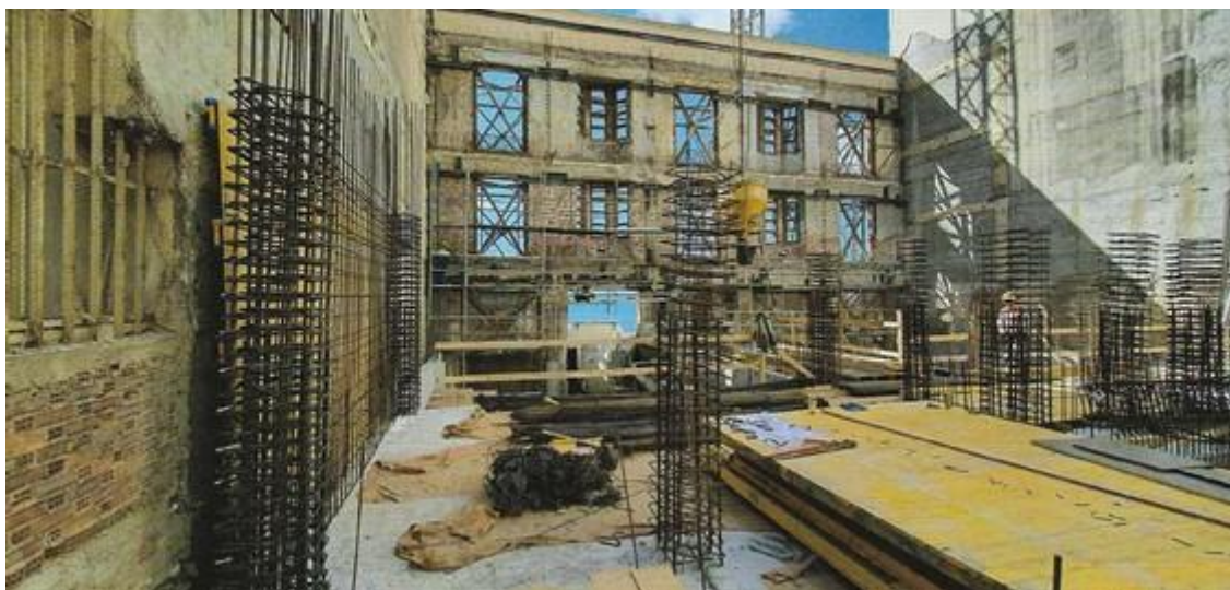
Εικόνα 195: Εσωτερικό της κατασκευής κατά τη φάση της αποκατάστασης. (ΚΤΙΡΙΟ 2022, σελ.64)
