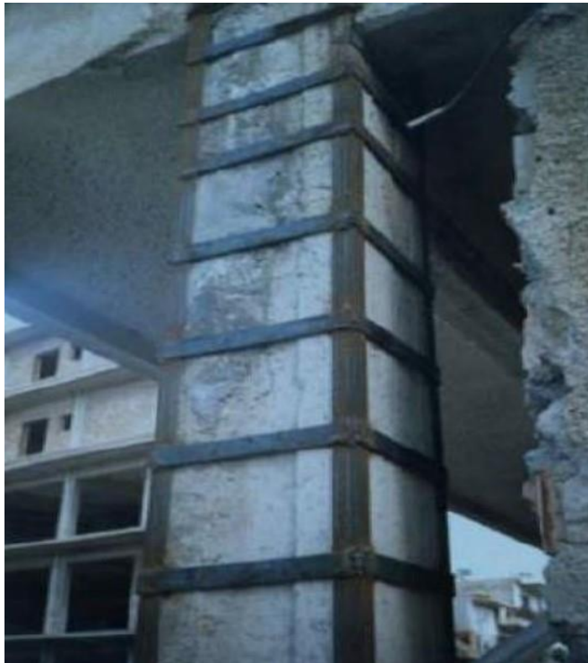
Εικόνα 82: Χρήση μεταλλικού κλωβού. (αρχείο Μπισκίνη Δ.)
