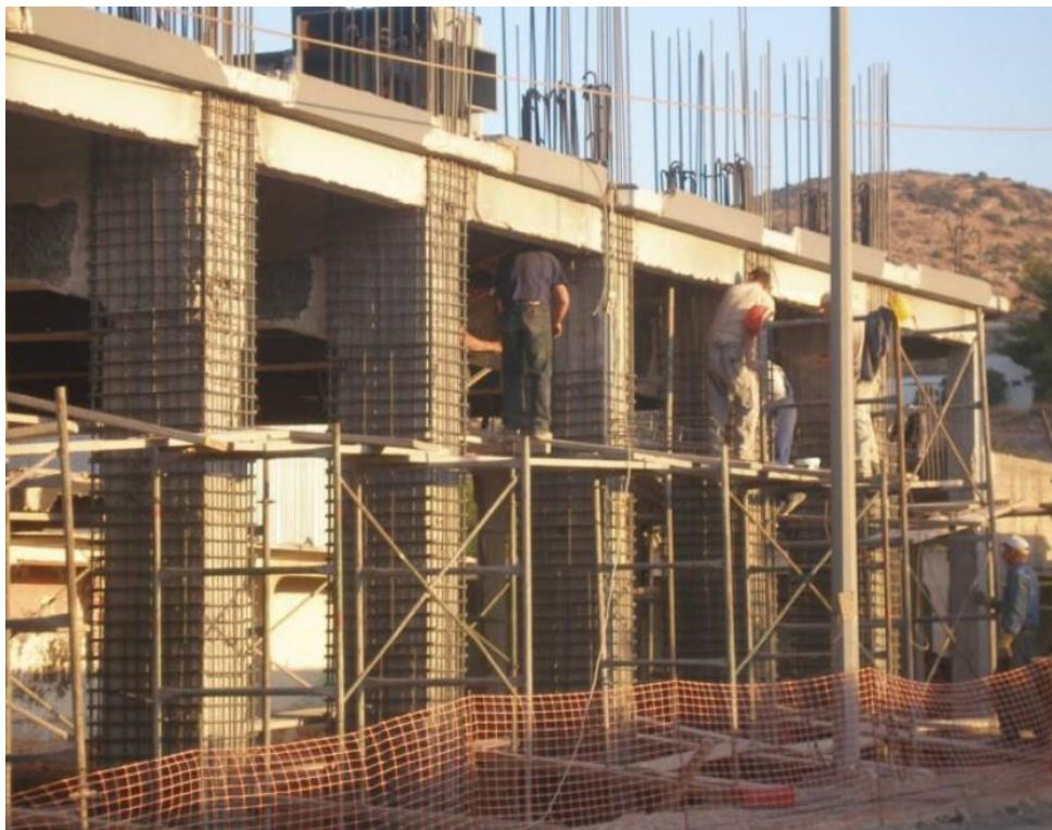
Εικόνα 80: Ενίσχυση με μανδύα από οπλισμένο σκυρόδεμα. (αρχείο Μπισκίνη Δ.)
