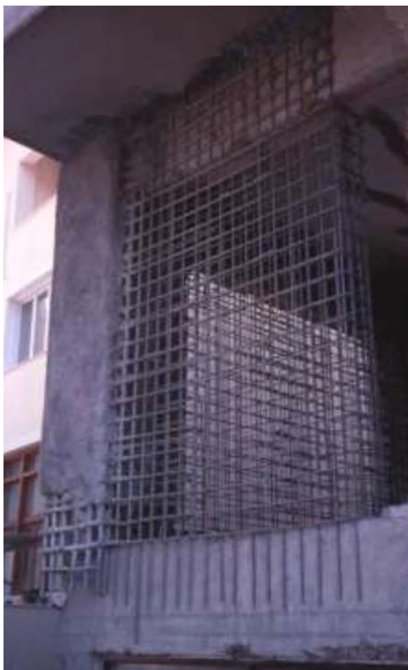
Εικόνα 87: Προσθήκη Τοιχώματος σε Επέκταση Υποστυλώματος. (αρχείο Μπισκίνη Δ.)
