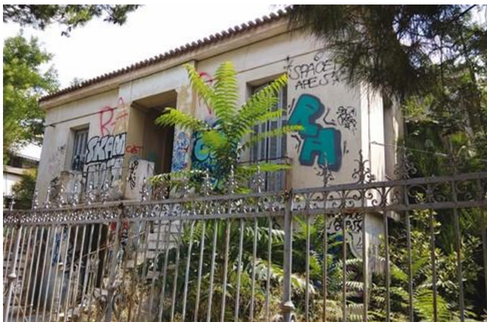
Εικόνα 197: Το κτίριο πριν την αποκατάσταση. (ΚΤΙΡΙΟ 2022, σελ.116)
