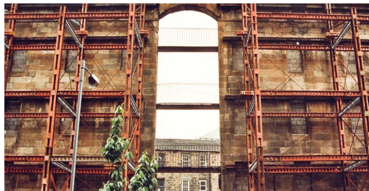
Εικόνα 151: Χρήση μεταλλικών κριωμάτων σε φέρουσα τοιχοποιία. (Αβδελάς)
