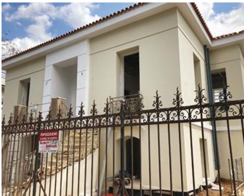
Εικόνα 198: Το κτίριο πριν την ολοκλήρωση της αποκατάστασης. (ΚΤΙΡΙΟ 2022, σελ.122)
