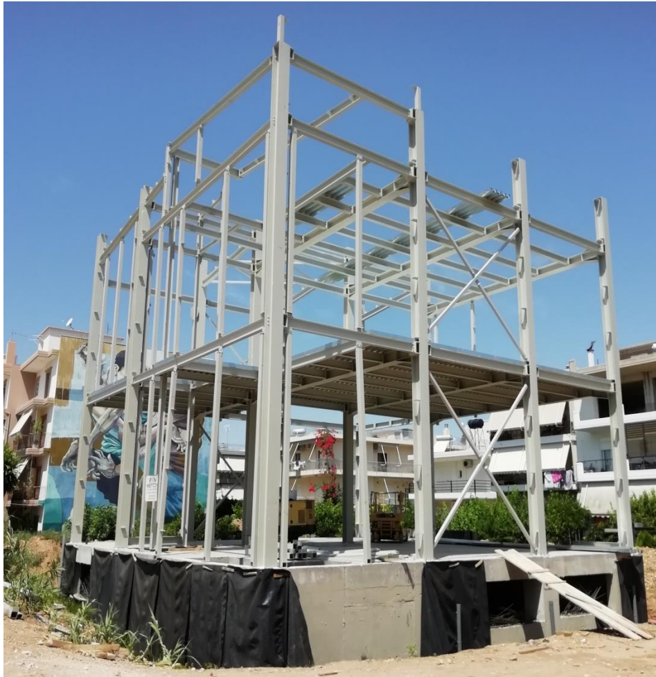
Εικόνα 2: Σκελετός μελετώμενου μεταλλικού κτιρίου
