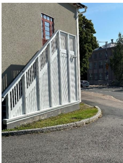
Εικόνα 2.3: Μεταλλική σκάλα με ξύλινη κουπαστή.
