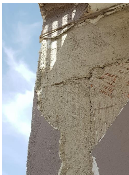
Εικόνα 80: Υποστύλωμα Ισογείου Κ11.
