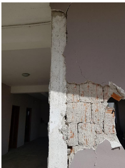
Εικόνα 83: Υποστύλωμα Ισογείου Κ9.
