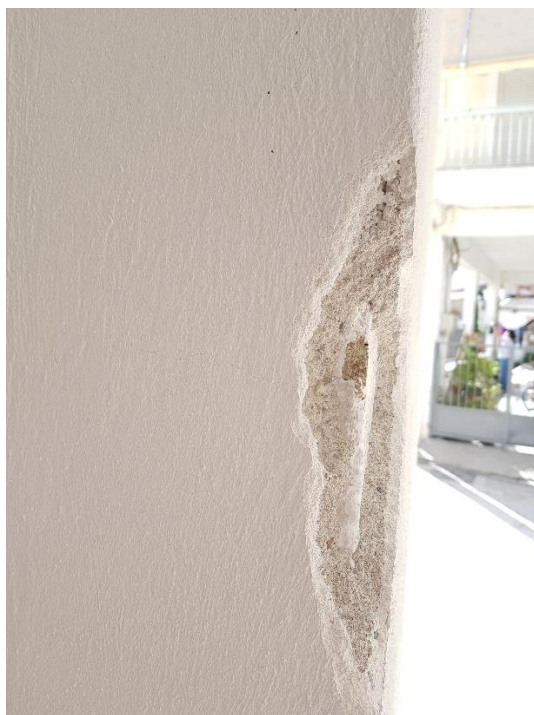
Εικόνα 82: Υποστύλωμα Ισογείου Κ9.
