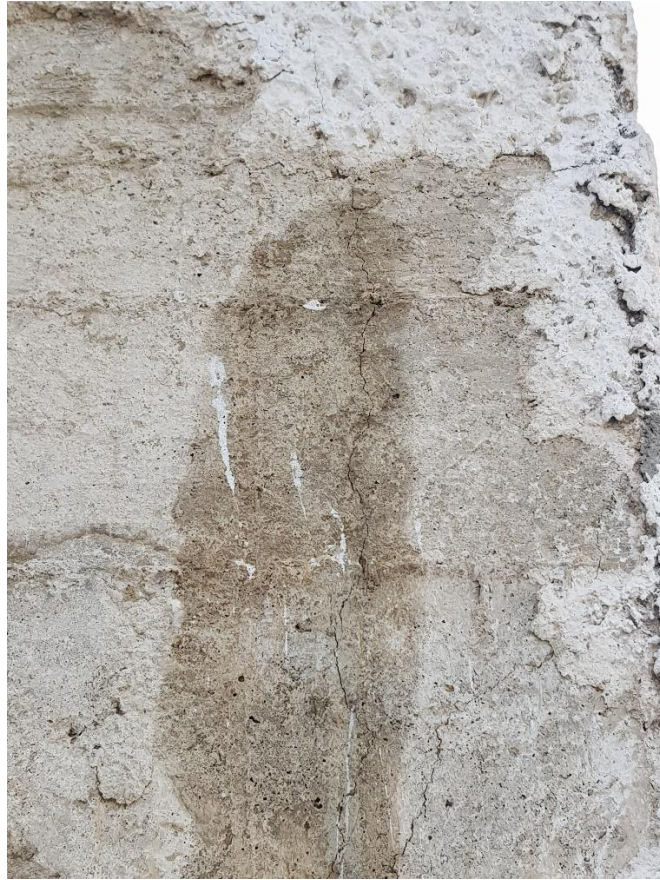
Εικόνα 81: Υποστώμα Ισογείου Κ12.
