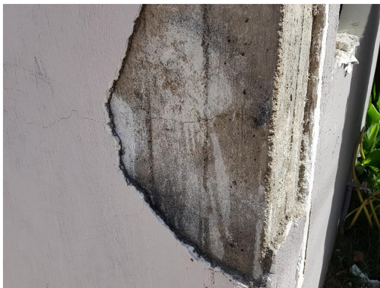
Εικόνα 79: Υποστύλωμα Ισογείου Κ11.
