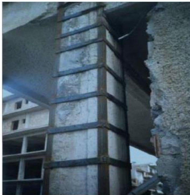
Εικόνα 36: Χρήση μεταλλικού κλωβού. Μπισκίνης 2022.
