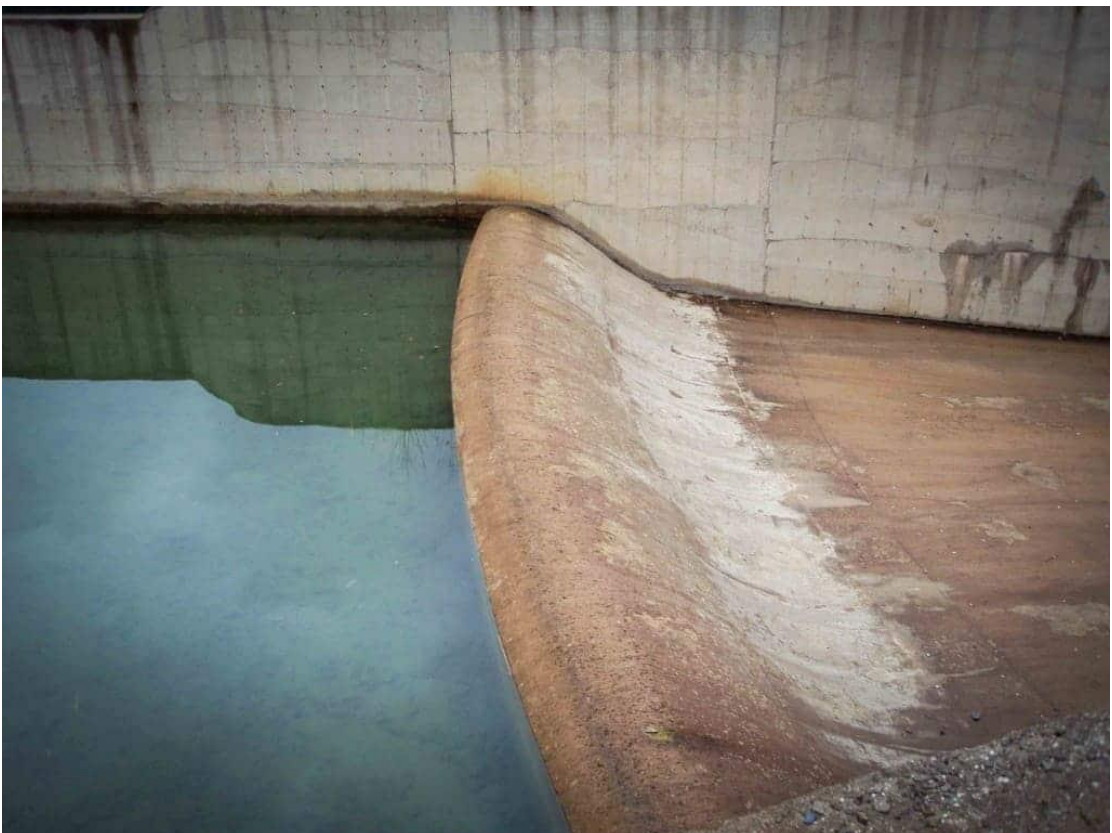
Φράγμα Δόξα Φενεού Κορινθίας: Χωμάτινο φράγμα με αργιλικό πυρήνα.
