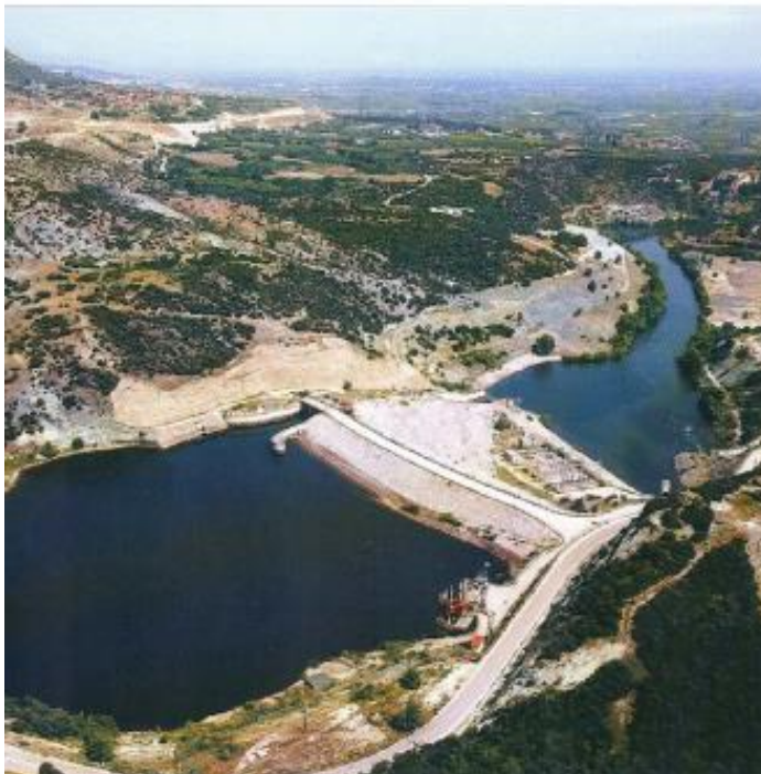
Φράγμα Ασωμάτων, Ποταμός Αλιάκμονας (Υδροηλεκτρική παραγωγή και άρδευση)
