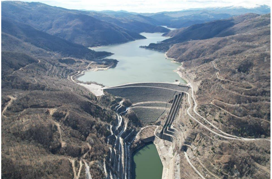
Φράγμα Θυσαυρού, Δράμα
