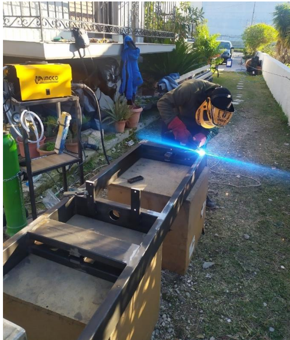
Εικόνα 18. Συγκόλληση κοιλοδοκών πλαισίου (1)
