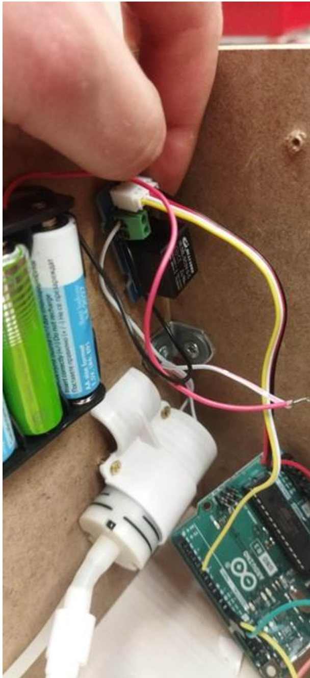
Εικόνα 3.5: Στην παραπάνω εικόνα απεικονίζεται δίπλα από τη μπαταριοθήκη, στο πιο ψηλό σημείο, το ρελέ, το οποίο λόγω του μικρού μεγέθους του, τοποθετήθηκε εκεί με μεγάλη ευκολία.
