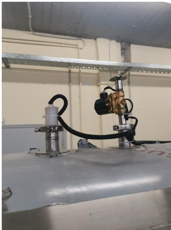
Εικόνα 3.6 Αισθητήρες μέτρησης θερμοκρασίας προϊόντων (αριστερά) και ηλεκτρομαγνητική βαλβίδα συμπίεσης του θαλάμου (δεξιά)
