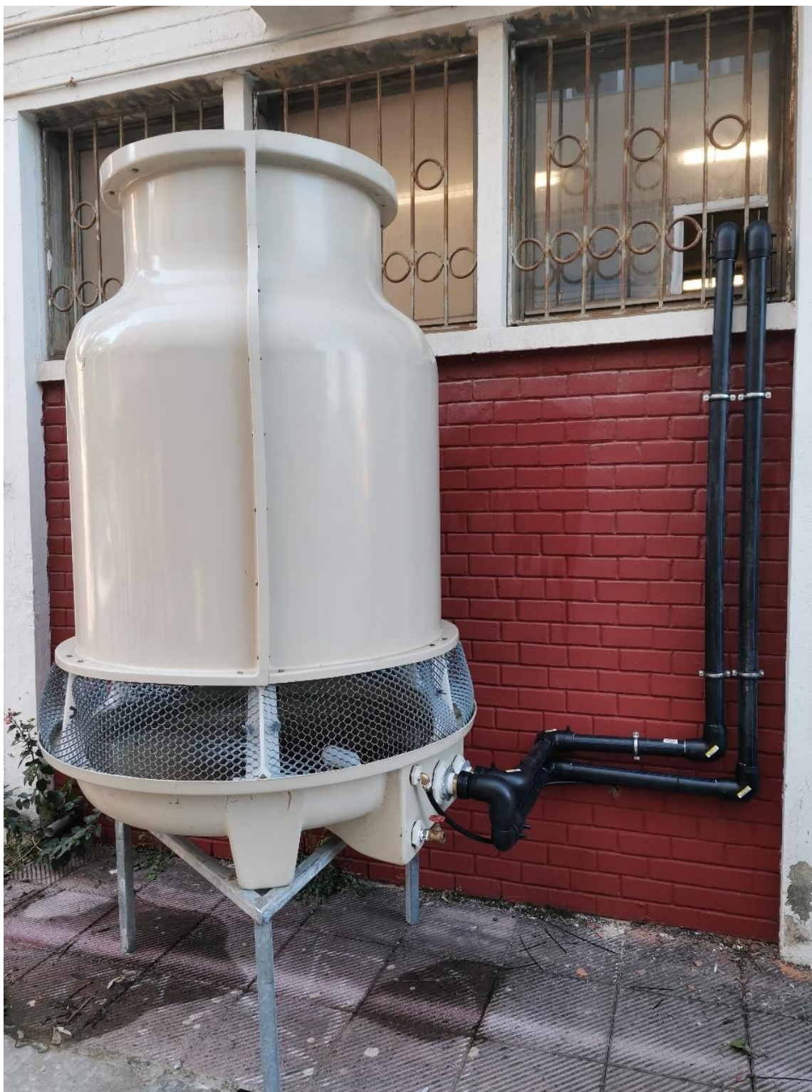
Εικόνα 3.17: Πύργος ψύξης νερού συμπυκνωτή
