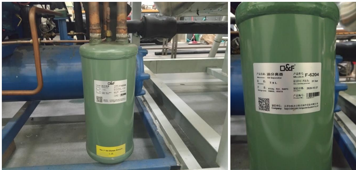
Εικόνα 3.14: Δοχείο λαδιού συμπιεστή
