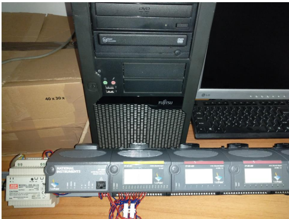
Εικόνα 4.1 Εξοπλισμός αυτομάτου ελέγχου λειτουργίας της μονάδας κρυοξήρανσης
