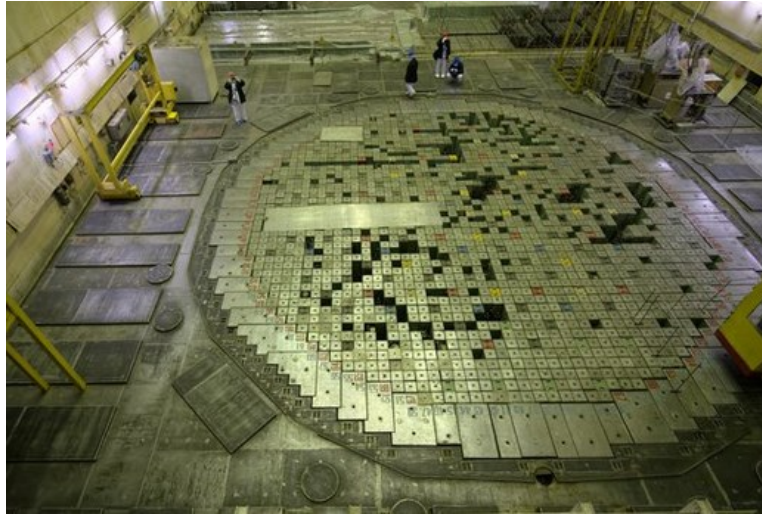
Εικόνα 5.11: Κάλυμμα πυρήνα αντιδραστήρα RBMK-1500
