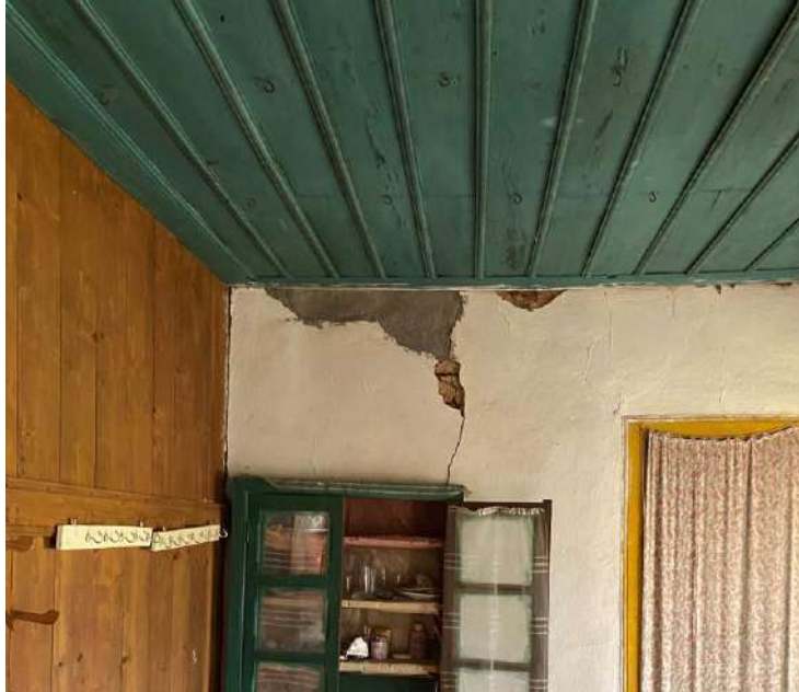
Εικόνα 29. Φθορές επιχρισμάτων.
