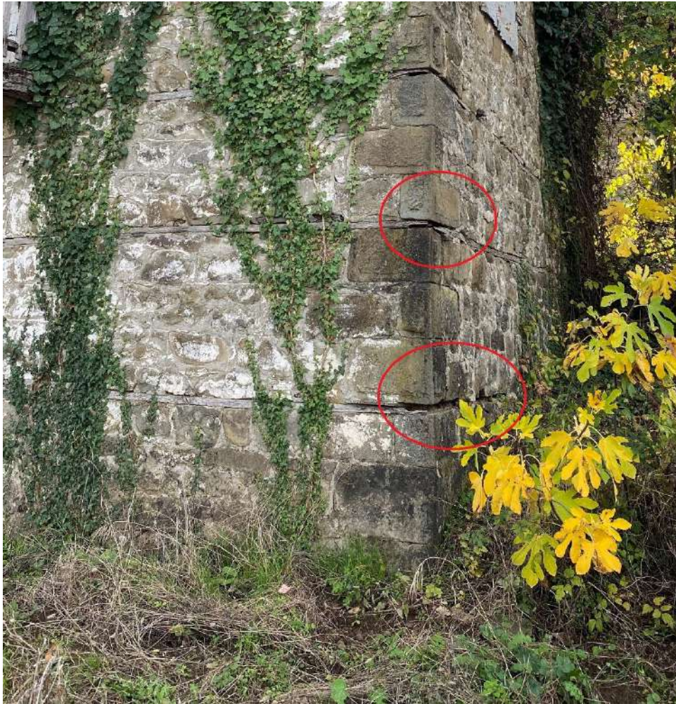
Εικόνα 23. Φθορά ξύλινων στοιχείων τοιχοποιίας.
