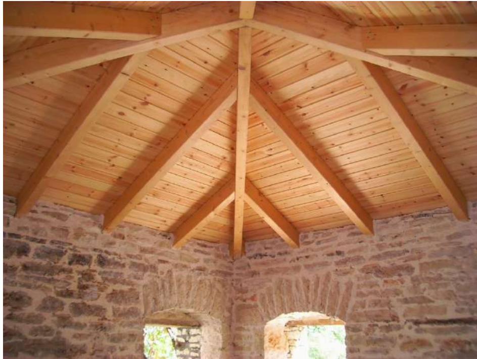
Εικόνα 40. Όψη εμφανούς στέγης, εσωτερικά.
