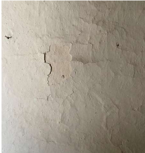
Εικόνα 31. Φθορές επιχρισμάτων.
