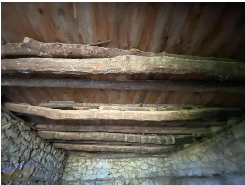
Εικόνα 8. Στήριξη μεσοπατώματος.
