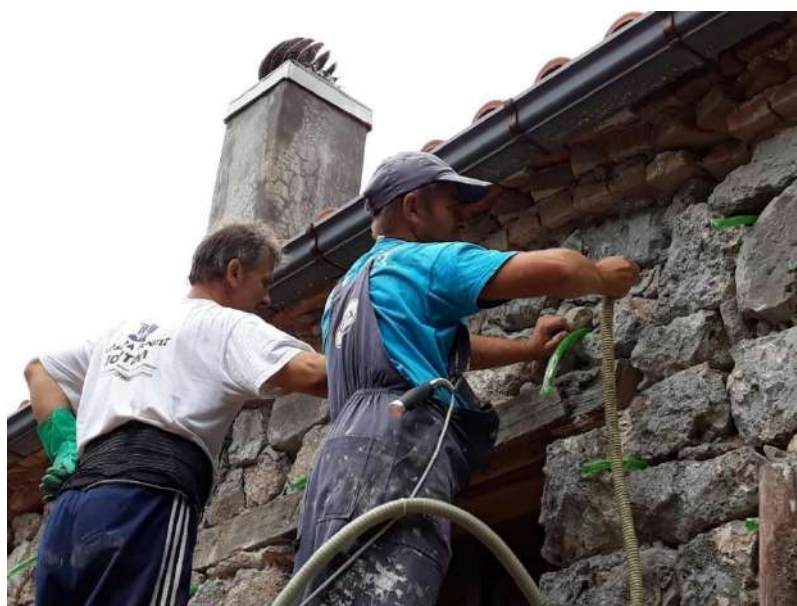
Εικόνα 36. Αρμολόγηση τοιχοποιίας.
