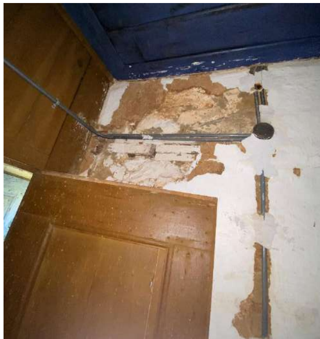
Εικόνα 30. Φθορές επιχρισμάτων.
