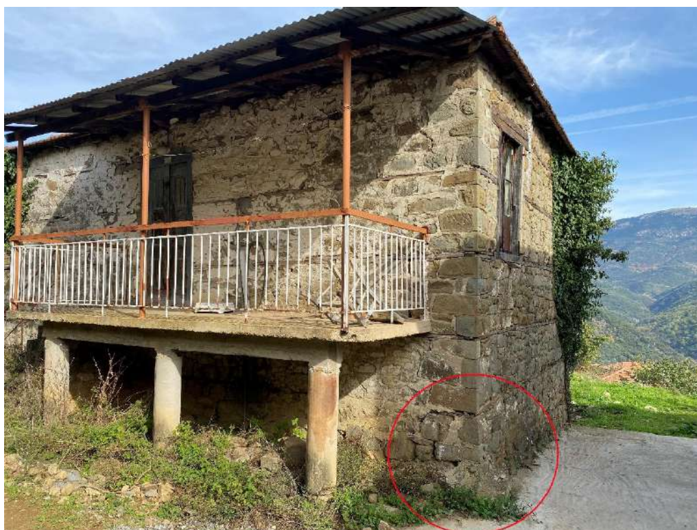
Εικόνα 21. Πρόβλημα θεμελίωσης στη δεξιά πλευρά της πρόσοψης.
