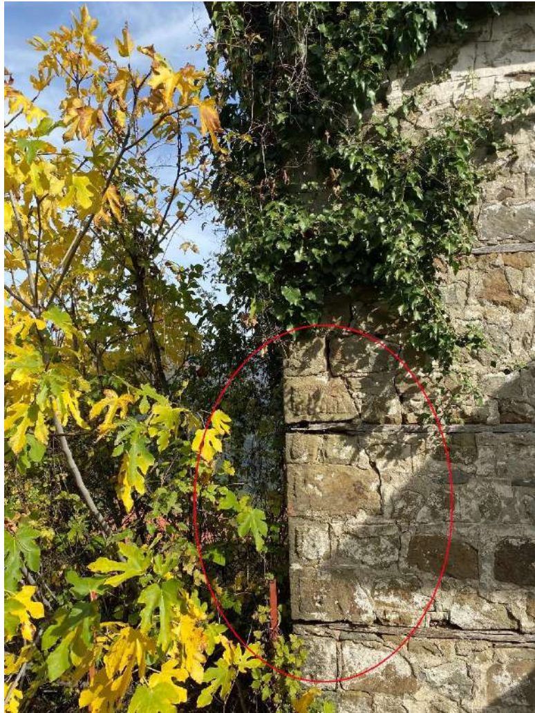
Εικόνα 22. Εμφανής ρηγμάτωση στη αριστερή γωνία της πρόσοψης.
