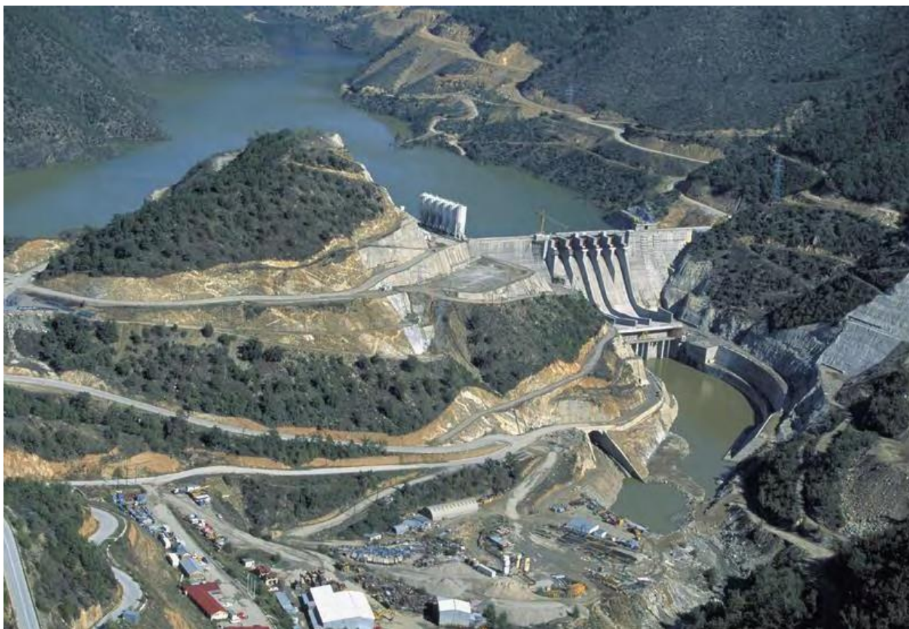
Αεροφωτογραφία ΥΗΣ Θησαυρού – Πλατανόβρυσης
