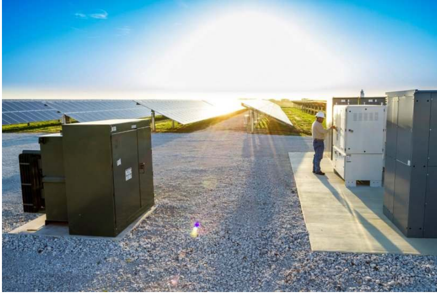
Εικόνα 3-3 Ένας εργαζόμενος ελέγχει έναν μετατροπέα στον ηλιακό σταθμό CoServ ισχύος 2 MW στο Krugerville του Τέξας. ( https://www.energy.gov/eere/solar/solar-integration-inverters-and-grid-services-basics )
