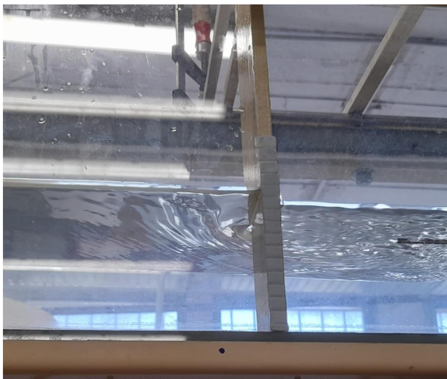
Εικόνα 4.2: Τοποθέτηση αυτοκόλλητων στηριγμάτων.
