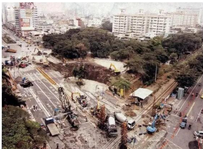
Εικόνα 4.40: Ζημίες που προκλήθηκαν από την κατάρρευση σήραγγας – Δεκέμβριος 2005
