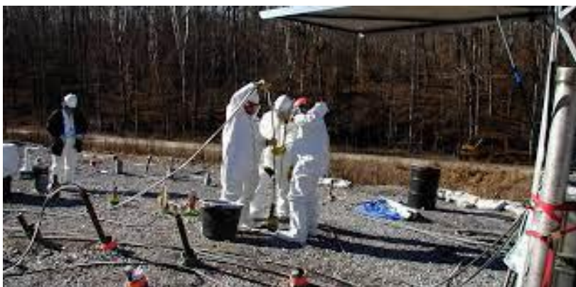
Εικόνα 3.20: Τοποθέτηση χημικών ενεμάτων
