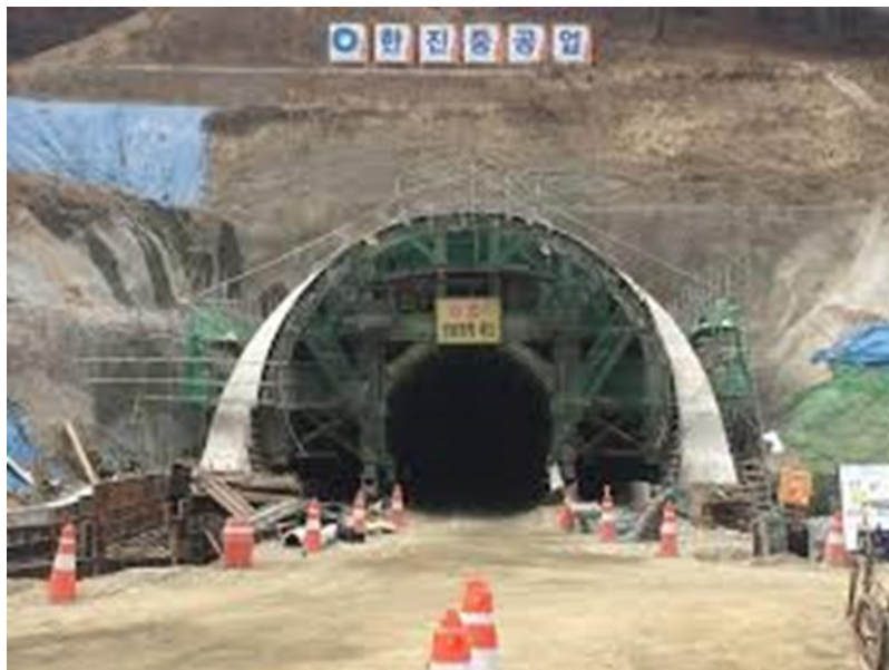
Εικόνα 1.12: Κατασκευή σήραγγας με την μέθοδο NATM
