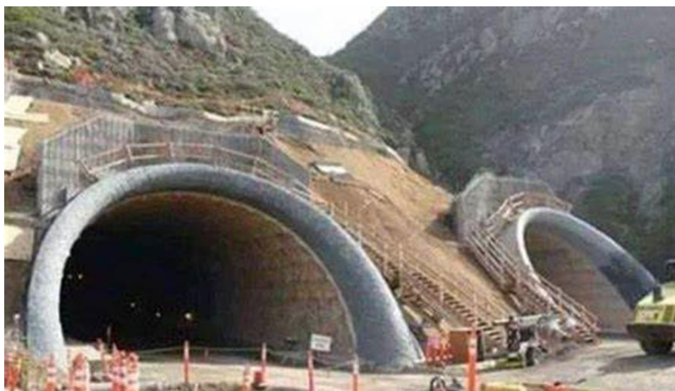
Εικόνα 4.8: Κατασκευή σήραγγας Χόλμεστραντ - Δεκέμβριος 1981
