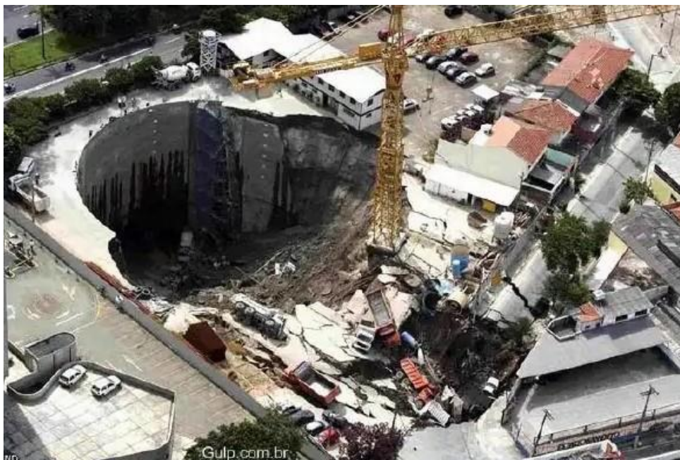
Εικόνα 4.45: Κατάρρευση σήραγγας Σάο Πάολο – Ιανουάριος 2007
