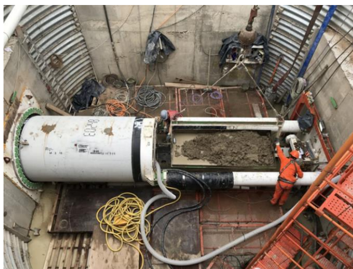
Εικόνα 2.4: Μηχανή διάνοιξης μικρών διαμέτρων (Micro-TBM)
