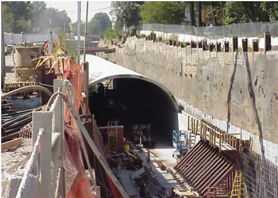
Εικόνα 1.1: Κατασκευή σήραγγας με την μέθοδο Cut and Cover σε ακατοίκητη περιοχή
