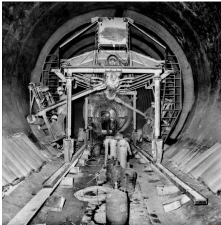
Εικόνα 4.7: Κατασκευή μετρού στο Μοναχό το 1980
