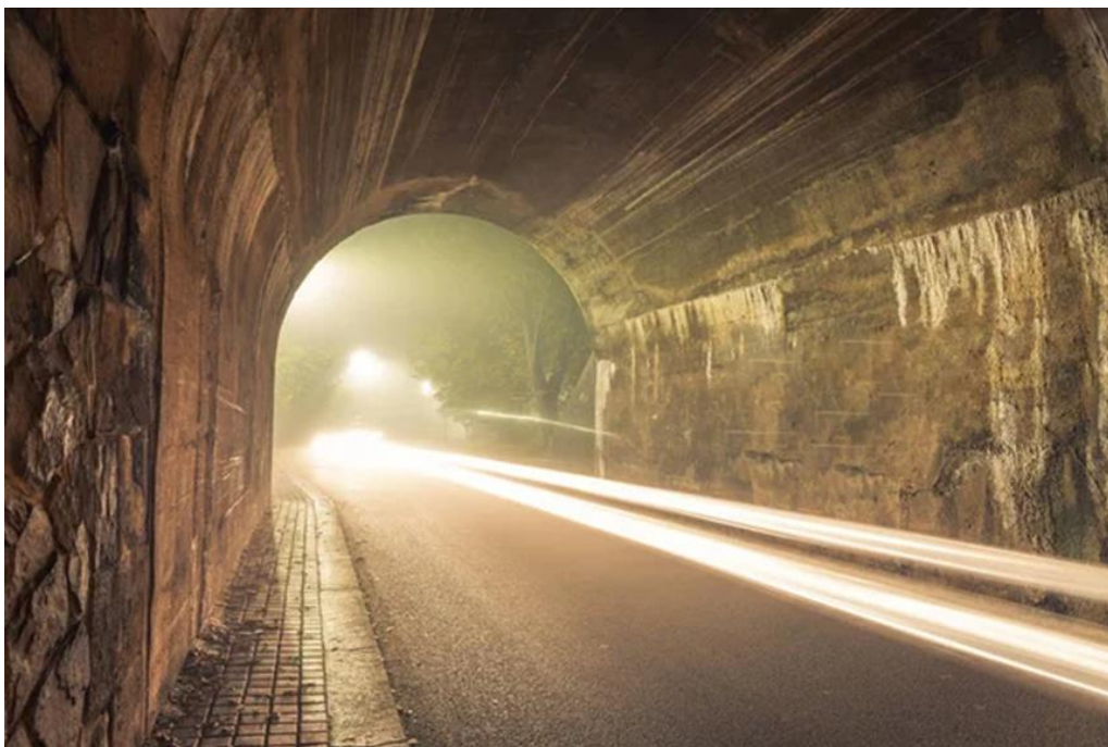
Εικόνα 3.11: Θολωτή οροφή σήραγγας
