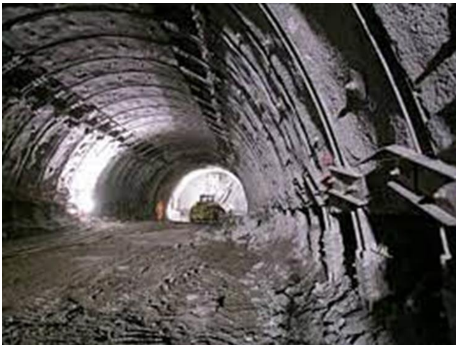
Εικόνα 3.4: Χαλύβδινα τόξα
