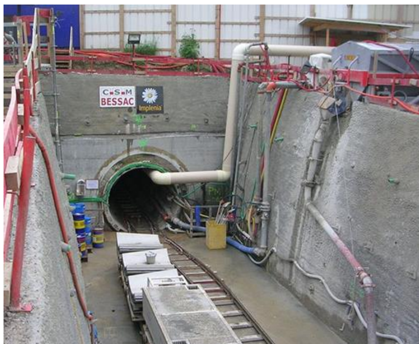
Εικόνα 4.23: Κατασκευή του σήραγγα λυμάτων
