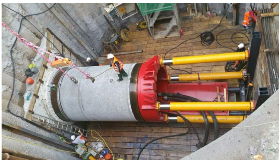
Εικόνα 2.3: Μέθοδος ανύψωση σωλήνων
