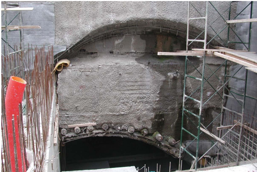
Εικόνα 3.34: Δοκίδες προπορείας
