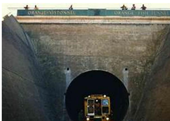
Εικόνα 4.5: Orange-fish Tunnel - Νότια Αμερική 1970
