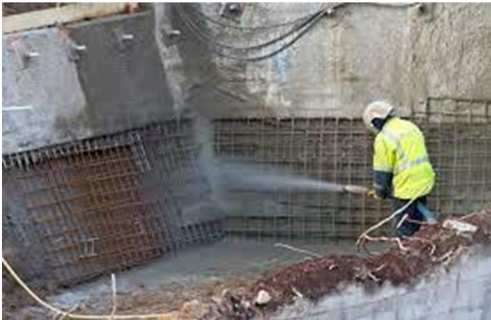
Εικόνα 3.7: Εκτοξευόμενο σκυρόδεμα
