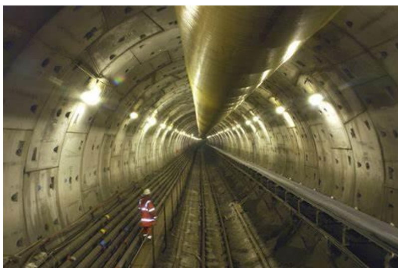
Εικόνα 4.27: Σιδηροδρομικός σύνδεσμος σήραγγας
