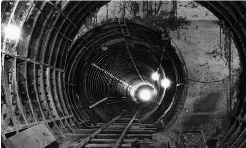
Εικόνα 4.2: Υπό κατασκευή σήραγγας Γραμμή Victoria – UK 1965
