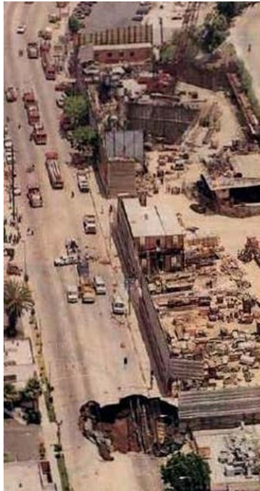
Εικόνα 4.18: Κατασκευαστική αστοχία μετρό Λος Άντζελες – Ιούνιος 1995
