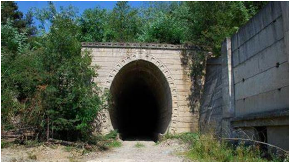
Εικόνα 4.9: Σιδηροδρομική σήραγγα Γκιμπέι – 1985
