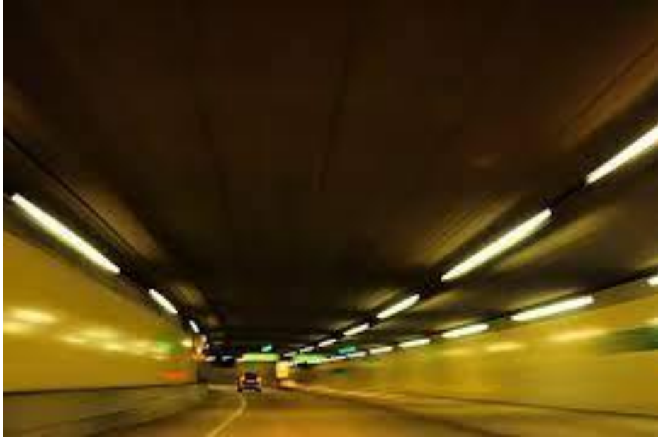
Εικόνα 4.44: Σήραγγα SMART – Δεκέμβριος 2006
