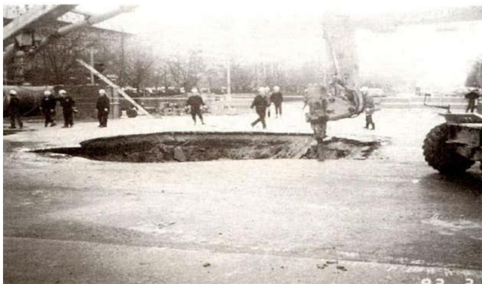
Εικόνα 4.13: Κατασκευαστική αστοχία μετρό Σεούλ – Φεβρουάριος 1992
