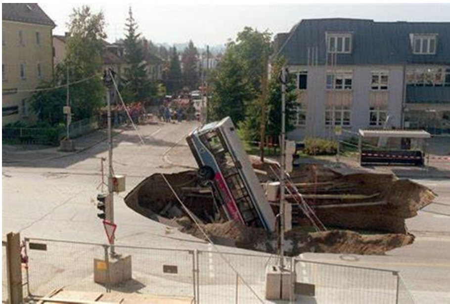
Εικόνα 4.16: Κατασκευαστική αστοχία μετρό Μονάχου – Σεπτέμβριος 1994
