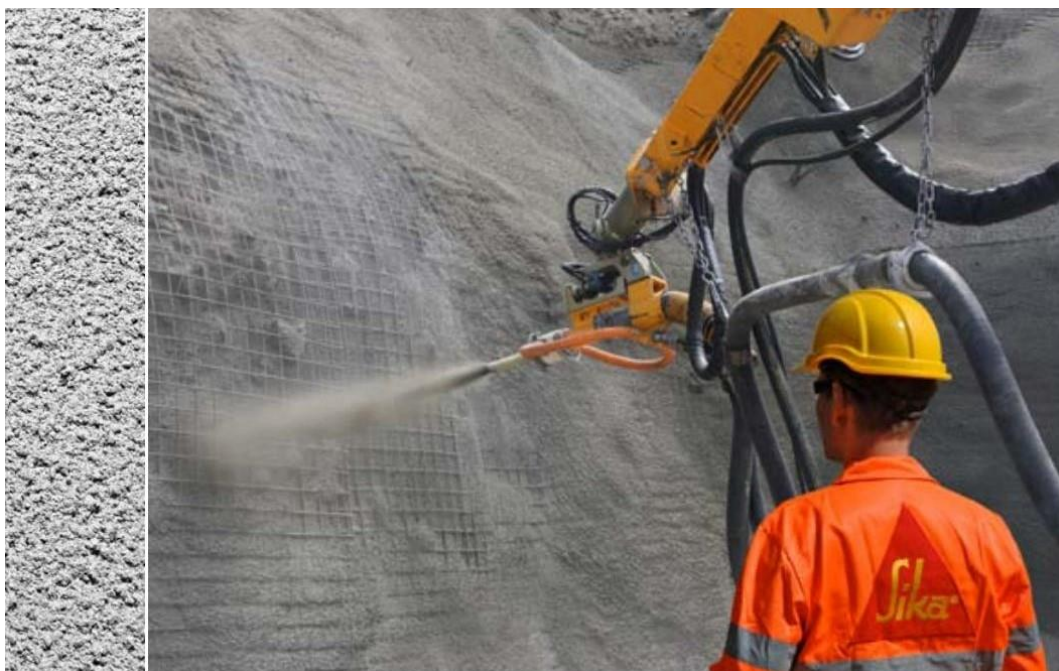
Εικόνα 3.6: Μανδύας εκτοξευόμενου σκυροδέματος
