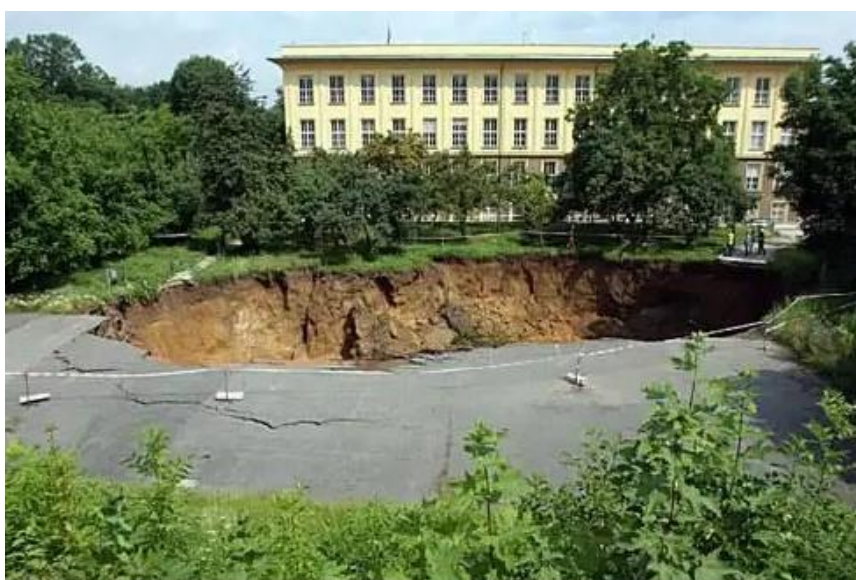
Εικόνα 4.56: Κατασκευαστική αστοχία που προκάλεσε η σήραγγα Μπλάνκα
