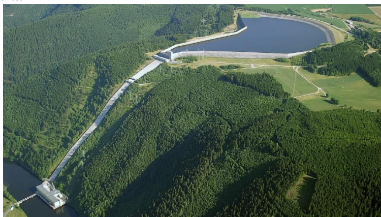
Εικόνα (2.1.c) Τυπικός σταθμός αντλησιοταμίευσης [16]
