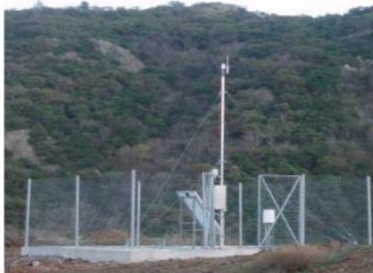
Εικόνα 32. Σύστημα αισθητήρα σε φράγμα (2)
