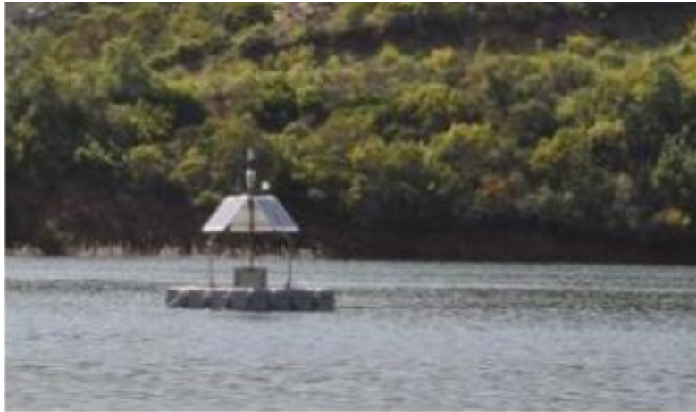
Εικόνα 31. Σύστημα αισθητήρα σε φράγμα (1)
