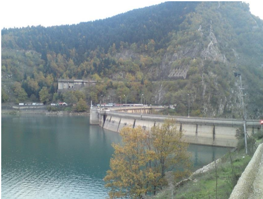
Εικόνα Ε4: Υδροηλεκτρικό εργοστάσιο λίμνης Πλαστήρα
