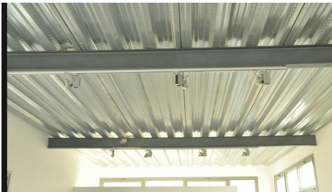
Σχήμα 60, Φωτογραφική απεικόνιση σύμμεικτης πλάκας.
