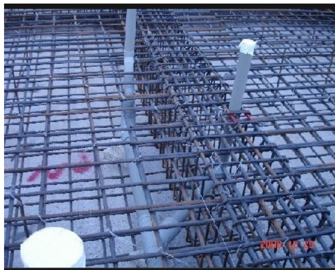
Σχήμα 17, Γενική κοιτόστρωση και αποχετεύσεις με την μέθοδο ντουλαπιών.
