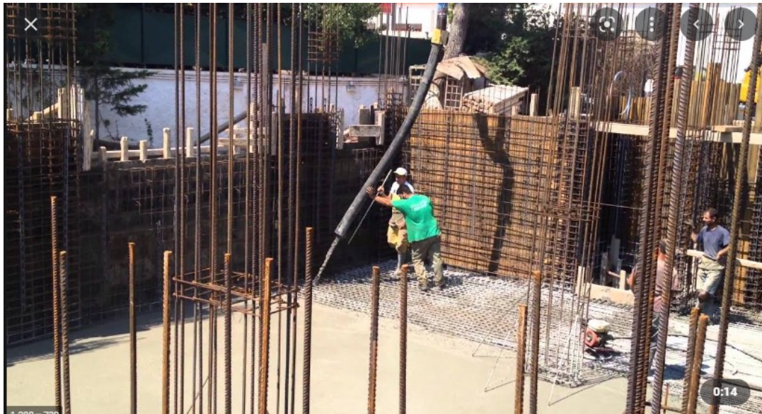
Σχήμα 16, Γενική κοιτόστρωση, σκυροδέτηση συνολικά με χρήση δονητή και πρέσας.
