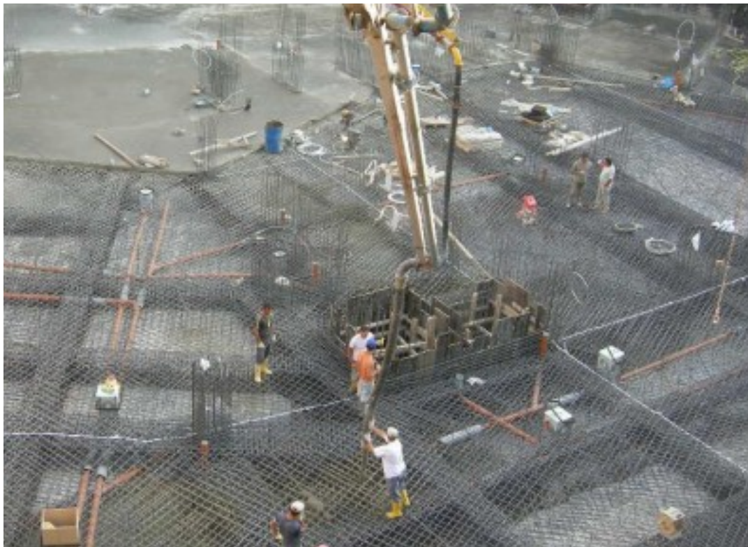
Σχήμα 15, (γενική άποψη σκυροδέτησης γενικής κοιτόστρωσης με συνδετήριους δοκούς σε έργο.
