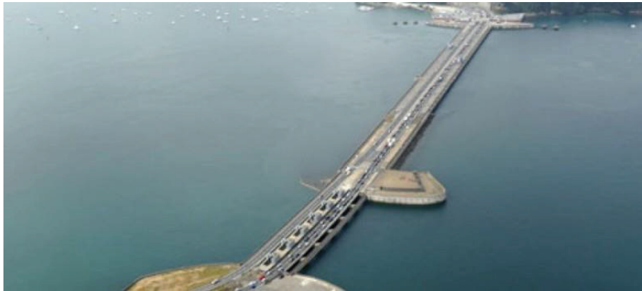
Εικόνα 13: Σταθμός εκμετάλλευσης της παλίρροιακής ενέργειας στον ποταμό Rance, Γαλλία (Πηγή: Rance Tidal Power Station, France - TheGreenAge)
