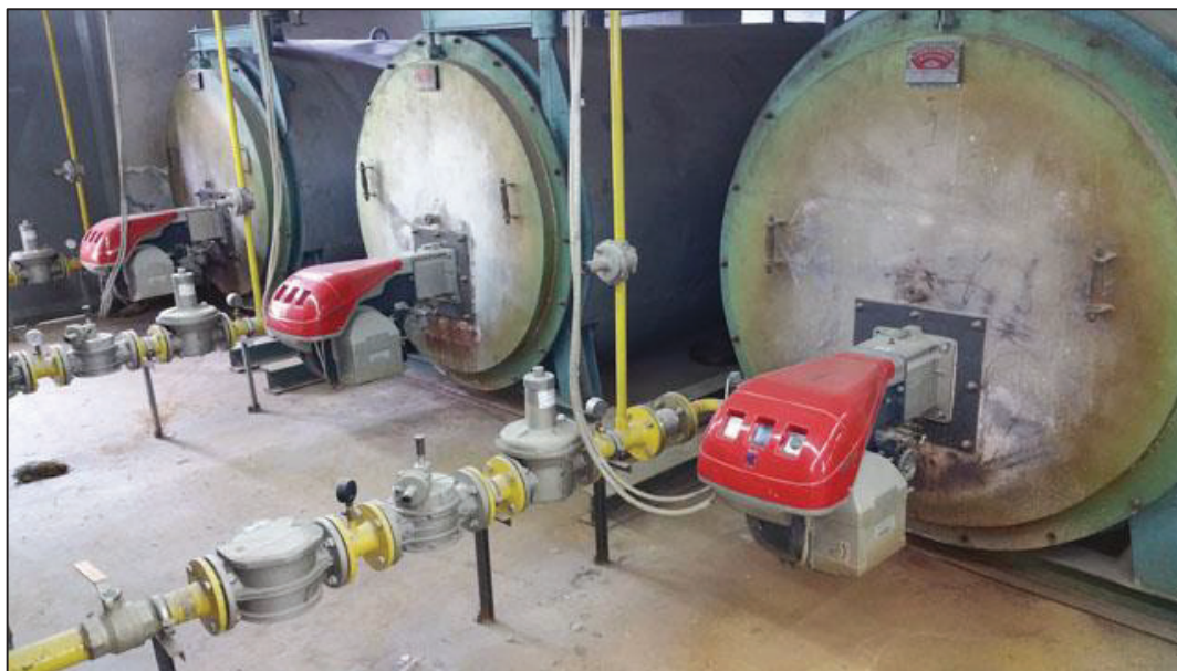
Εικόνα 1: Καυστήρας φυσικού αερίου [Πηγή: Επισκευές – Συντήρηση Καυστήρων Φυσικού Αερίου | GAS SERVICE (sintirisi-kaustiron.gr) ]
