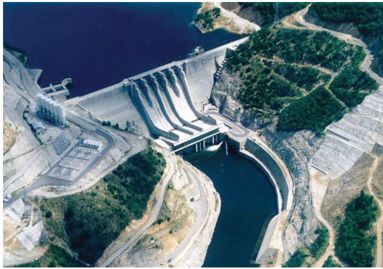
Εικόνα 12: Υδροηλεκτρικό εργοστάσιο στον ποταμό Αχελώο
