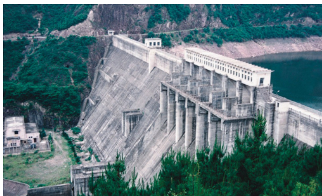
Εικόνα 7: Παράδειγμα τύπου φράγματος βαρύτητας
